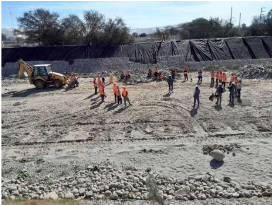
Fig. 3: Encauzamiento del río Ica
