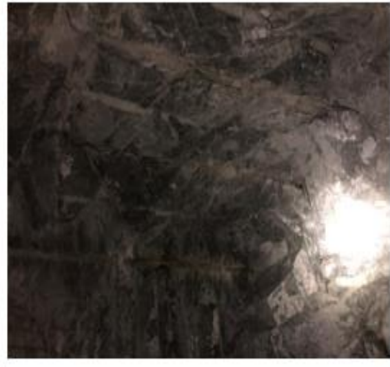
Resultados post voladura presencia de medias cañas
