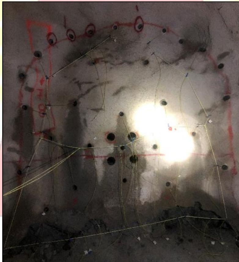
Figura 2. Carguío y amarre de explosivos GL9143 2.4x2.7 – 8 pies
