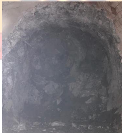
Figura 9. Resultados de voladura GL 10455-S 2.4 x 2.7 – 8 pies
