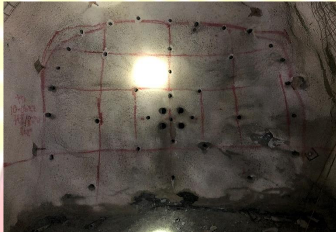
Figura 11. Marcado y perforación de malla XC 10362 SE 3.5m x 3.0m
