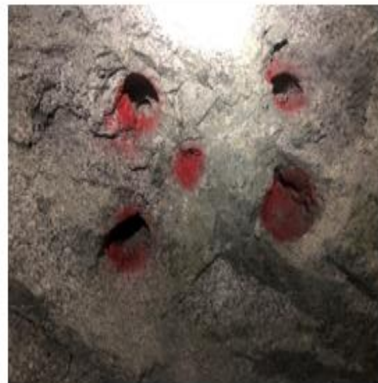
Controlando la sección con el correcto pintado de malla de perforación
