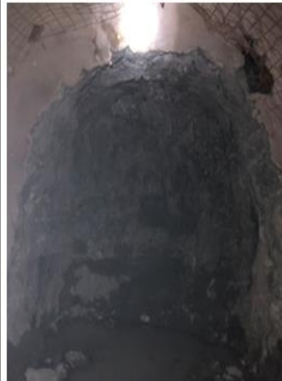
Resultados post voladura, sección controlada
