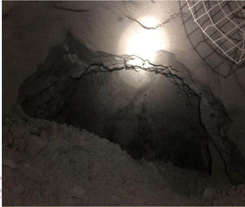
Figura 3. Resultados de voladura GL9143 2.4x2.7 – 8 pies
