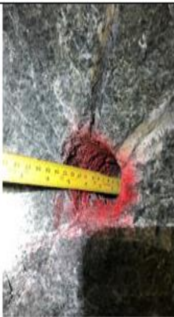
Controlando la sección con el correcto pintado de malla de perforación
