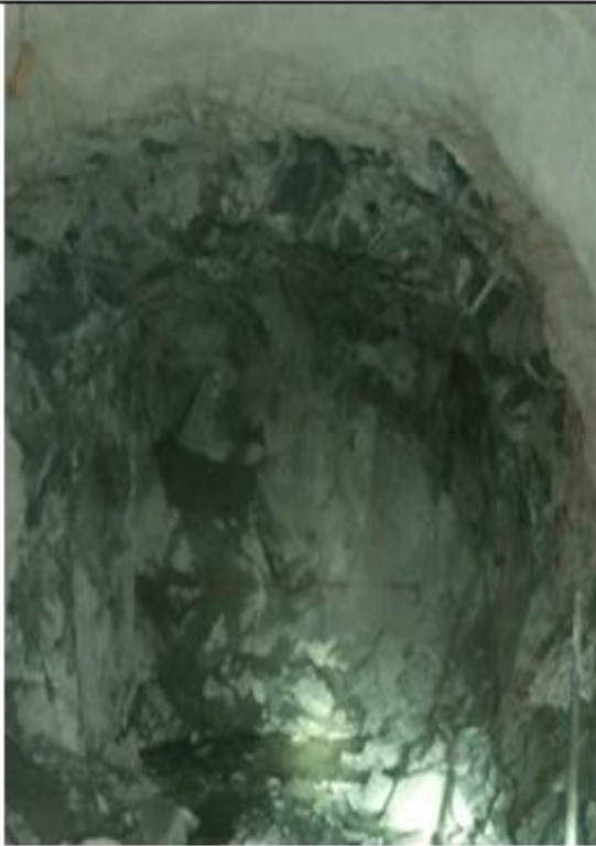
Resultados post voladura, sección controlada
