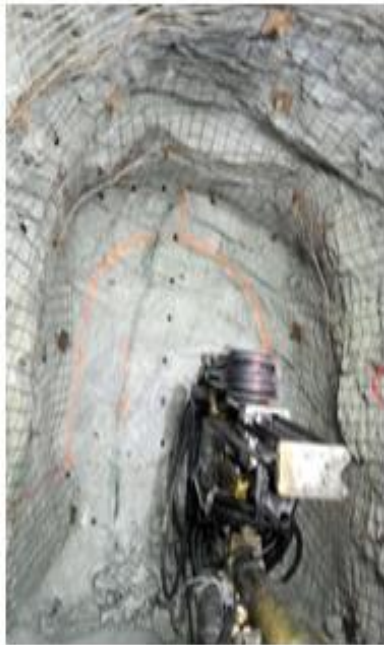
Controlando la sección con el correcto pintado de malla de perforación
