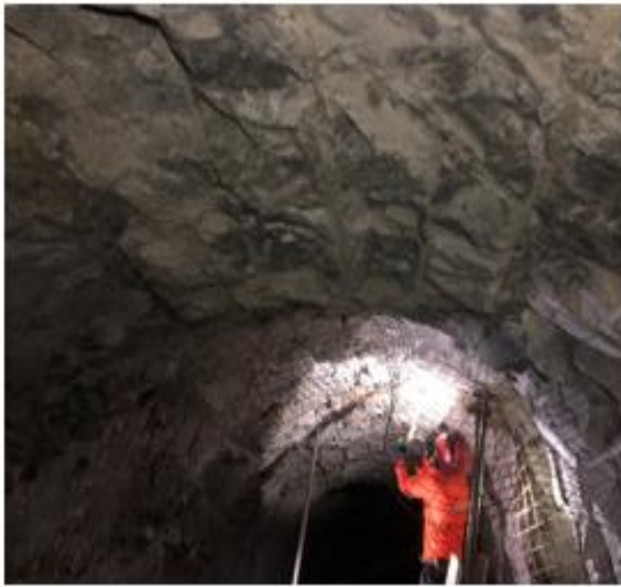
Resultados post voladura presencia de medias cañas
