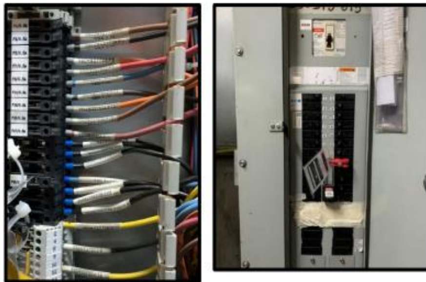
Fig. 19 Conexión de señales (izq.), conexión de alimentación (der.)
