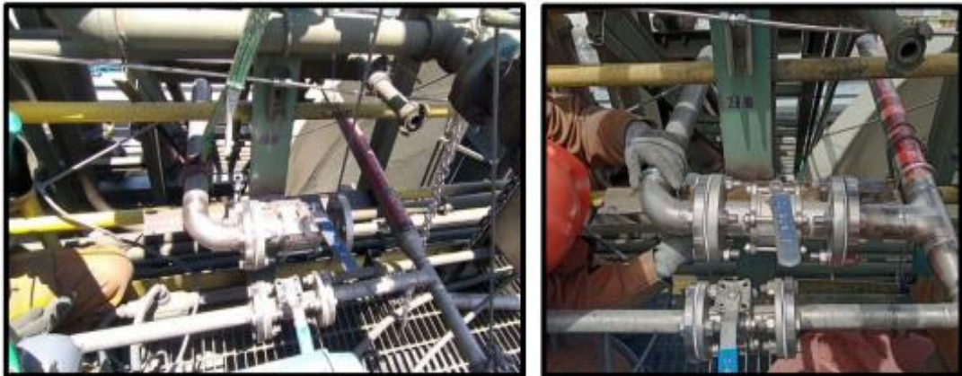
Fig. 15 Fijación de tubería Inox (izq.). Tubería Inox terminada (der.).
