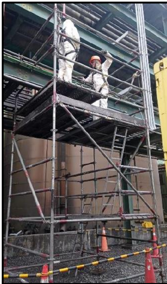
Fig. 17 Montaje de andamios.
