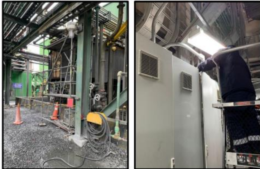
Fig. 18 Andamios para canalización (izq.). Perforación de tableros (der.).
