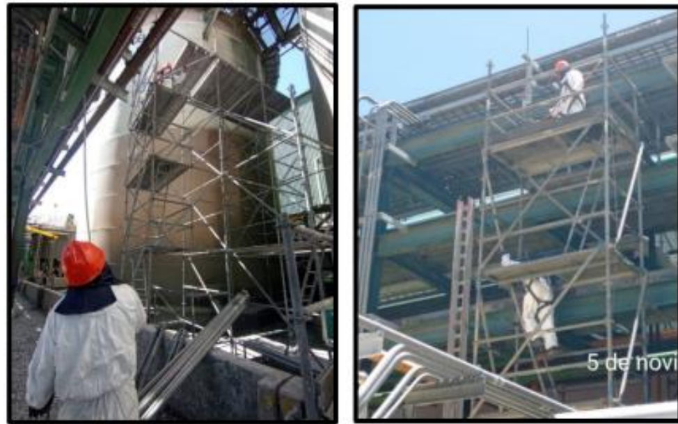
Fig. 13 Izaje de tuberías Inox.
