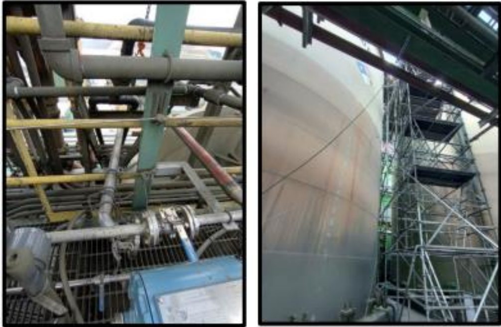
Fig. 14 Tuberías izadas (izq.). Soldeo de tuberías Inox (der.)
