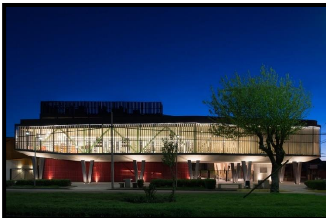
Ilustración 2. Fachada del centro Cultural
