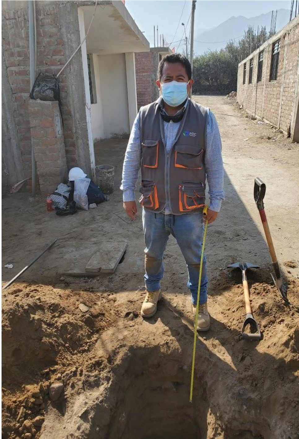
Figura. 30 Calicata N°02 - Calle San Francisco, Caserío de Trapiche
