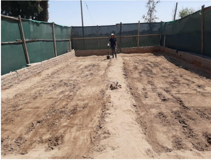
Figura 2. Preparación y nivelado del terreno
