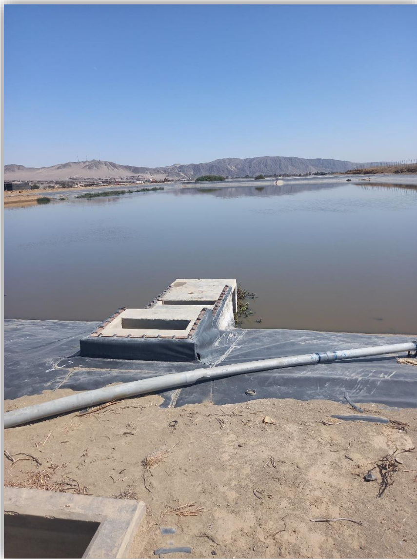
Foto 08: Instalación de paso a la segunda laguna
