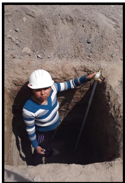
Fig. N° 07 Exploración de Calicata N°01
