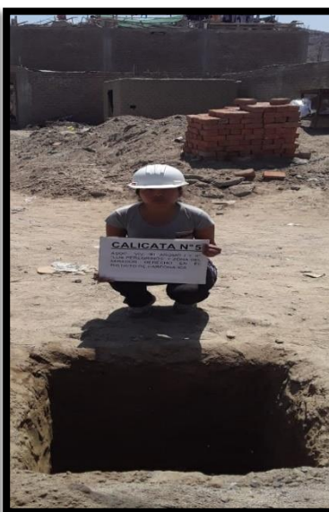
Fig. N° 11 Exploración de Calicata N°05
