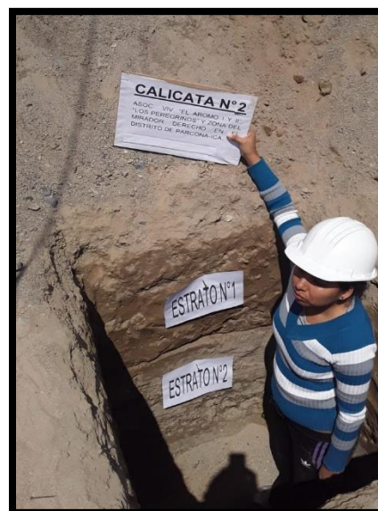
Fig. N° 08 Exploración de Calicata N°02
