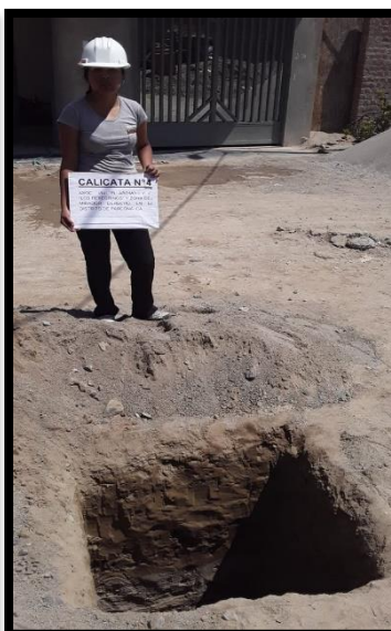
Fig. N° 10 Exploración de Calicata N°04
