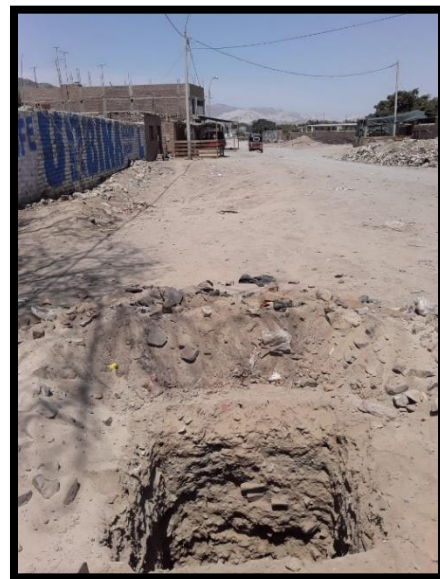
Fig. N° 15 Exploración de Calicata N°04
