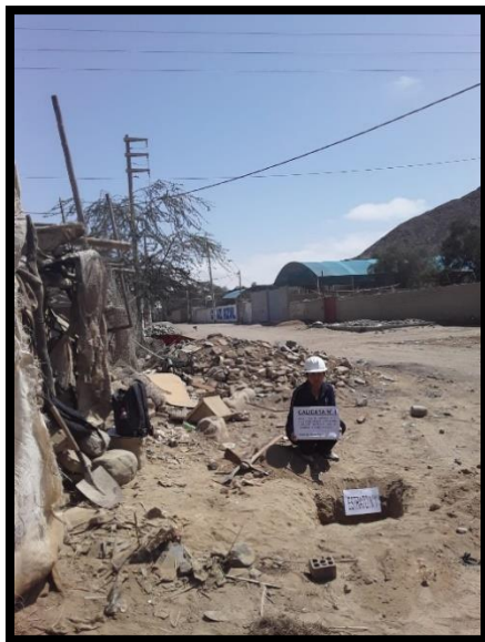
Fig. N° 14 Exploración de Calicata N°03
