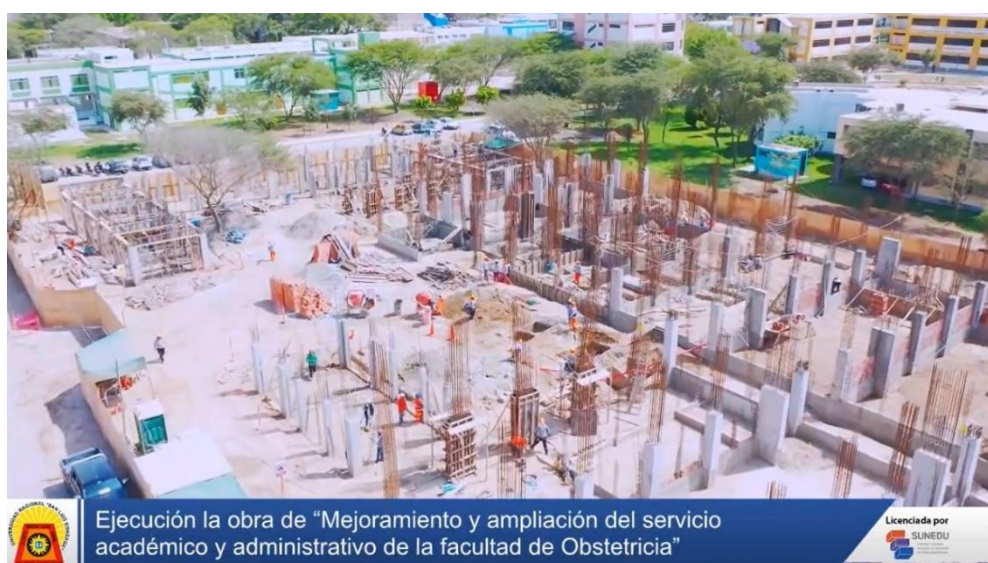
Figura 4: obra de “Mejoramiento y ampliación del servicio académico y administrativo de la facultad de Obstetricia”
