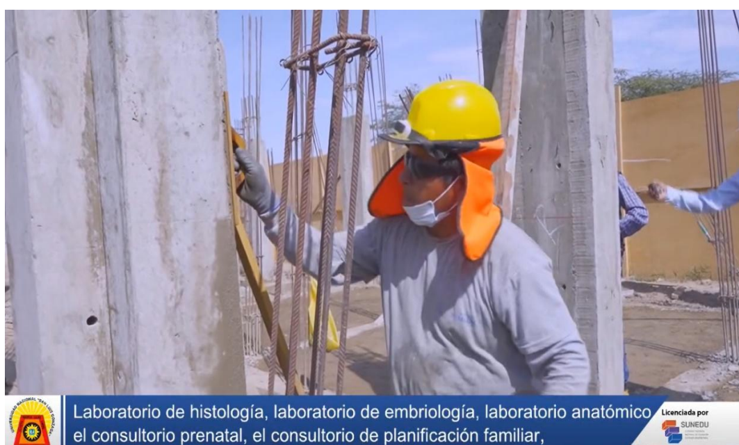
Figura 6: Obra Facultad de Obstetricia, laboratorios
