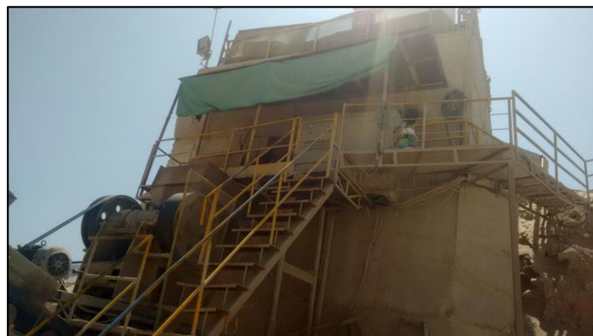
Fig. 67. Lugar de inspección de la máquina chancadora
