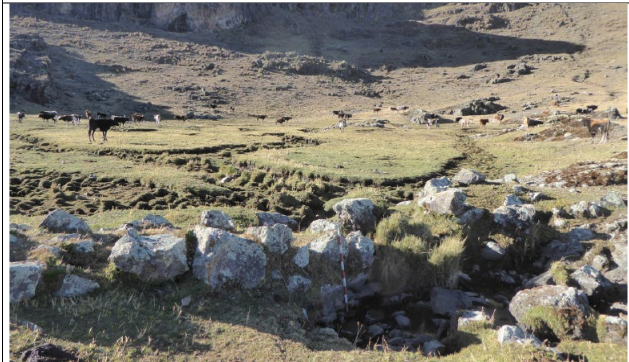
Foto 04: Dique de la represa de limo CA-7 en la quebrada Capado. Fuente: Jesús Maza y Andy Combey; 2020: 551
