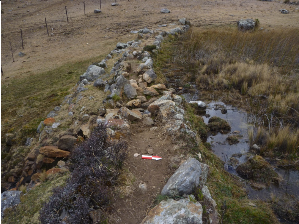
Foto 05: Cuarto dique de la represa Yanacancha
