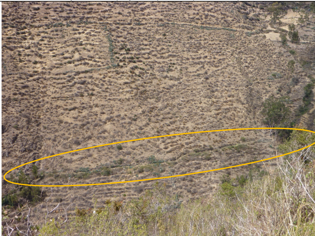
Foto 09: Vista general del canal excavado en la ladera sobre superficie arcillosa. Nótese la ligera inclinación del canal.
