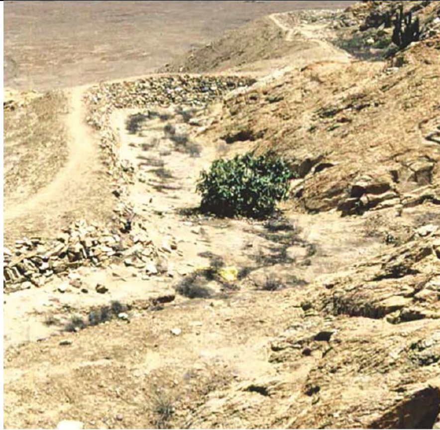
Foto 10: Vista del canal construido sobre nivel en la ladera rocosa. Nótese la ligera inclinación del canal.
