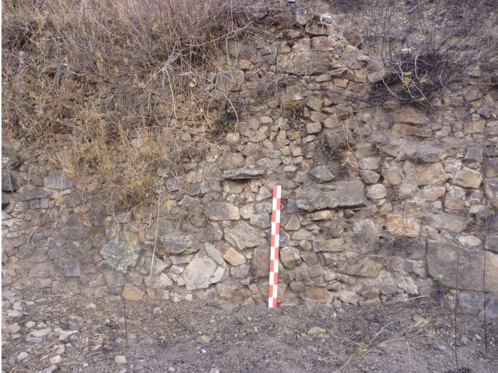
Foto 16: Escalera en voladizo vista en uno de los paramentos de los andenes.
