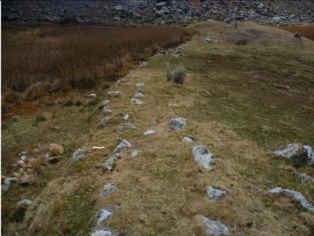
Foto 01: Primer dique de la represa Yanacancha
