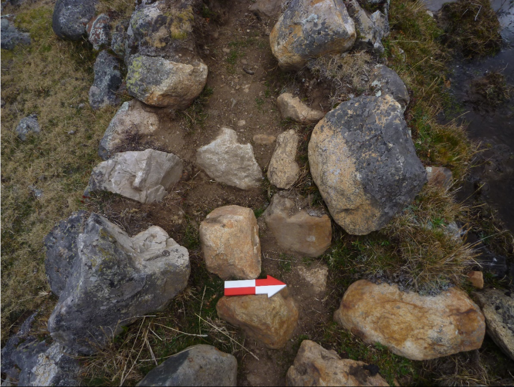
Foto 07: Técnica constructiva en los muros de los diques.
