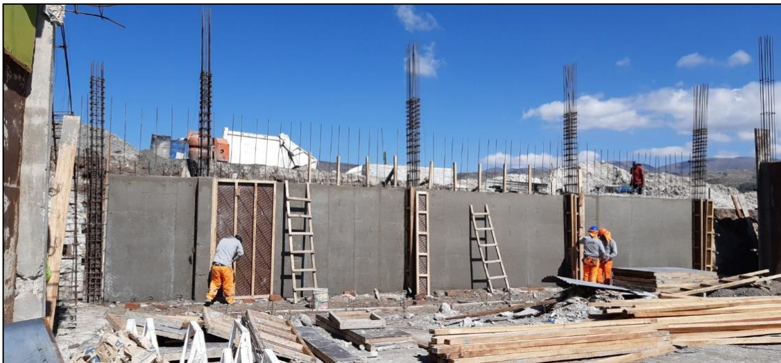
Fig. 28. Vista panorámica de muro de contención
