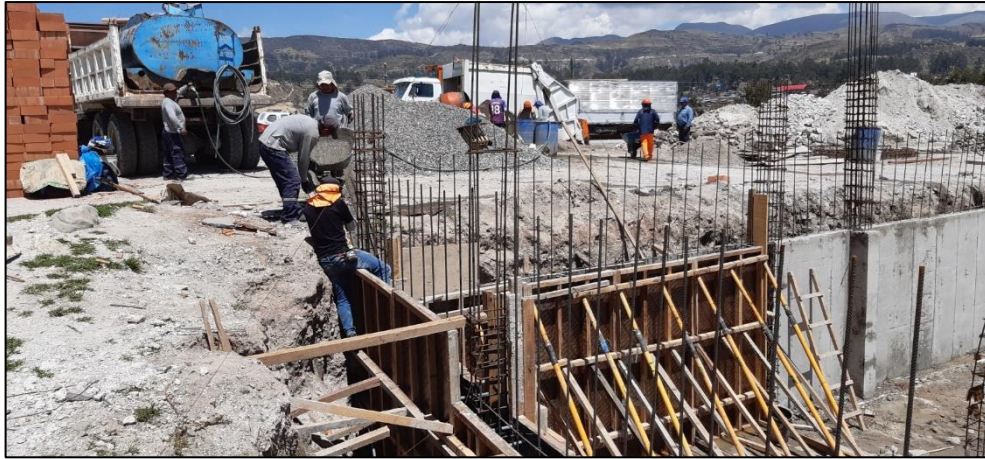
Fig. 21. Encofrado de muros de contención armados
