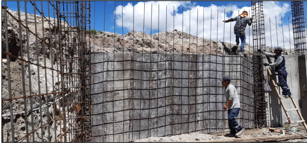
Fig. 24. Armado de acero de muro de contención y columnas
