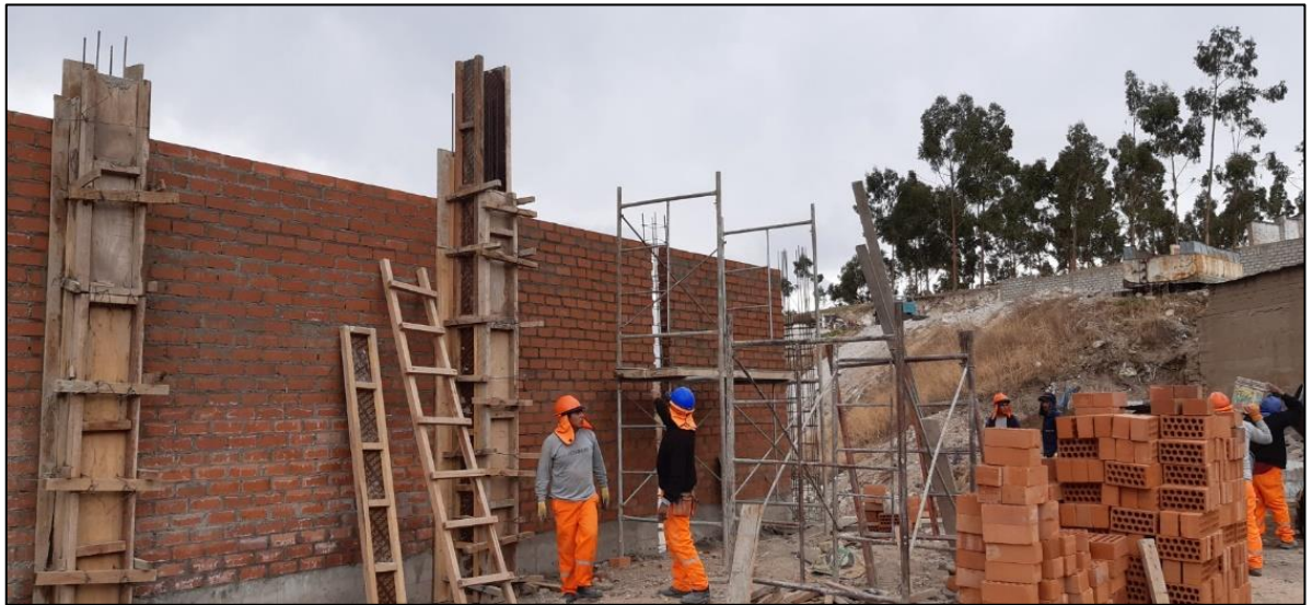
Fig. 20. Construcción de cerco perimétrico con ladrillo 18 huecos y vaciado de columnas
