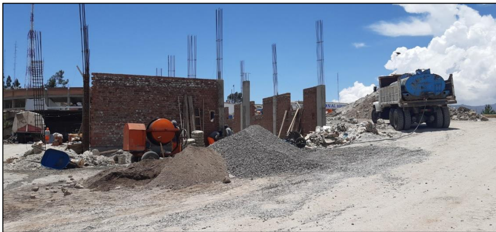
Fig. 22. Vista frontal de la construcción
