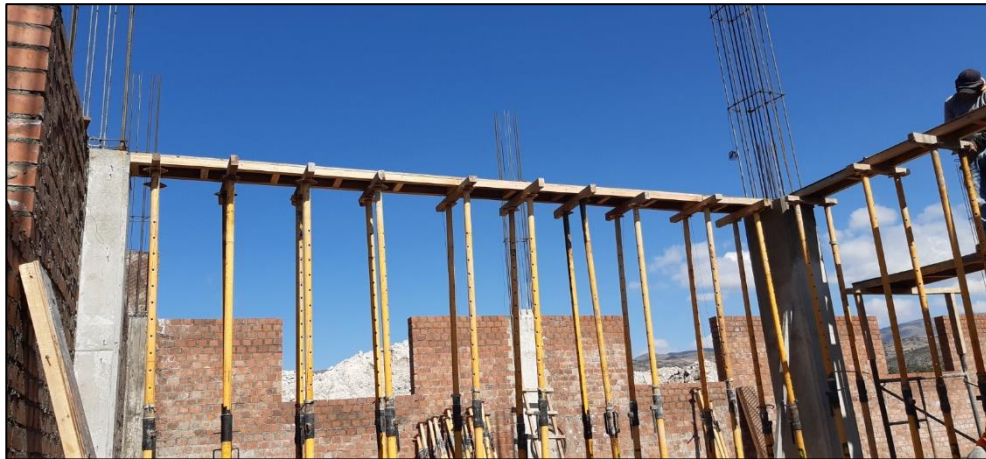
Fig. 25. Encofrado de techo, colocación de puntales
