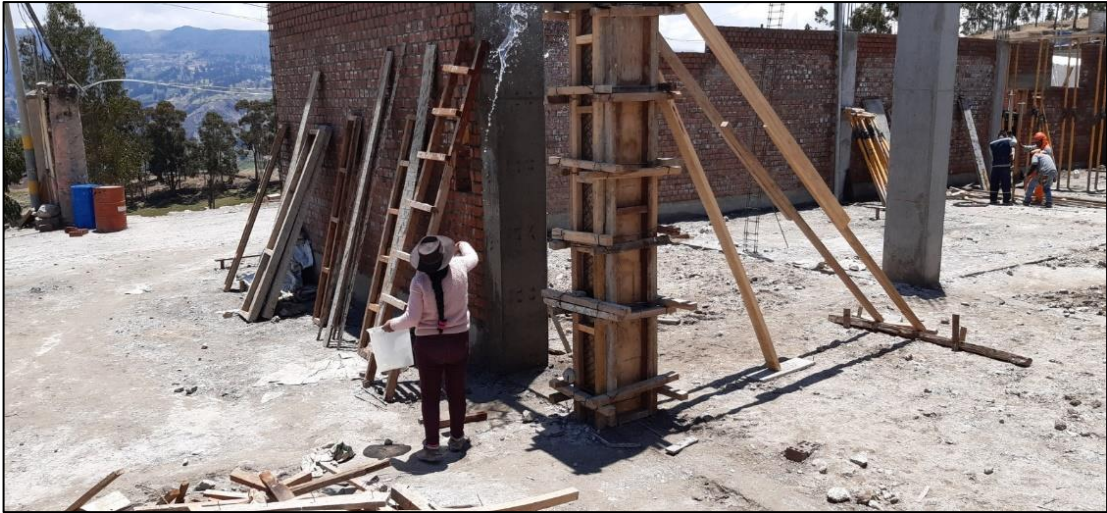
Fig. 27. Curado de columnas de concreto armado.
