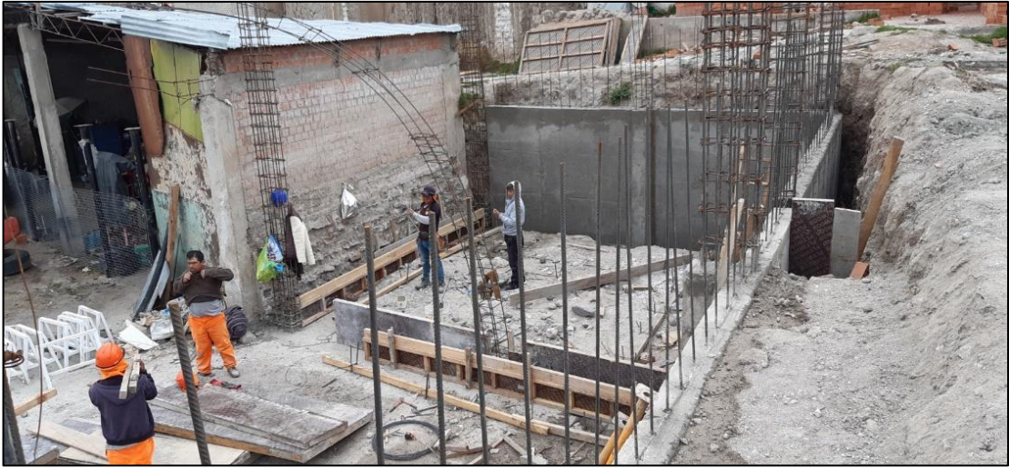
Fig. 19. Construcción de muros de contención, armado de columnas y encofrado
