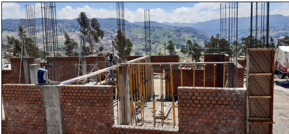
Fig. 26. Encofrado de techo, colocación de puntales
