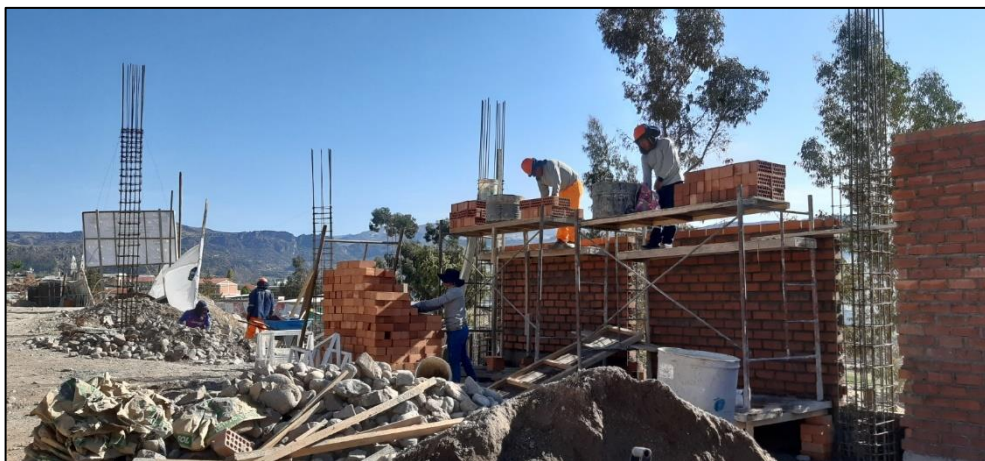
Fig. 23. Construcción de cerco perimétrico
