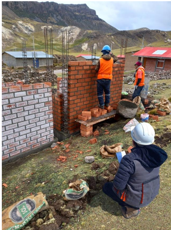
Figura 3 Actividad de llenado de juntas de mortero – Muestra N°02
