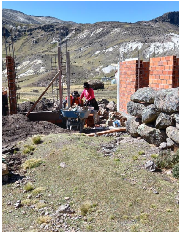
Figura 9 Actividad de preparar mortero – Muestra N°08
