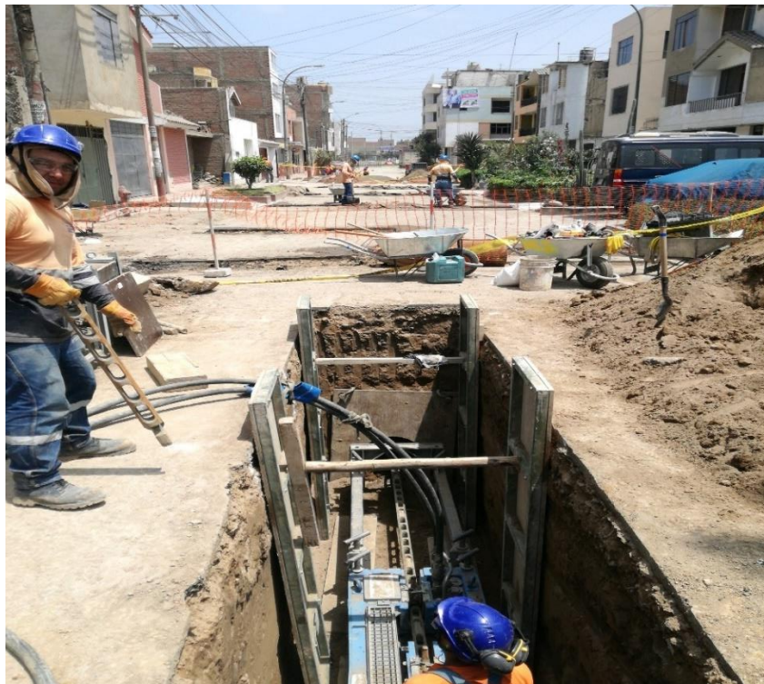
Figura. 39: Fragmentación de tubería de alcantarillado Fuente: Elaboración Propia
