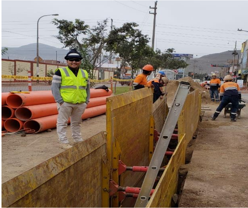
Figura. 62: Bachiller verificando trabajos de entibado en red de alcantarillado Fuente: Elaboración Propia
