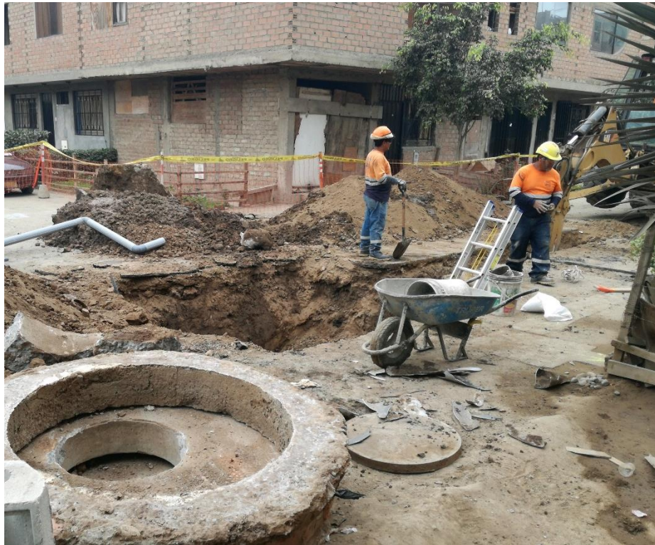
Figura. 46: Demolición de buzón de alcantarillado
