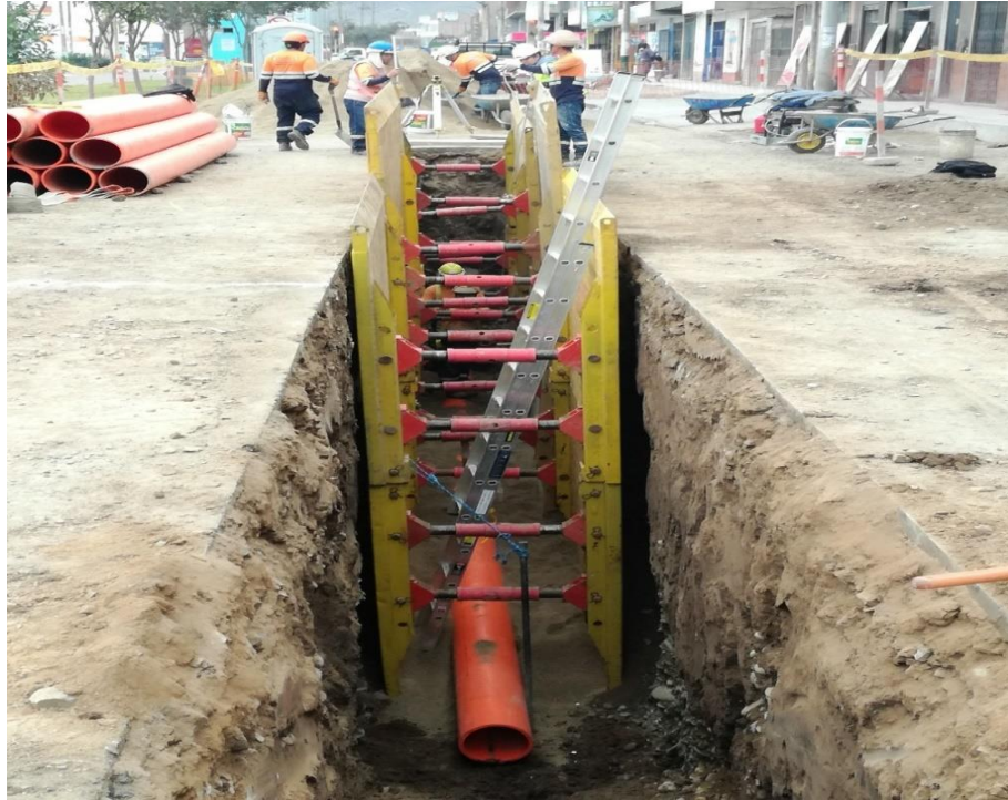
Figura. 25: Entibado metálico de zanja para red de alcantarillado sector 347
