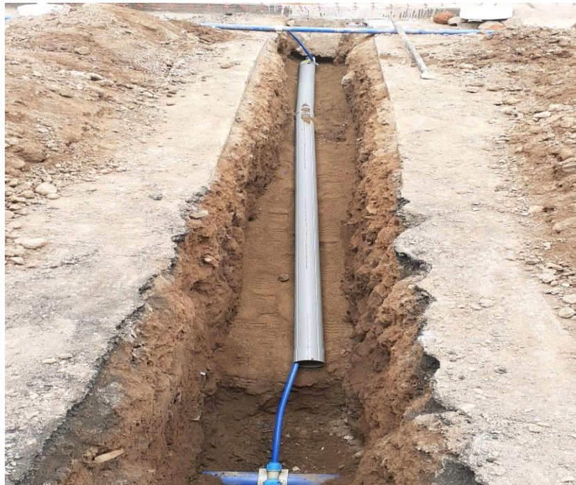
Figura. 20: Instalación de tubería de agua potable Fuente: Elaboración Propia
