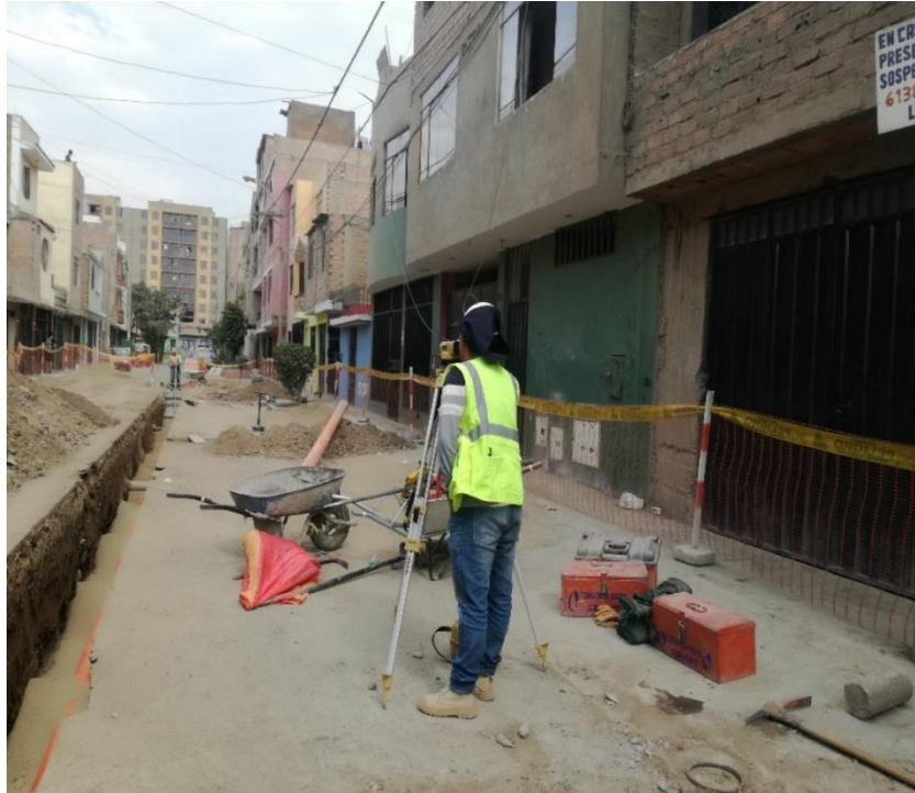
Figura. 29: Prueba hidráulica de nivelación a red de alcantarillado Fuente: Elaboración Propia
