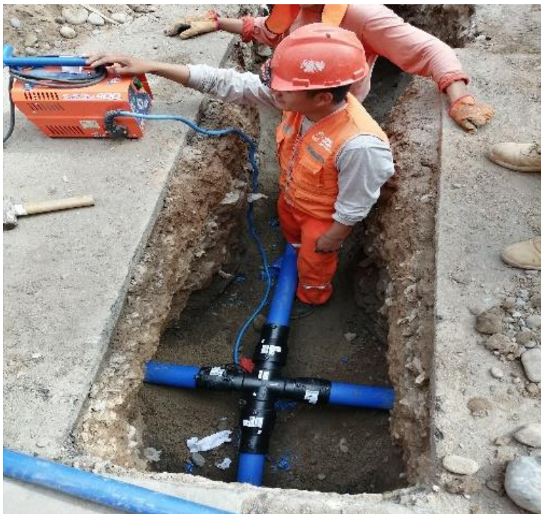
Figura. 16: Instalación de accesorios de agua potable por método de electrofusión Fuente: Elaboración Propia
