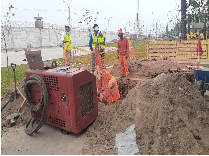
Figura. 13: Excavación de zanja para instalación de equipo de fragmentación Fuente: Elaboración Propia
