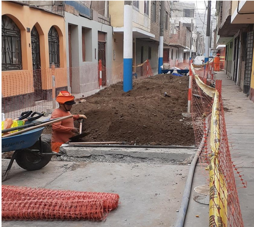
Figura. 8: Excavación de zanja
