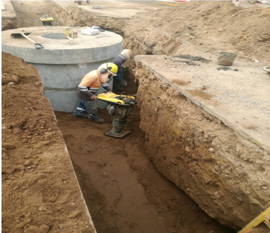
Figura. 31: Compactación de zanja de red de alcantarillado Fuente: Elaboración Propia
