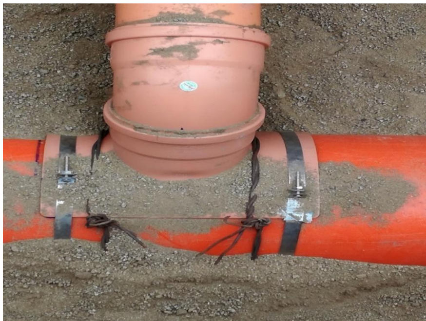
Figura. 43: Instalación de accesorios (cachimba) de alcantarillado
