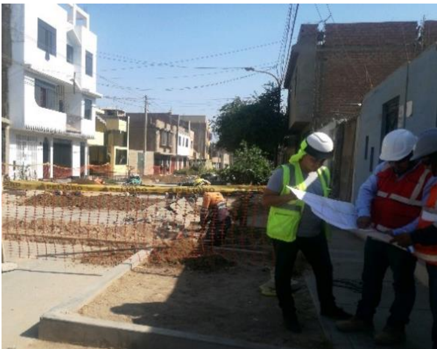
Figura. 59: Bachiller realizando verificación de planos de replanteo Fuente: Elaboración Propia
