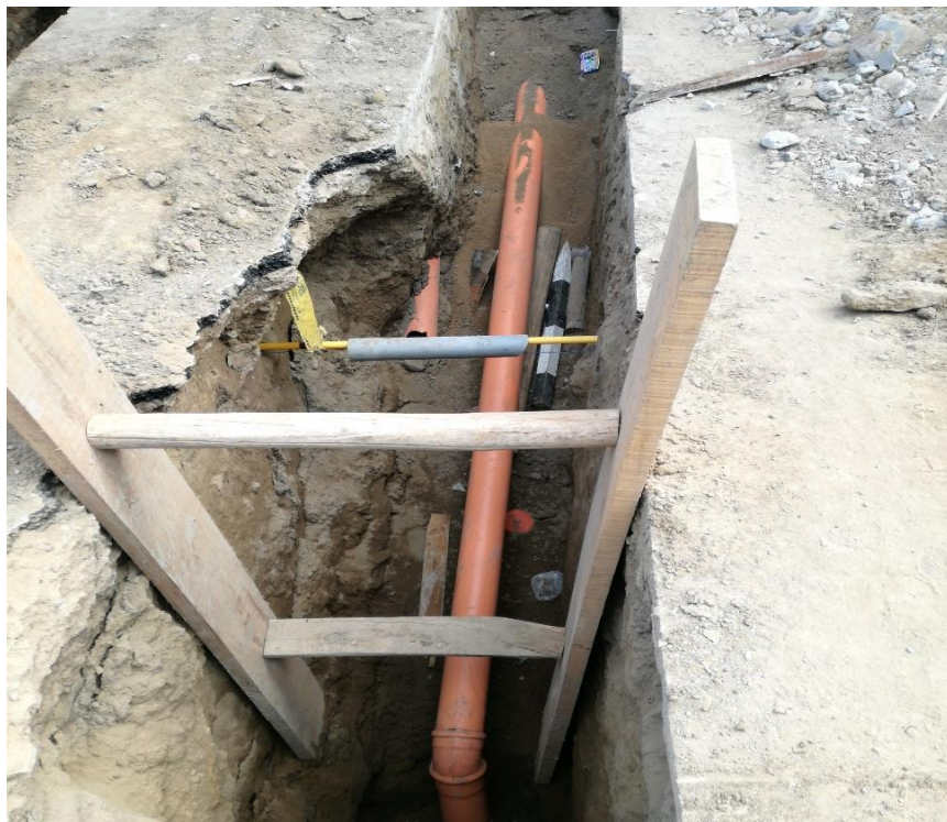
Figura. 45: Instalación de conexión domiciliar de alcantarillado Fuente: Elaboración Propia
