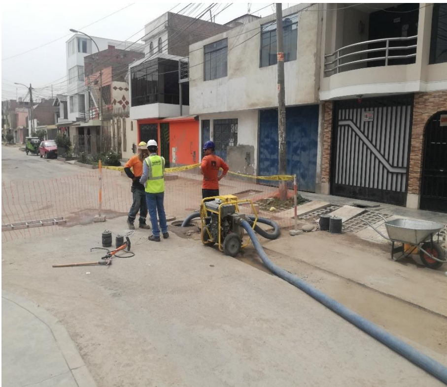
Figura. 32: Desvío de aguas de alcantarillado Fuente: Elaboración Propia
