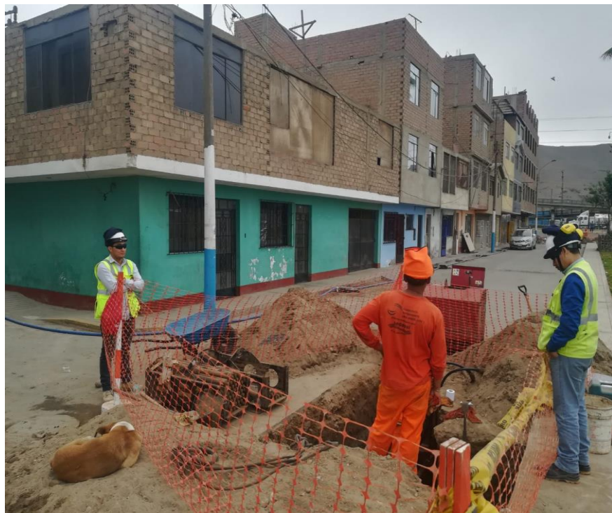
Figura. 14: Instalación de equipo de fragmentación Fuente: Elaboración Propia
