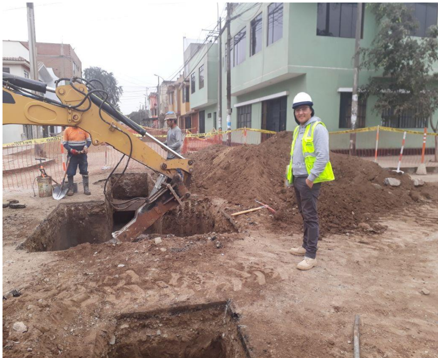
Figura. 65: Bachiller realizando la supervisión a las actividades de excavación Fuente: Elaboración Propia
