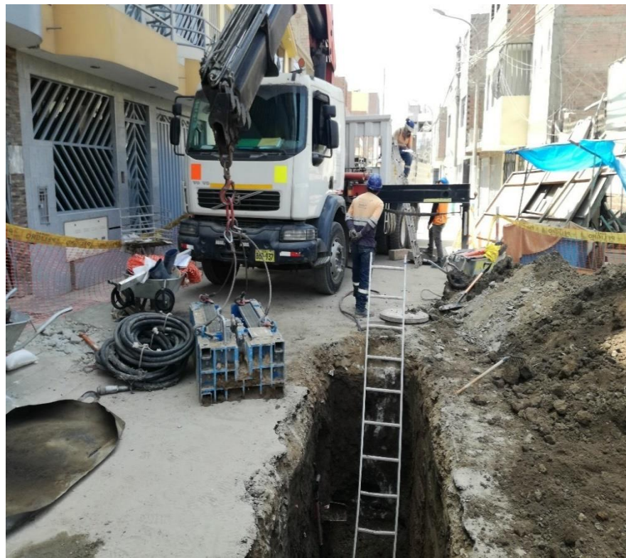
Figura. 37: Instalación de equipo de fragmentación
