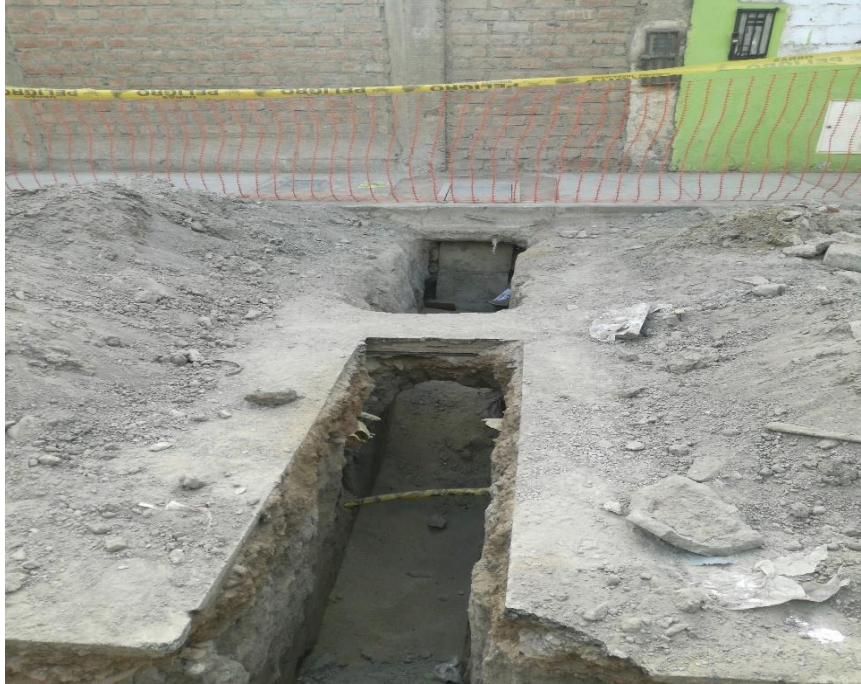
Figura. 42: Excavación de conexión domiciliar
