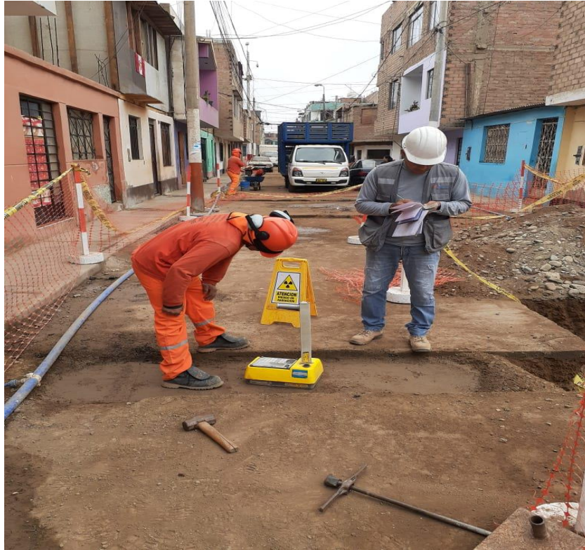
Figura. 21: Verificación de grado de compactación en conexión domiciliaria Fuente: Elaboración Propia
