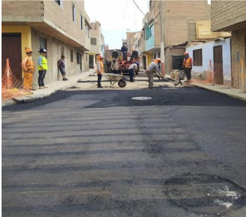
Figura. 12: Reposición de pavimento flexible
