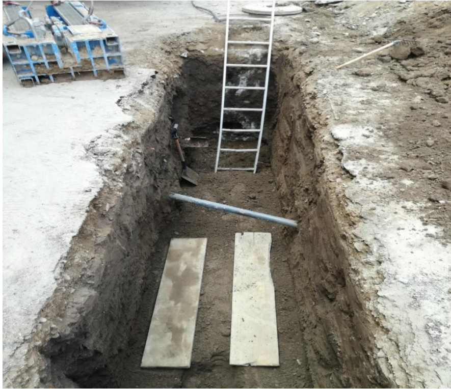
Figura. 36: Preparación de ventana para instalación de equipo de fragmentación
