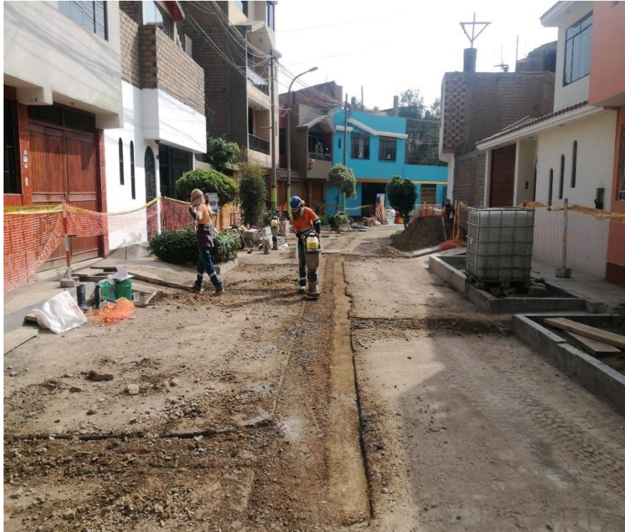
Figura. 40: Compactación de zanja de red de alcantarillado Fuente: Elaboración Propia
