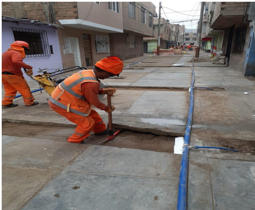
Figura. 18: Corte y rotura de pavimento rígido
