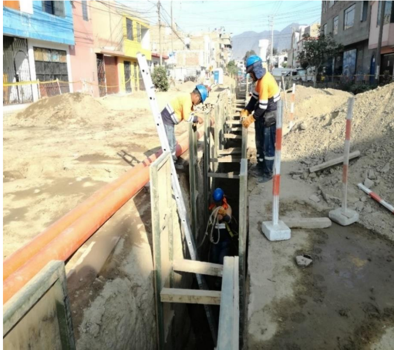
Figura. 27: Entibado de madera para red de alcantarillado sector 85 Fuente: Elaboración Propia
