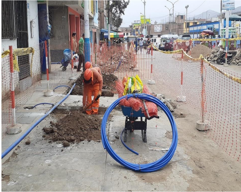
Figura. 19: Excavación de zanja para conexiones de agua potable Fuente: Elaboración Propia
