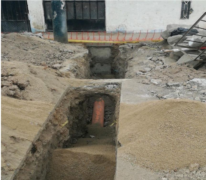
Figura. 44: Instalación de conexión domiciliar de alcantarillado Fuente: Elaboración Propia
