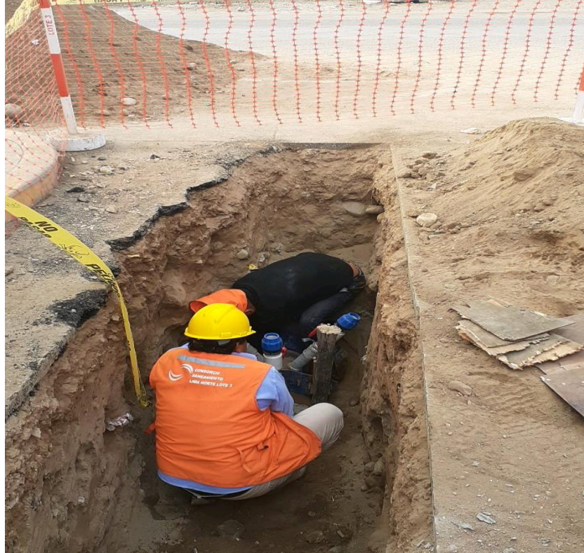
Figura. 7: Instalación de suministro de agua potable
