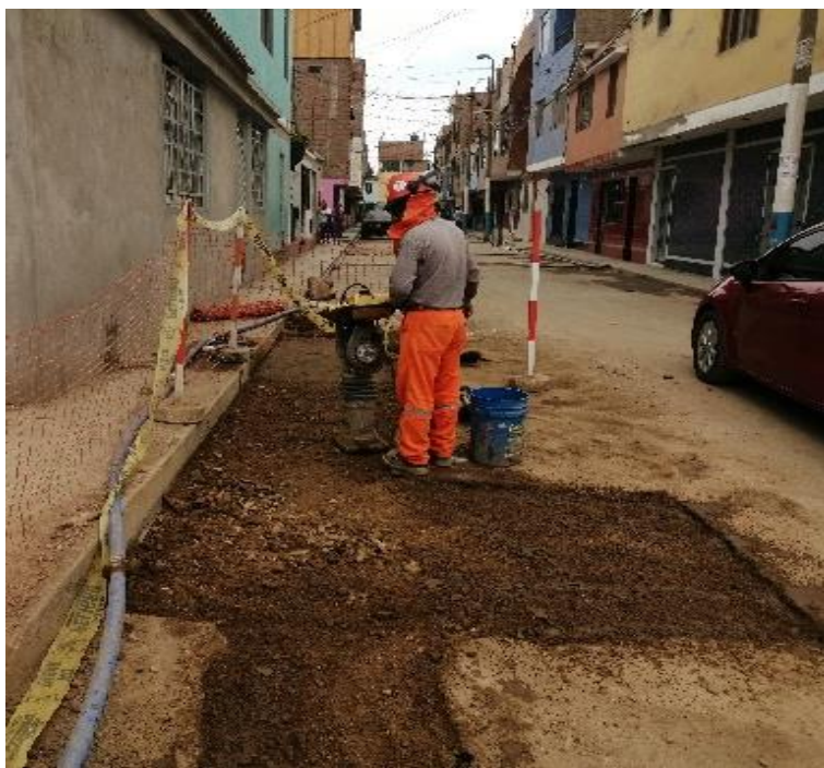
Figura. 17: Relleno y compactación de ventana de fragmentación
