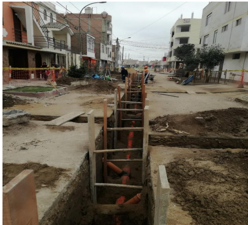
Figura. 28: Instalación de tubería de alcantarillado Fuente: Elaboración Propia
