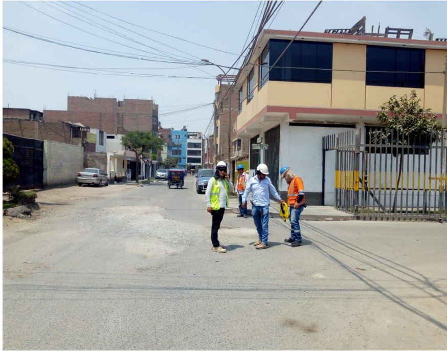
Figura. 64: Bachiller realizando el replanteo de los cambios de trazo de alcantarillado Fuente: Elaboración Propia
