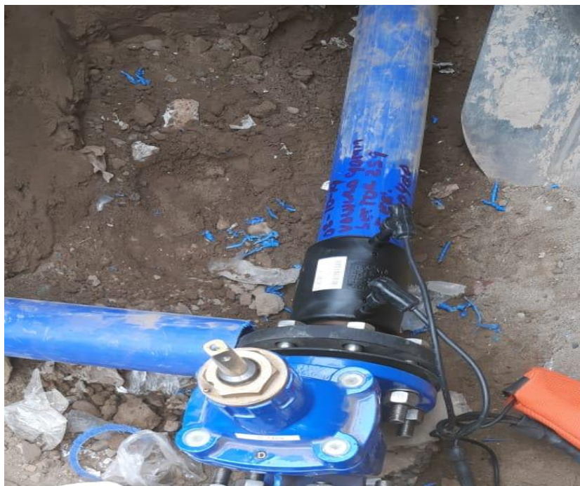
Figura. 9: Instalación de accesorio de agua potable
