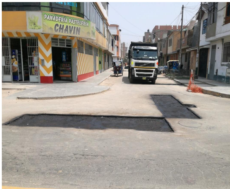
Figura. 41: Reposición de asfalto flexible en ventana de fragmentación Fuente: Elaboración Propia
