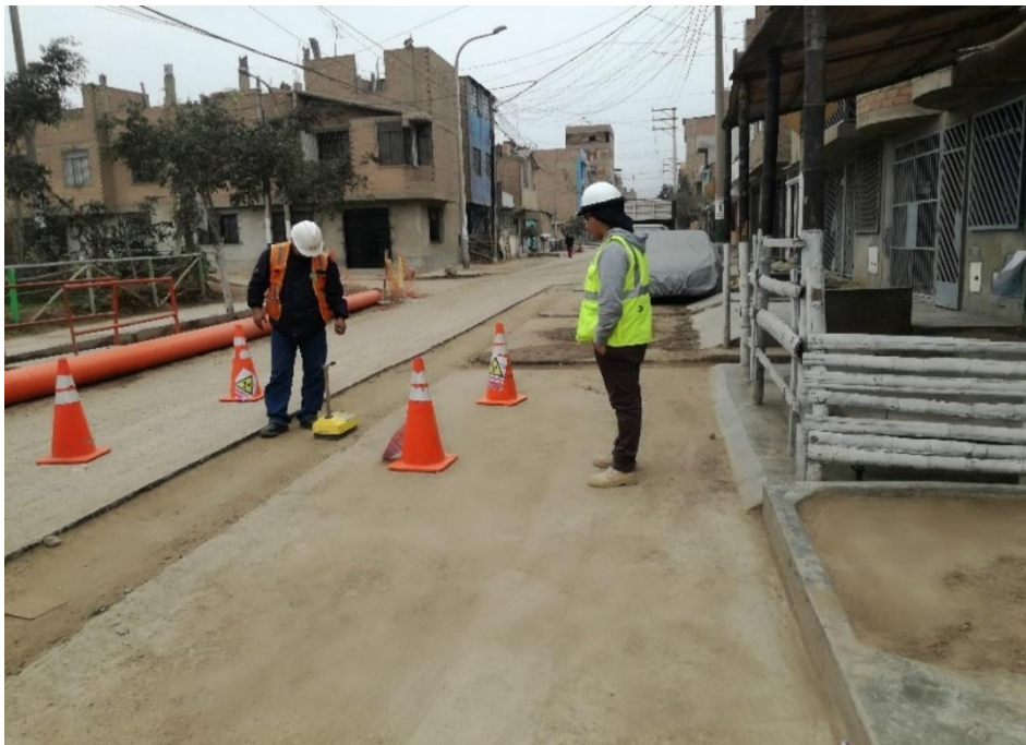
Figura. 61: Bachiller realizando la verificación del grado de compactación Fuente: Elaboración Propia
