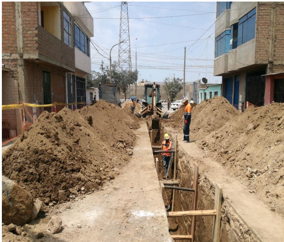
Figura. 26: Entibado de madera para red de alcantarillado sector 350
