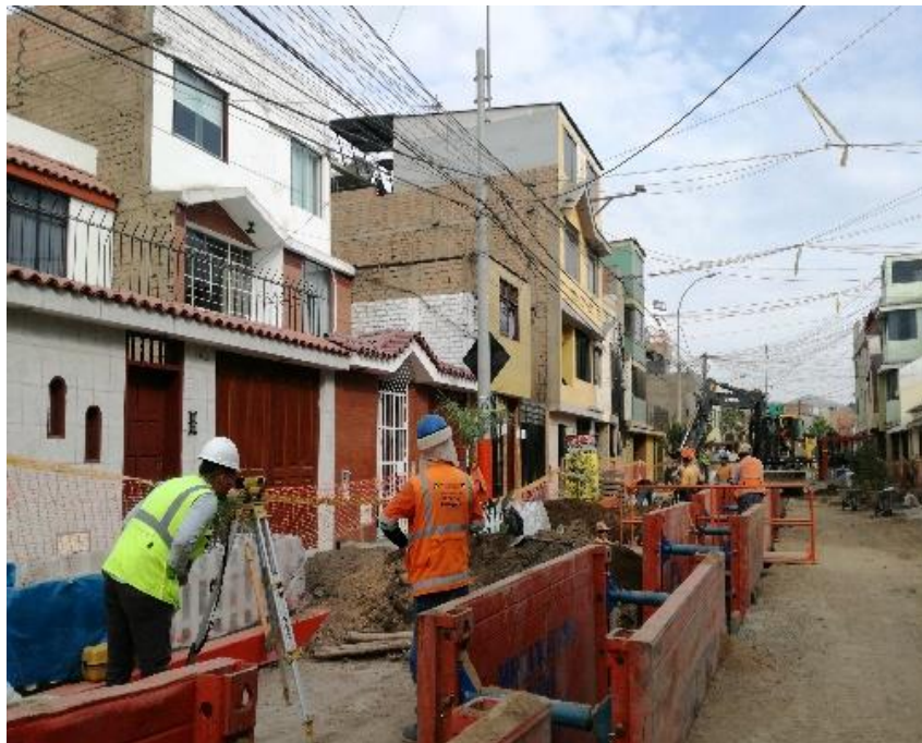
Figura. 57: Bachiller realizando las pruebas de nivelación a red de alcantarillado Fuente: Elaboración Propia
