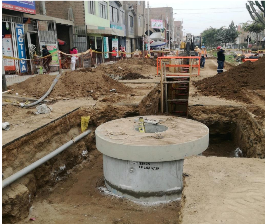
Figura. 47: Instalación de buzón de alcantarillado
