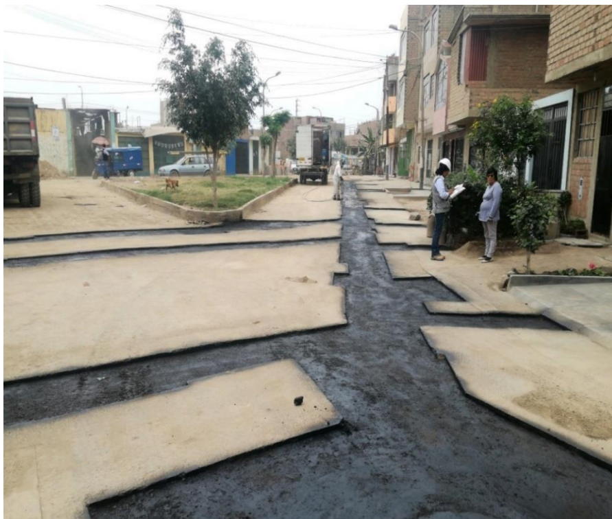
Figura. 34: Reposición de pavimento flexible en red de alcantarillado
