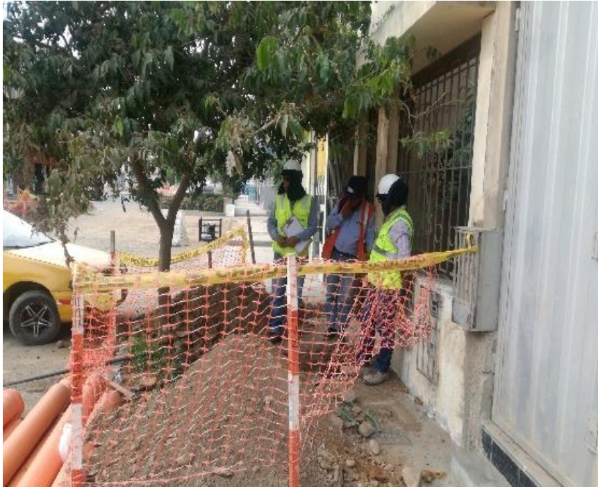
Figura. 58: Bachiller realizando la inspección de los trabajos de campo Fuente: Elaboración Propia
