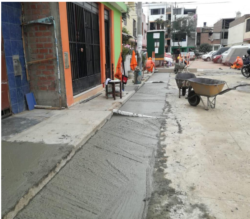
Figura. 22: Reposición de pavimento rígido Fuente: Elaboración Propia
