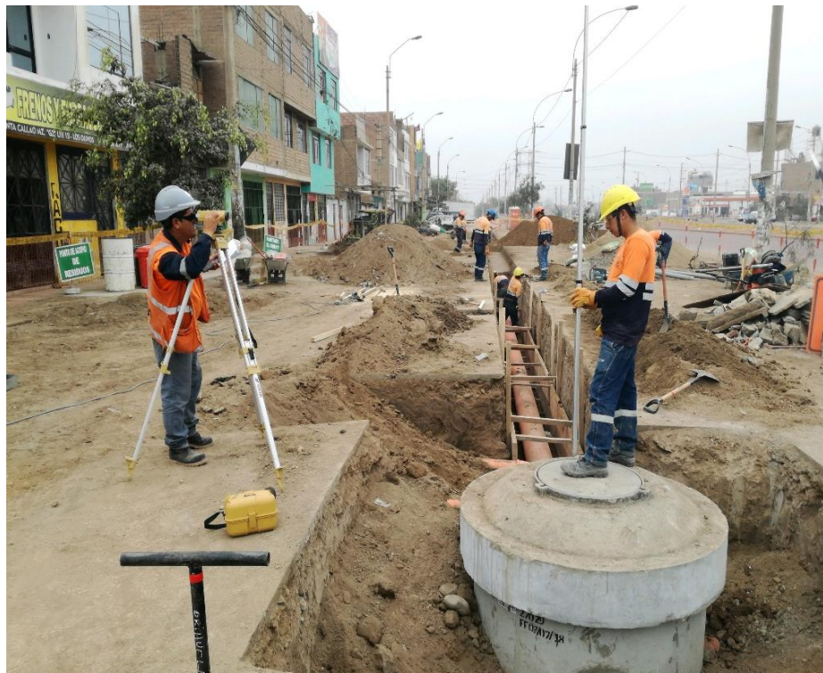
Figura. 48: Nivelación de techo de buzón de alcantarillado
