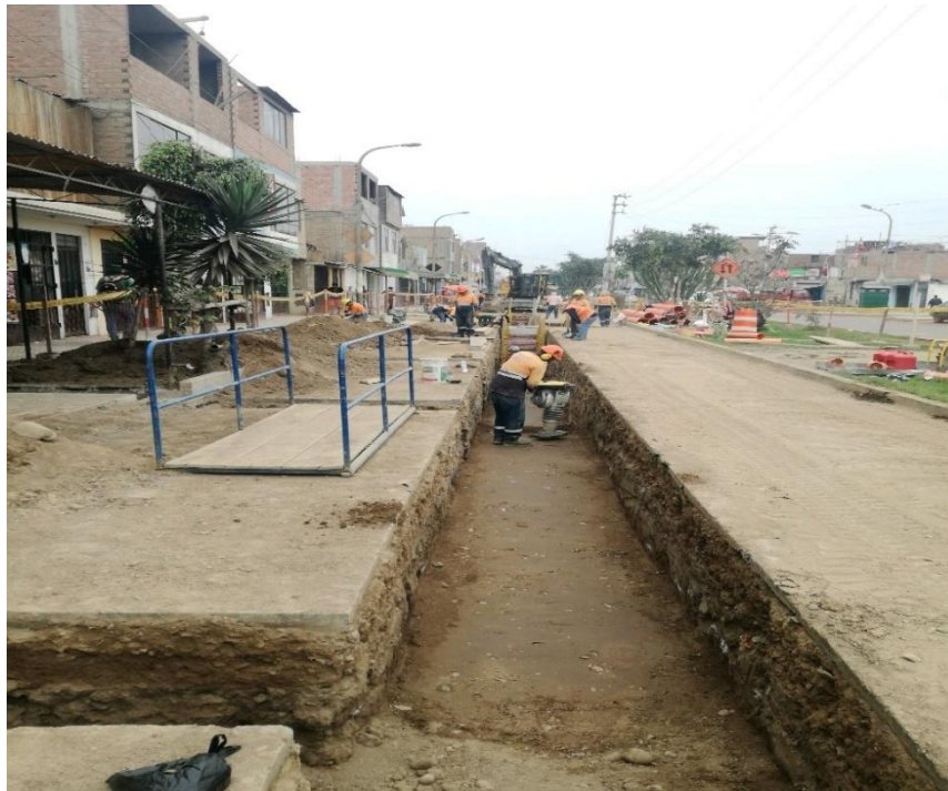
Figura. 30: Compactación de zanja de red de alcantarillado Fuente: Elaboración Propia
