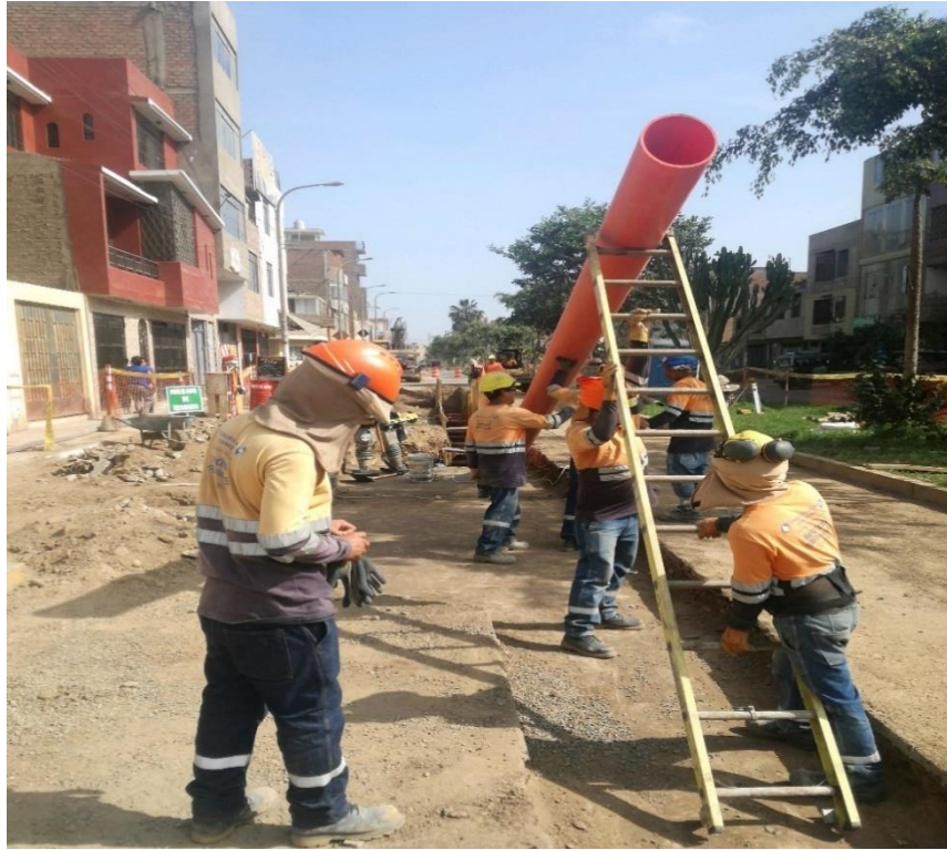
Figura. 38: Instalación de tubería de red de alcantarillado Fuente: Elaboración Propia
