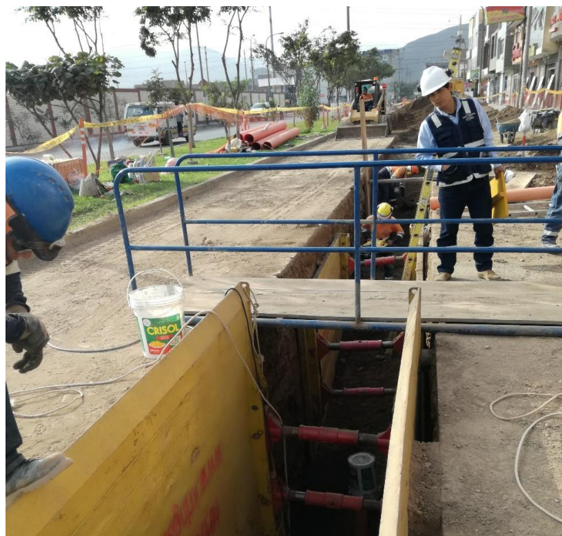
Figura. 51: Señalización del área de trabajo
