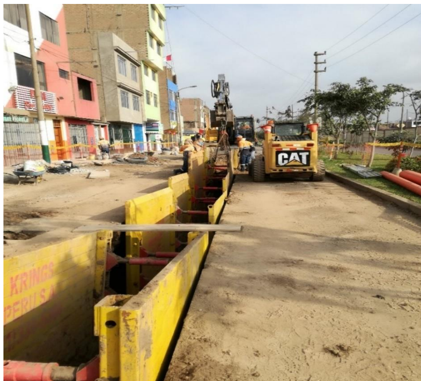
Figura. 24: Excavación de zanja para instalación de tubería de alcantarillado sector 84
