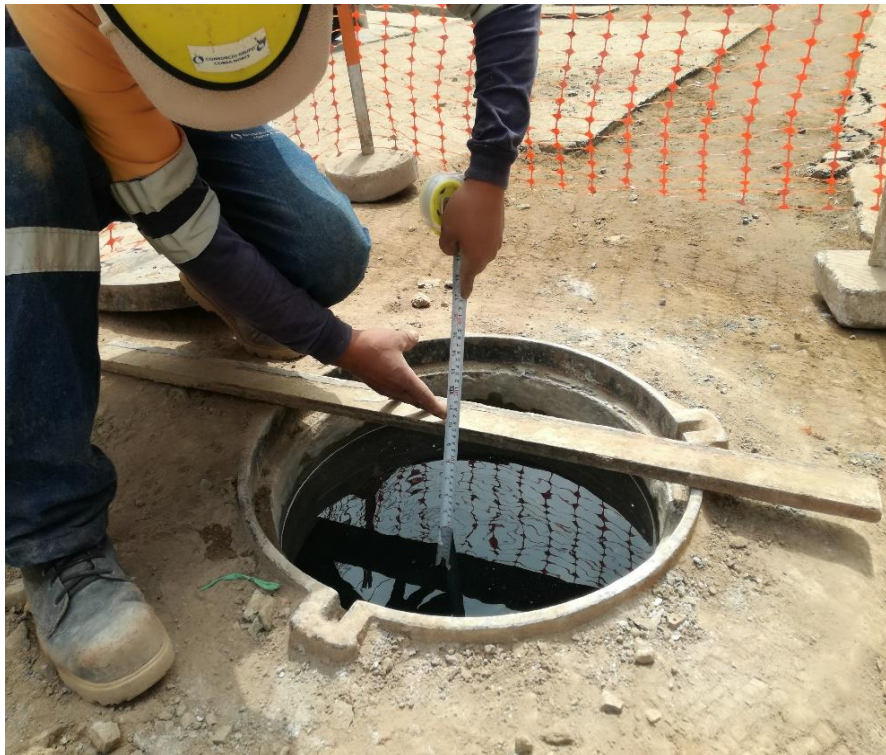
Figura. 33: Prueba hidráulica de estanqueidad de alcantarillado
