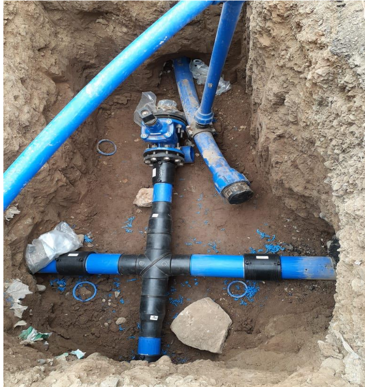
Figura. 10: Instalación de accesorio de agua potable Fuente: Elaboración Propia
