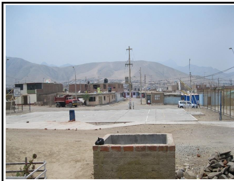
FOTO N° 01: Se observa una vista panorámica del Asentamiento Humano Manuel Scorza1, en la zona de la loza deportiva.
