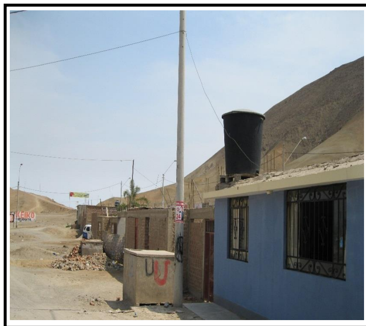
FOTO N° 03: Se observa la poza de agua y en algunas casas usan un tanque elevado para almacenar el agua
