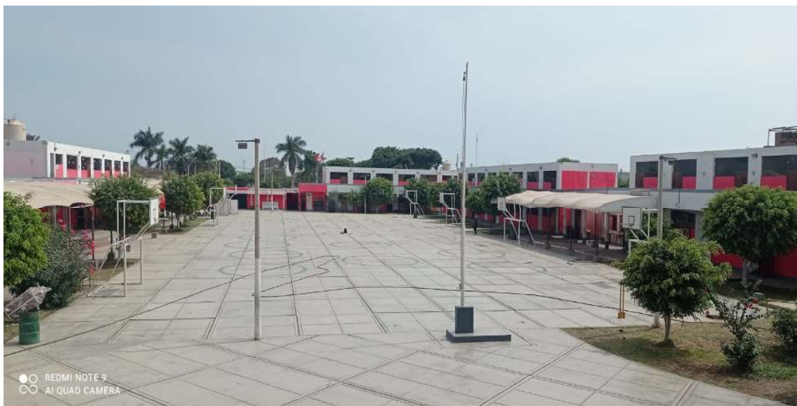
FOTO N°02: Se observa la foto del pabellón amplio donde se diseñará la cobertura liviana.
