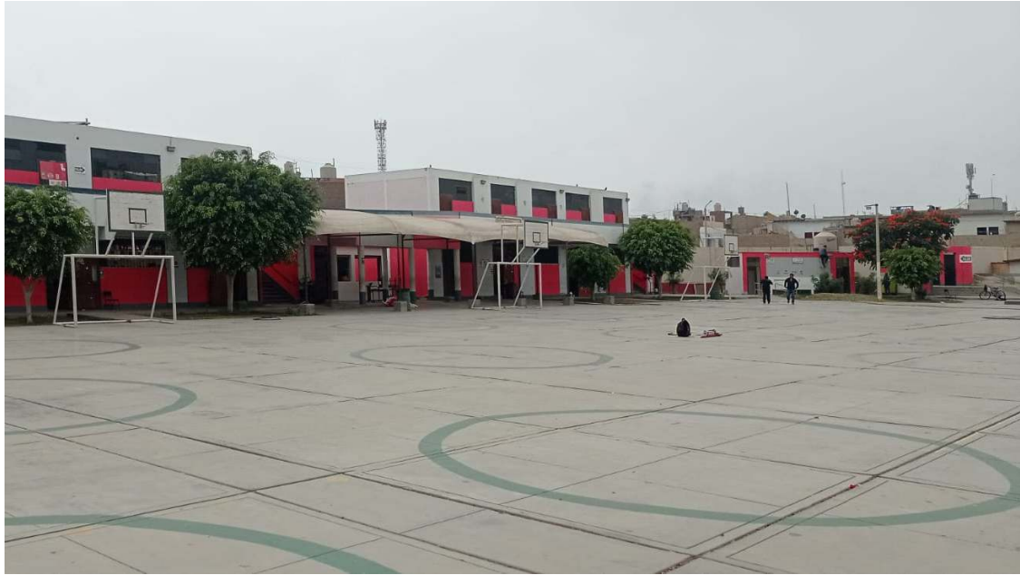
FOTO N°04: Se observa desde otra toma la infraestructura existente donde se diseñará la cobertura liviana.
