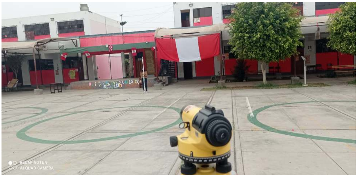
FOTO N°04: Se observa el uso del nivel topográfico para la medición de niveles topográficos.
