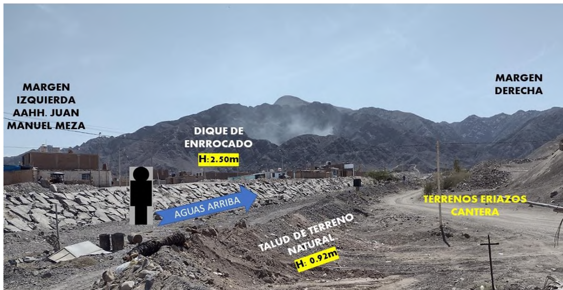
Figura 24: Característica y descripción física del Tramo III
