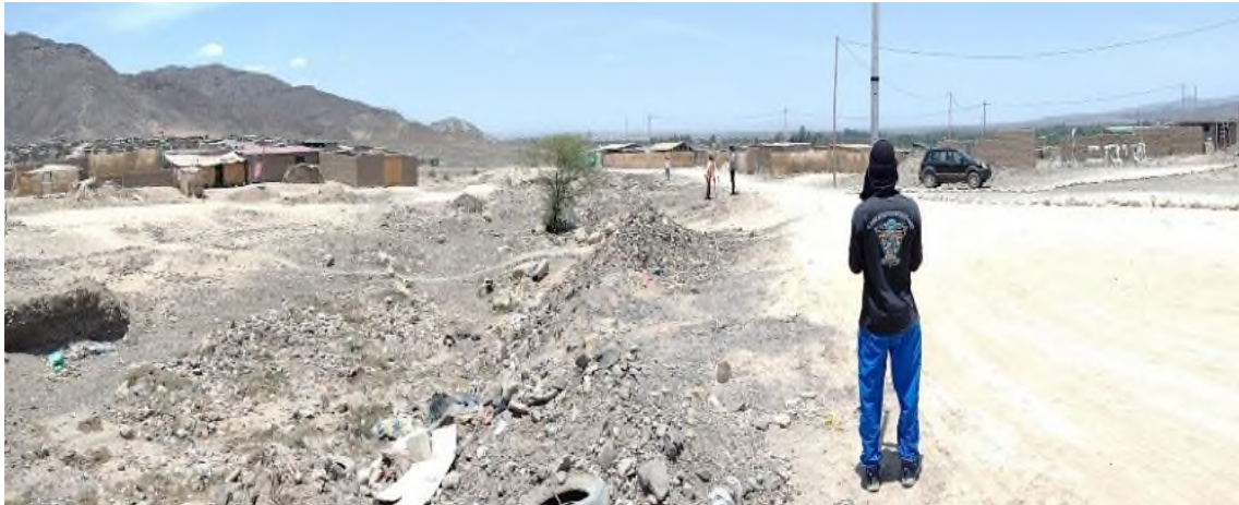
Figura 14: Trabajo de campo – Levantamiento Topográfico del Tramo VI:
