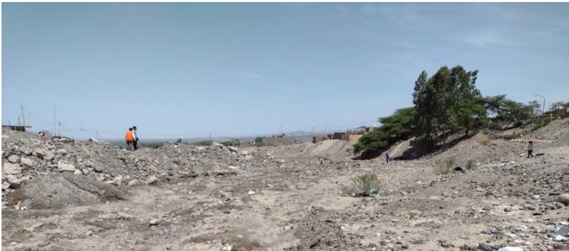
Figura 10: Trabajo de campo – Levantamiento Topográfico del Tramo IV
