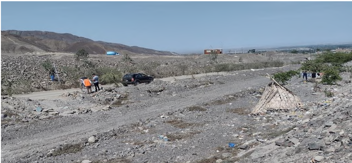
Figura 06: Trabajo de campo – Levantamiento Topográfico del Tramo II.
