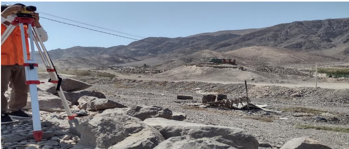
Figura 08: Trabajo de campo – Levantamiento Topográfico del Tramo III
