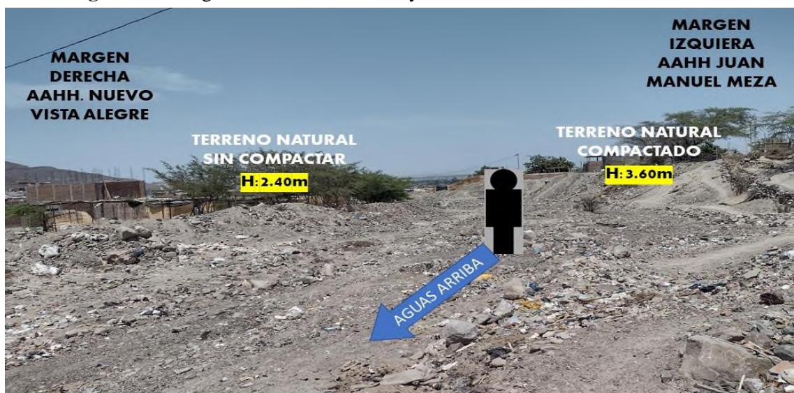
Figura 25: Google Earth – Delimitación y característica física del Tramo IV
