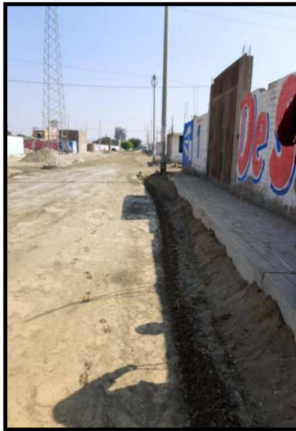
Fotografía 16. Construcción de veredas.
