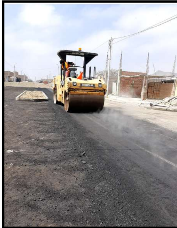
Fotografía 32. Compactación de la carpeta asfáltica en caliente.
