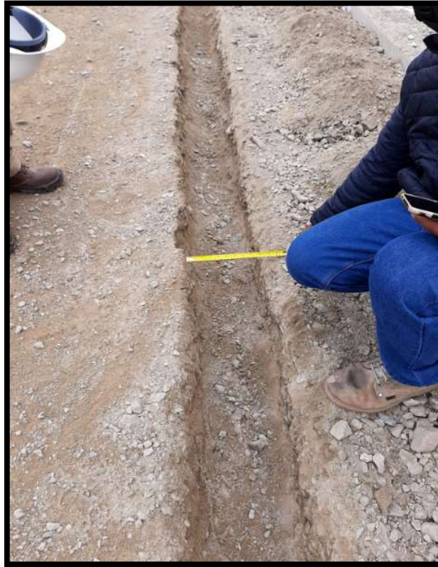
Fotografía 21. Verificación de Excavación de sardinel peraltado.
