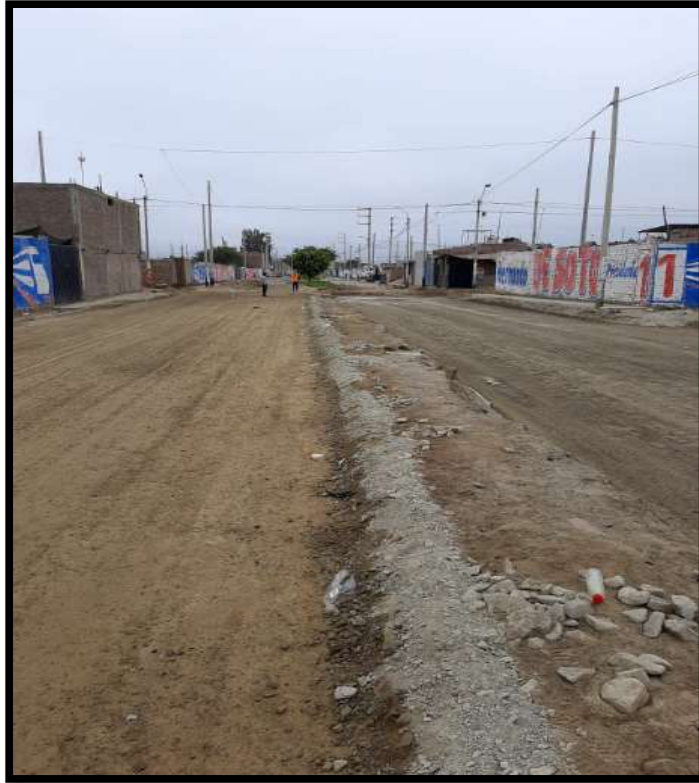
Fotografía 3. Compactación de la subrasante.
