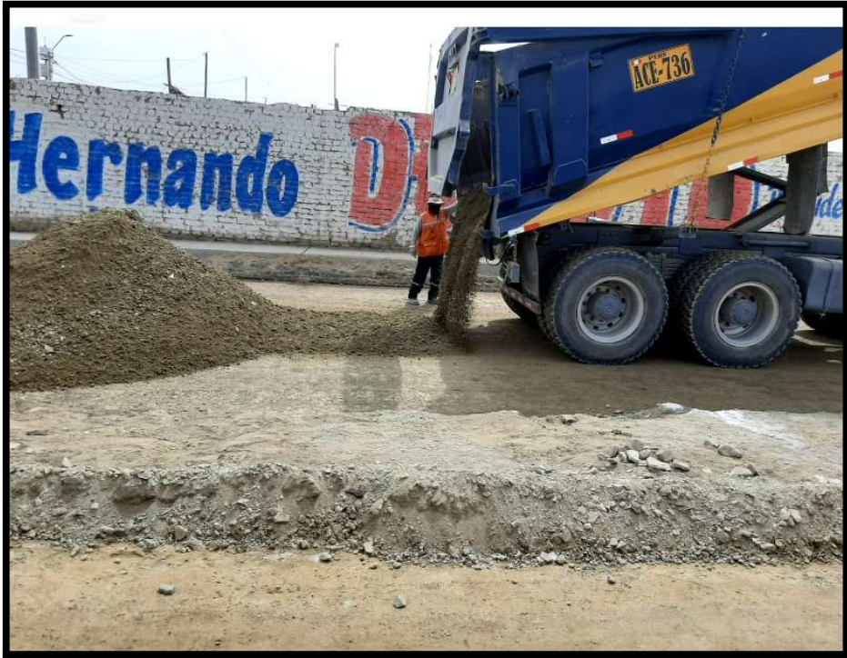
Fotografía 8. Tendido de material granular
