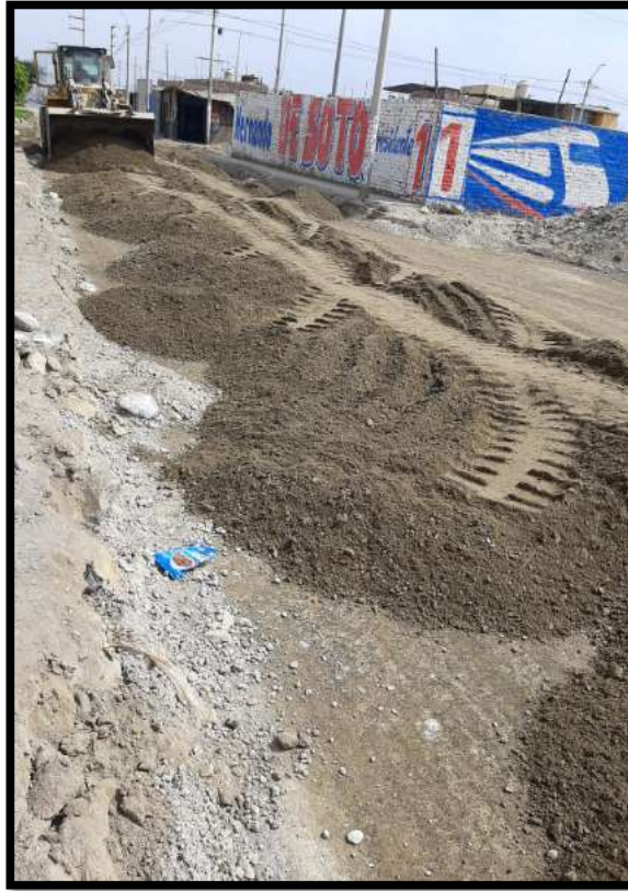
Fotografía 11. Tendido del material granular
