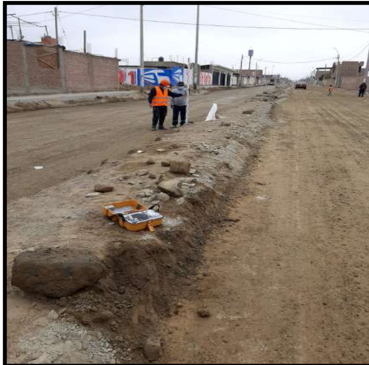
Fotografía 6. Replanteo durante la ejecución, para la verificación de los niveles.
