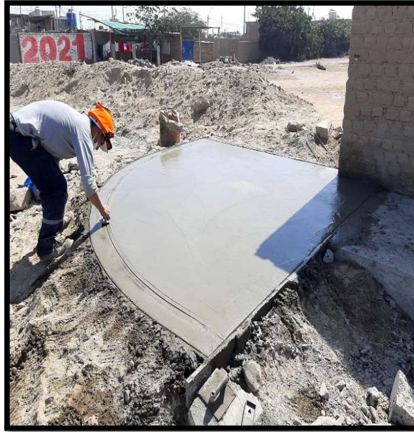
Fotografía 27. Construcción de martillos.
