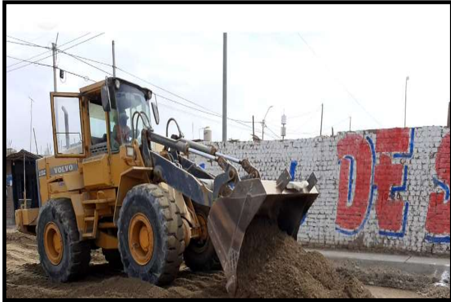
Fotografía 9. Extendido del material granular
