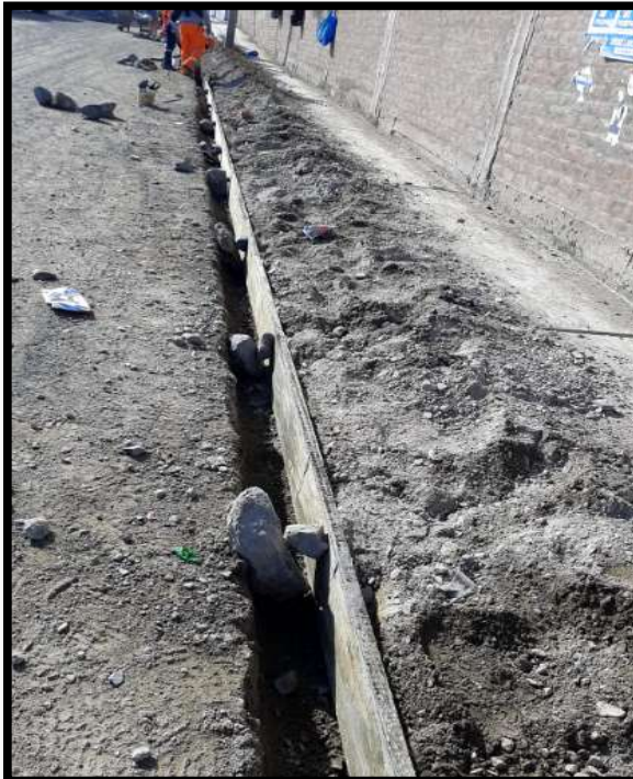
Fotografía 24. Encofrado de sardinel peraltado.
