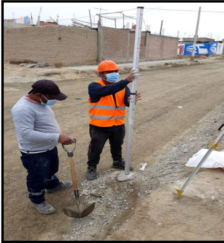
Fotografía 5. Replanteo durante la ejecución, para la verificación de los niveles.
