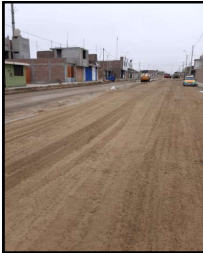
Fotografía 2. Compactación de la subrasante.
