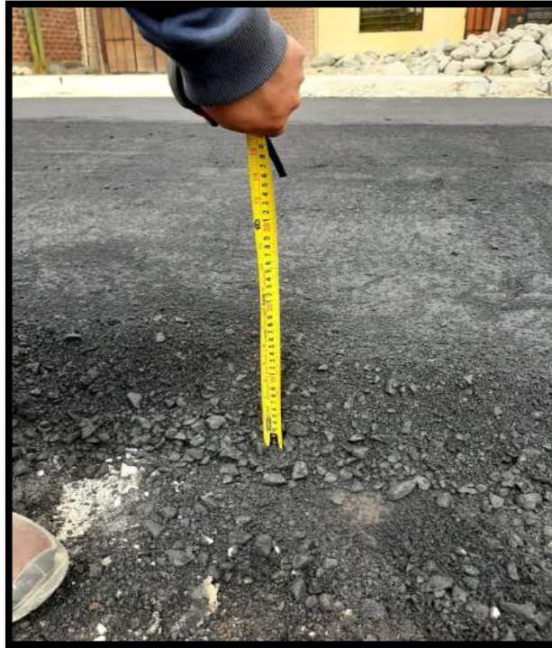
Fotografía 31. Verificación de la altura de la carpeta asfáltica según diseño.
