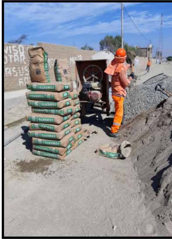
Fotografía 25. Materiales en obra.
