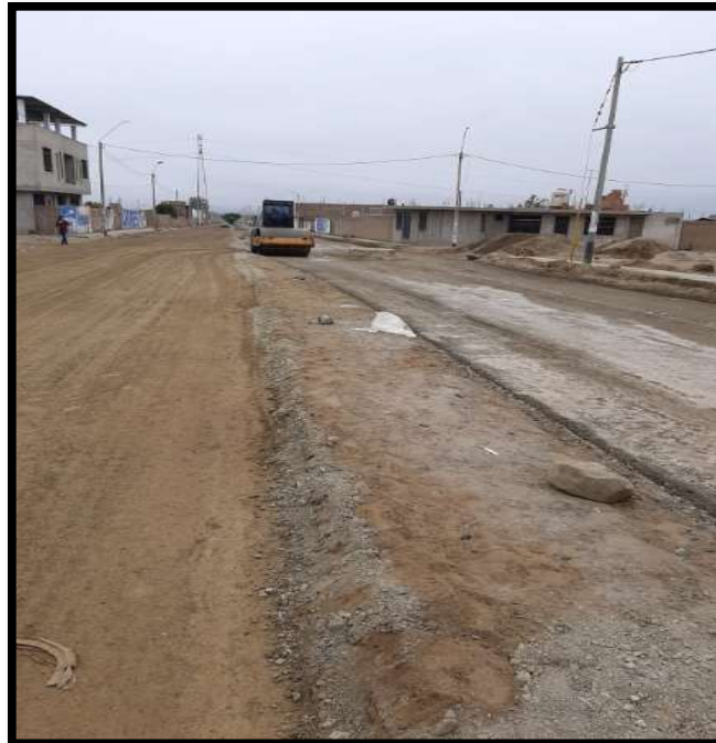
Fotografía 4. Riego del terreno y Compactación de la subrasante.
