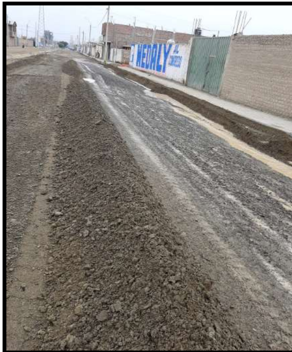
Fotografía 12. Riego del material granular
