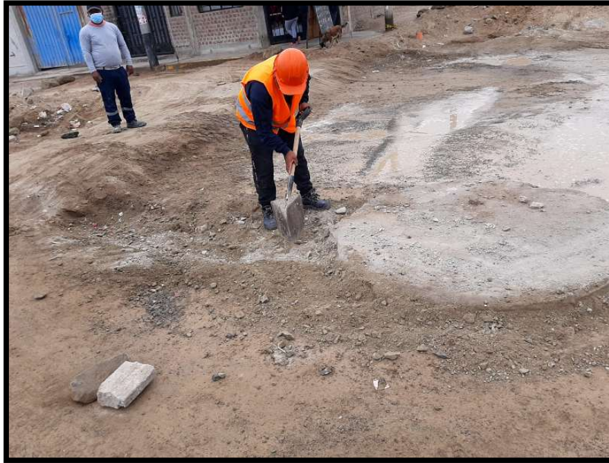
Fotografía 1. Se inicio con el Replanteo y corte del terreno natural
