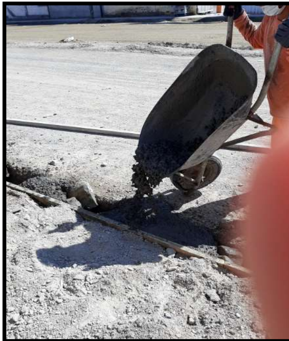
Fotografía 26. Vaciado de concreto en sardinel
