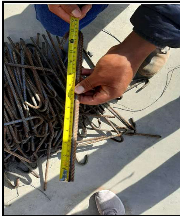
Fotografía 22. Verificación de acero en sardinel peraltado.
