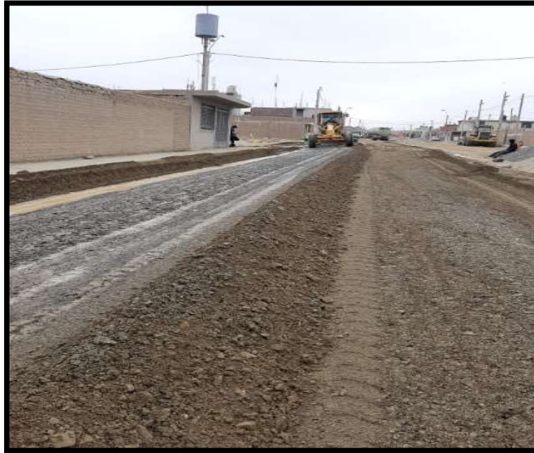
Fotografía 13. Nivelación del terreno mejorado para la preparación de la sub base.
