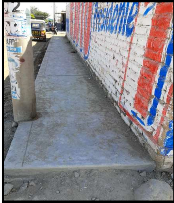
Fotografía 19. Construcción de veredas.
