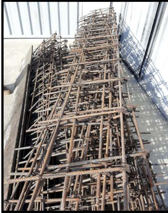
Fotografía 23. Armado de acero en sardinel peraltado.
