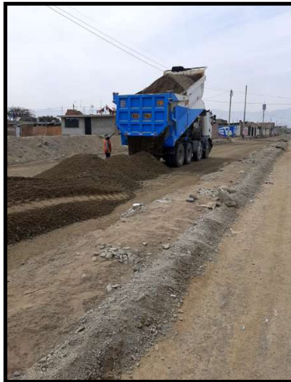
Fotografía 10. Tendido del material granular
