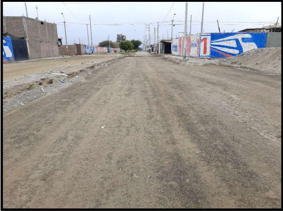
Fotografía 7. Subrasante lista para recibir el material granular para la conformación de la Sub base
