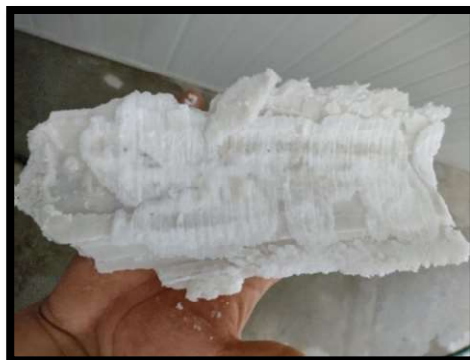
Figura No 7: Costras de Caliche alojados en los tubos de presión
