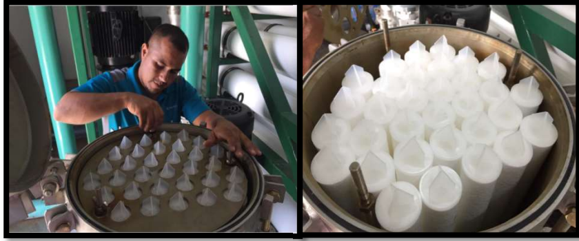
Figura No 17: Se realizo el cambio de los filtros de Cartucho
