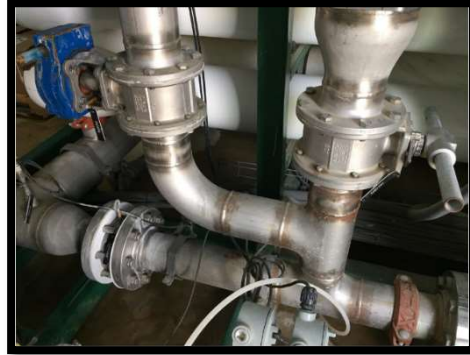
Figura No 15: Se inspecciono diariamente si existen fugas de la tubería.
