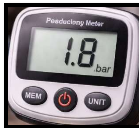
Figura No 28: medición de la diferencia de presión en las membranas de Osmosis Inversa, el cual es un valor óptimo para el funcionamiento del sistema.
