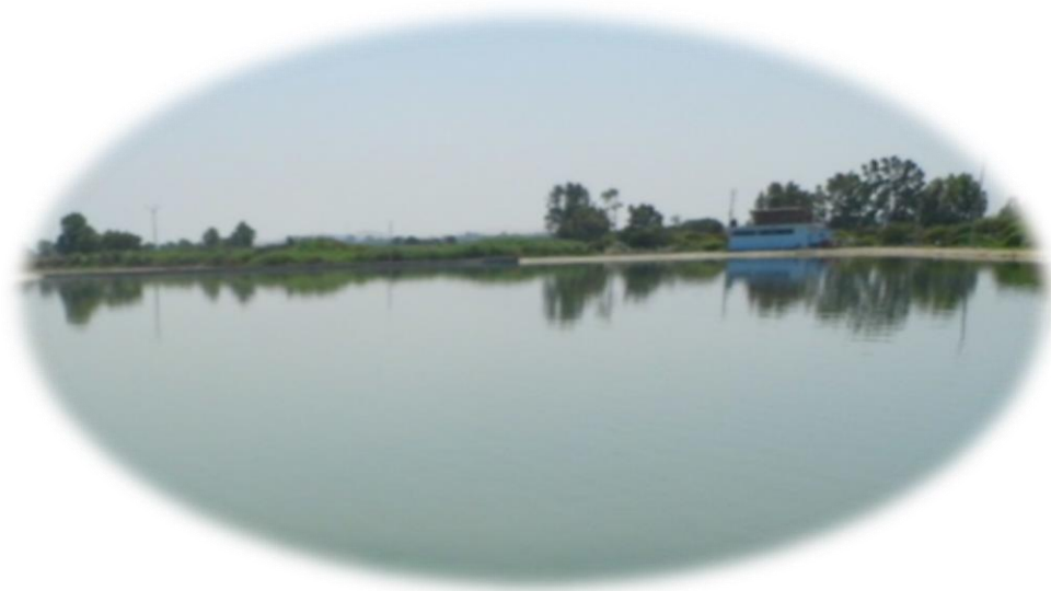
Figura 19. Lagunas de maduración
