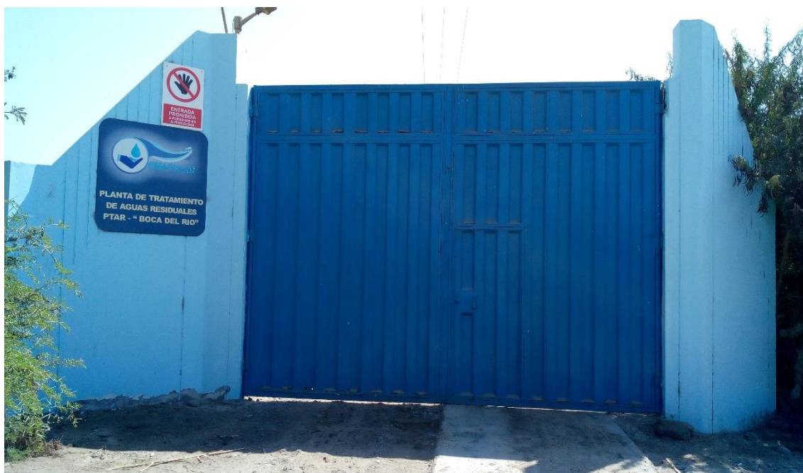
Figura 15. Ingreso a PTAR “Boca De Rio”
