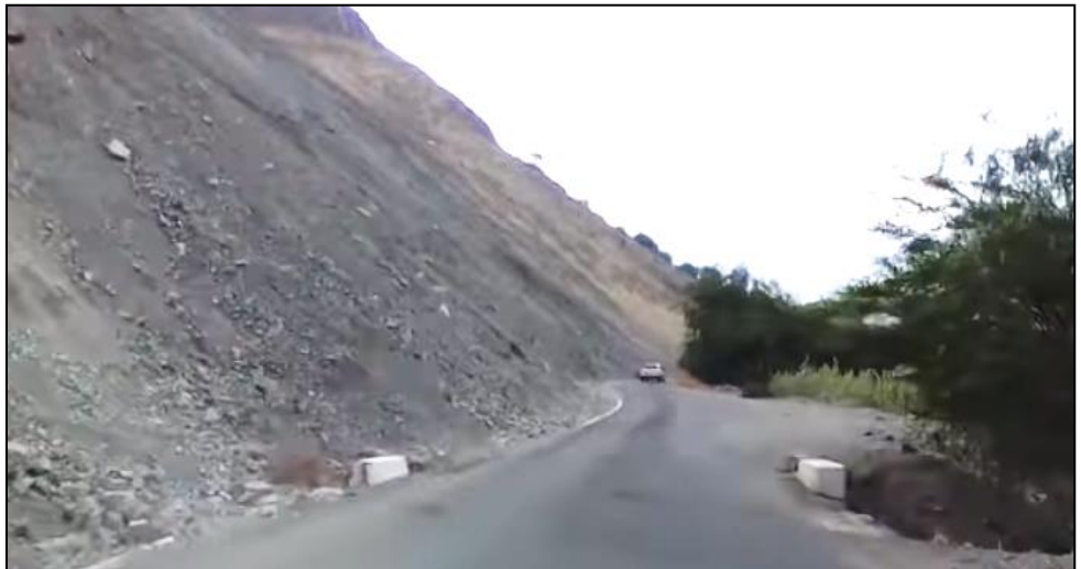
Fig. 7. Tramo (km 12) parte del Pte. Chontay, vista de una alcantarilla
