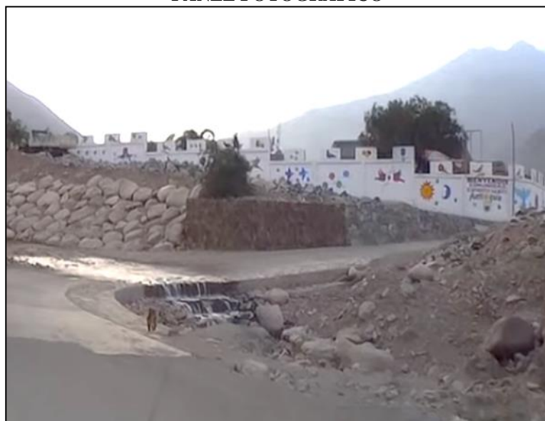
FOTO N° 01: Se observa el ingreso al pueblo de Antioquia en el cruce al río Lurín que provoca las alteraciones hídricas, en el Km 25 aproximadamente.
