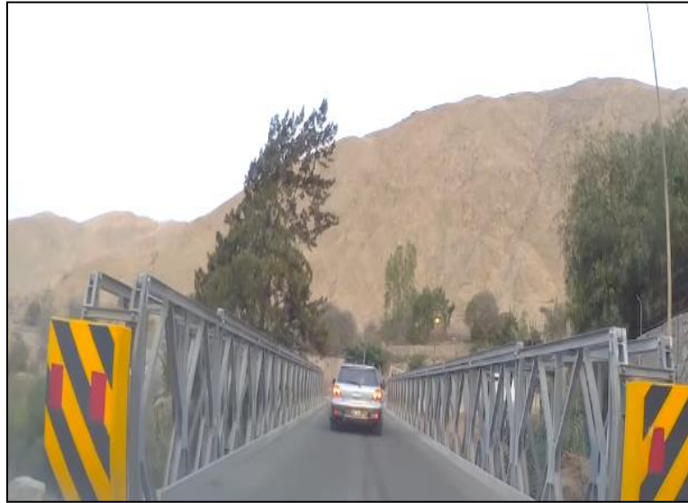
FOTO N° 04: Se observa el inicio de la carreta en el Puente Chontay, límite con el distrito de Cieneguilla.
