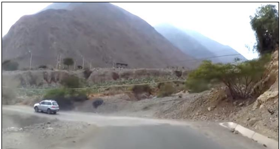
Fig. 8. Tramo (km 20) parte del Pte. Chontay, vista de badén en quebrada
