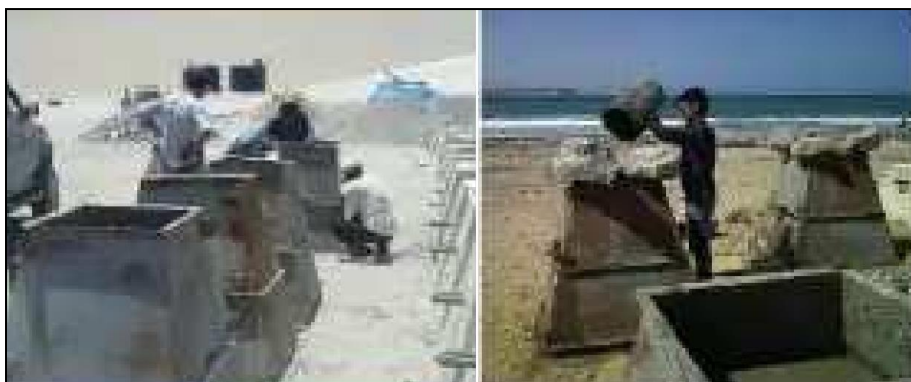
Figura N° 25.- Armado de moldes y vaciado de concreto para lastres
