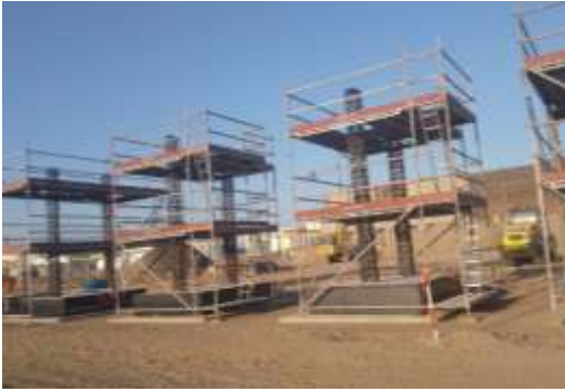
Fig. 15: Encofrado de pedestales
