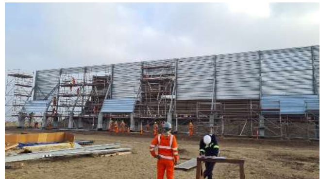
Fig. 29: Colocación manual de planchas acanaladas
