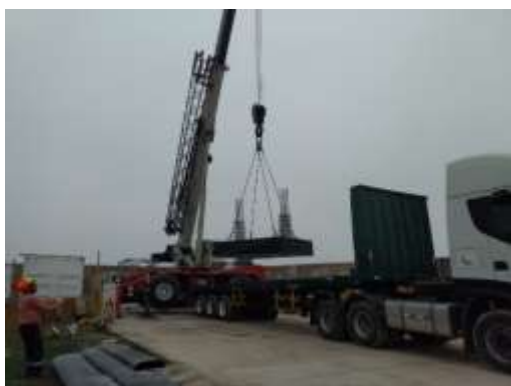
Fig. 11: Izaje de Estructuras
