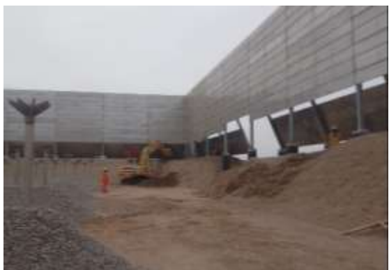
Fig. 24: Perfilado de dique
