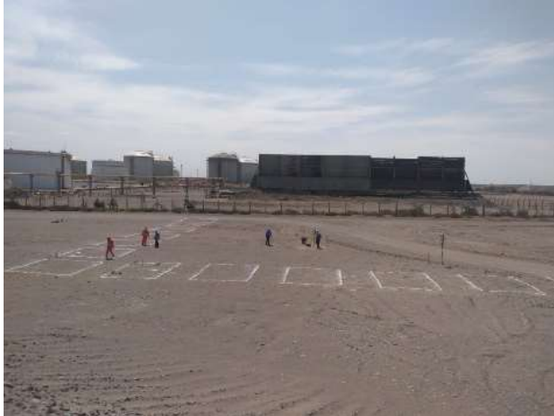
Fig. 05. Trazo y Replanteo de Cimentación New Flare
