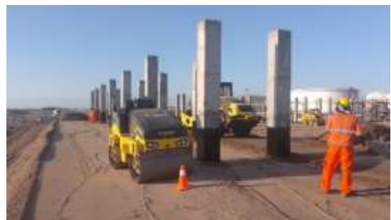
Fig. 18: Compactación de dique
