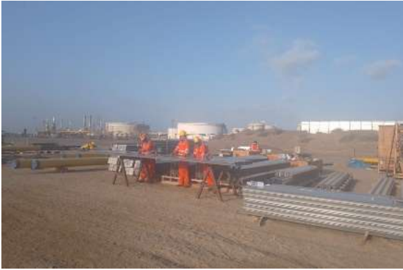
Fig. 33: Trabajos en el taller de instalación del flare
