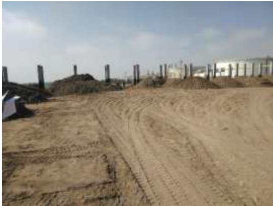
Fig. 20: Colocacion de material granular
