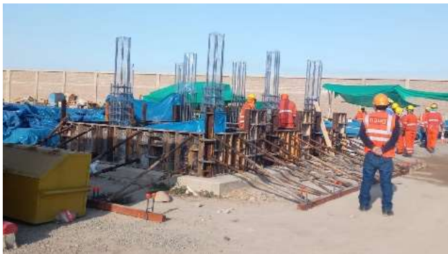
Fig. 07: Prefabricado de bases de New Flare
