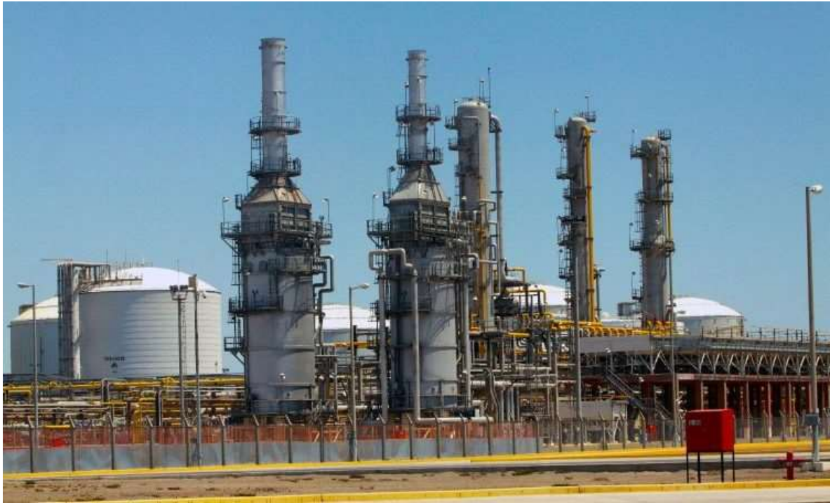
Fig. 02: Planta de fraccionamiento de Gas Natural. Pisco
