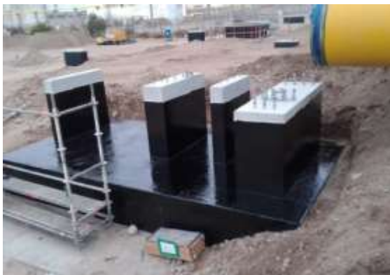
Fig. 22: Impermiabilizacion de soportes
