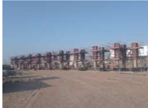
Fig. 16: Encofrado de pedestales
