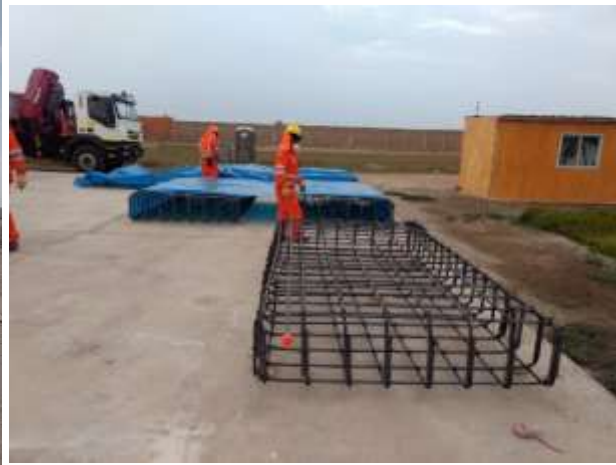
Fig. 06: Habilitado de Acero en bases New Flare
