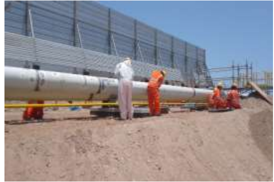
Fig. 41: Trabajos de constatación del gas de alivio
