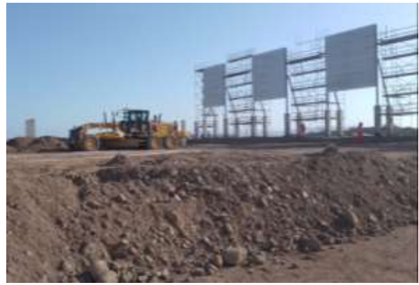
Fig. 21: Plataformado de flare
