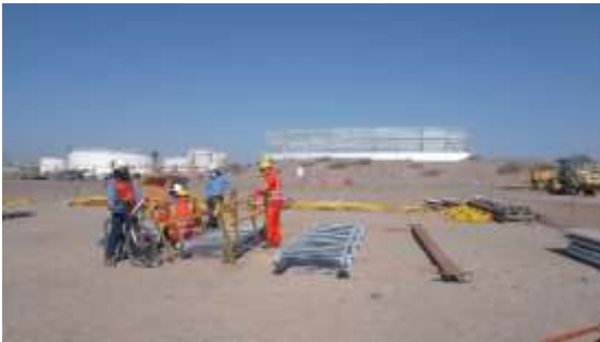
Fig. 36: Trabajos de afinamiento de las estructuras del flare
