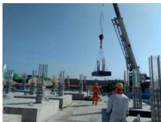
Fig. 10: Izaje de Estructuras
