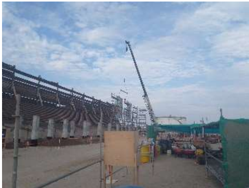
Fig. 28: Instalación de estructuras de flare
