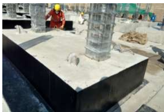
Fig 12: Aplicación de Igol en estructuras
