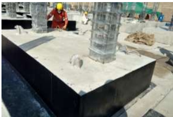
Fig. 09: Aplicación de Igol en estructuras
