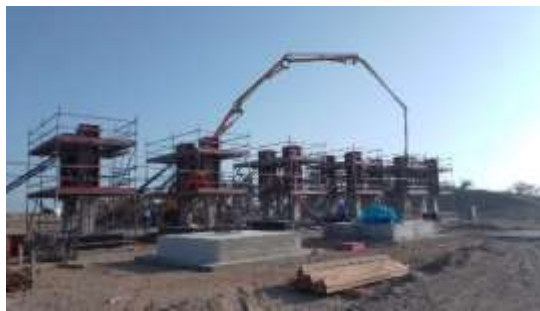
Fig. 17: Vaciado de concreto pedestales
