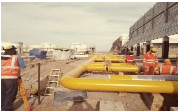
Fig. 38: Revisión y supervisión de seguridad
