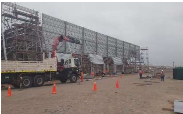
Fig. 30: Colocación de faldones de flare
