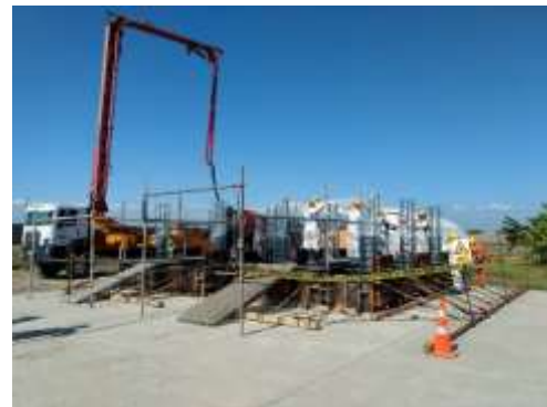
Fig. 08: Vaciado de Concreto de bases de New Flare
