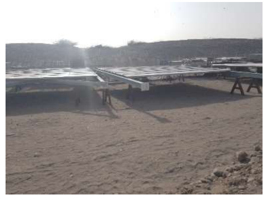
Fig. 34: Materiales en almacén del flare
