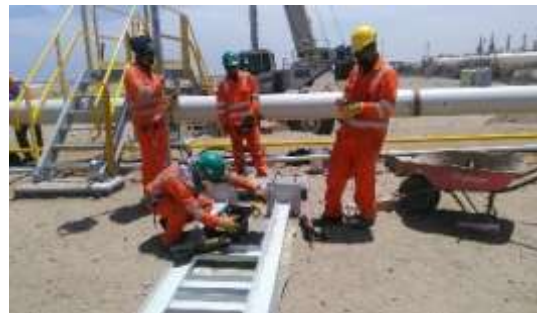
Fig. 37: Trabajos de afinamiento de las estructuras del flare
