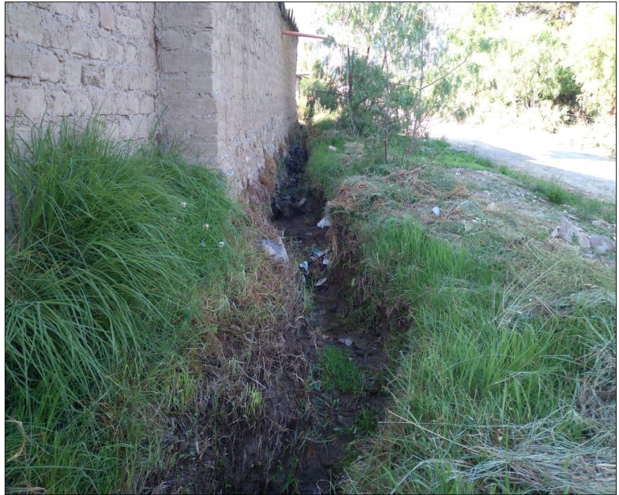
Fig. 14: Vista del canal en el tramo urbano Sector 2 - Ccaraspampa.
