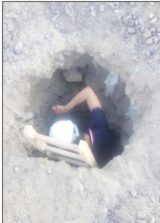
INGRESO A LA CALICATA PARA TOMAR MEDIDAS Y MUESTRAS
