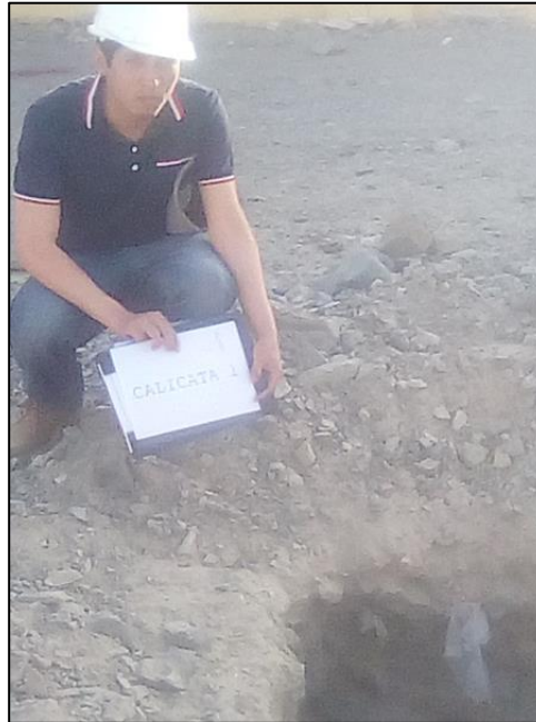
CALICATA C-1, UBICACION Y PERFIL ESTRATIGRAFICO
