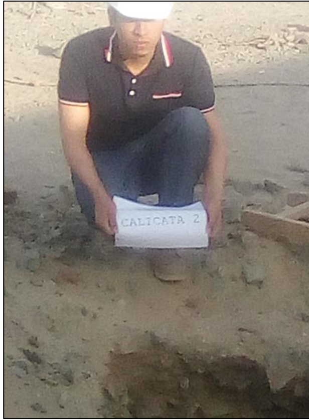
CALICATA C-2, UBICACION Y PERFIL ESTRATIGRAFICO
