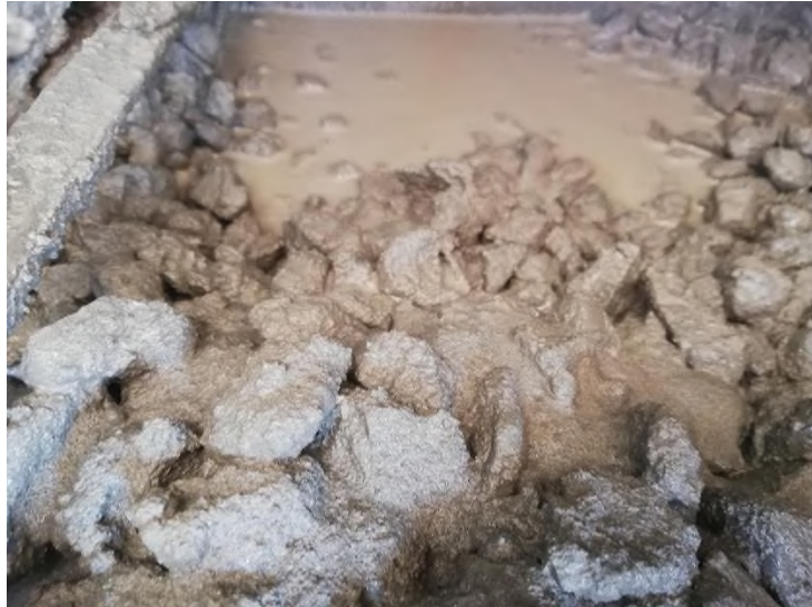
Muestra de segregación con el aditivo superplastificante sika visocrete 1110 PE en su dosificación media sin reducir agua
