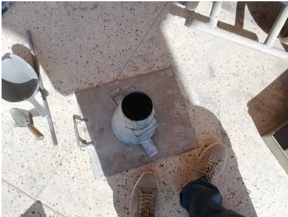
Herramientas para el ensayo de consistencia del concreto con el cono de Abrams
