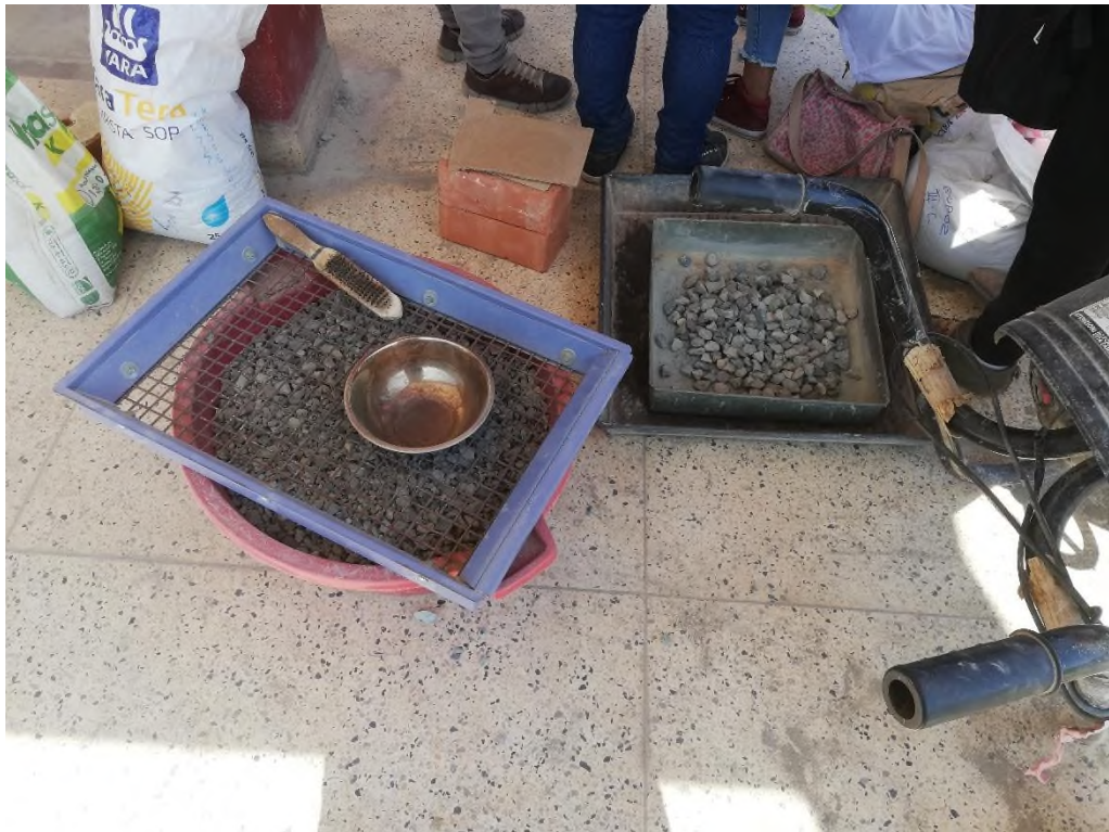
Tamizando el agregado grueso para obtener TMN de \frac{3}{4} "
