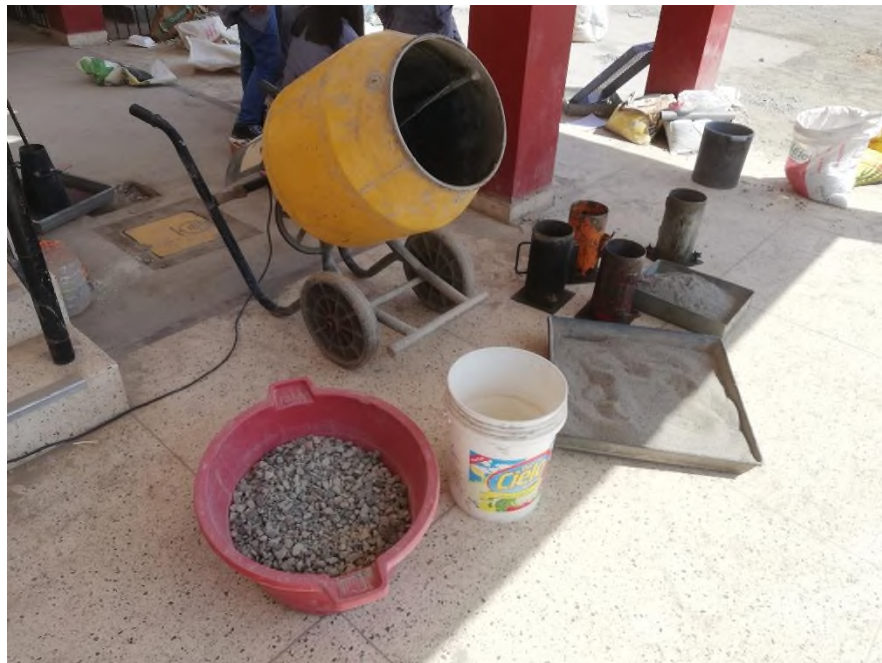
Materiales y equipo para la elaboración de concreto
