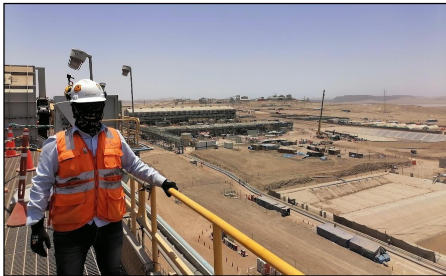
Figura 41: 3240 – VATS & PONDS / inspección técnica.
