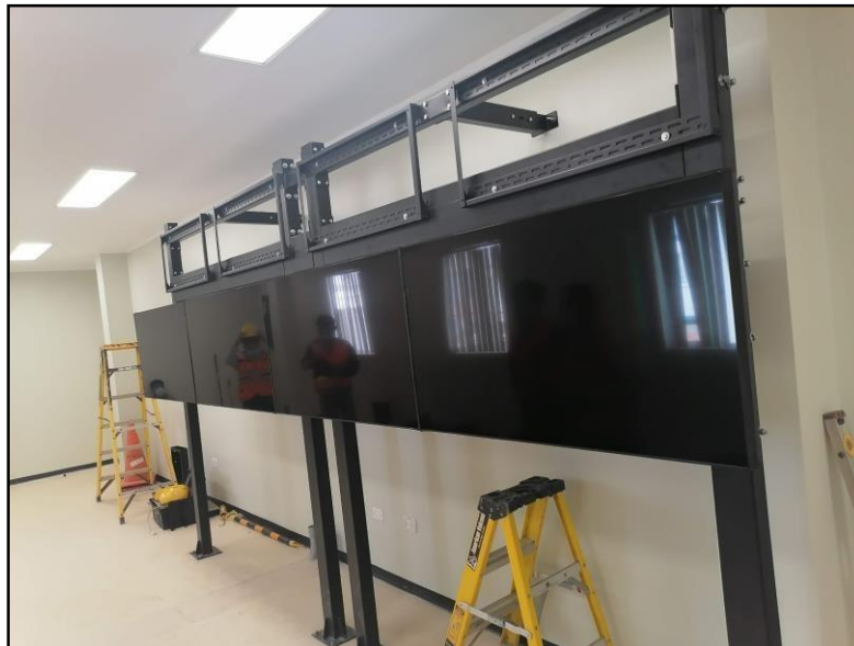
Figura 47: Instalación de soportera/rack para video wall (centro de Control).
