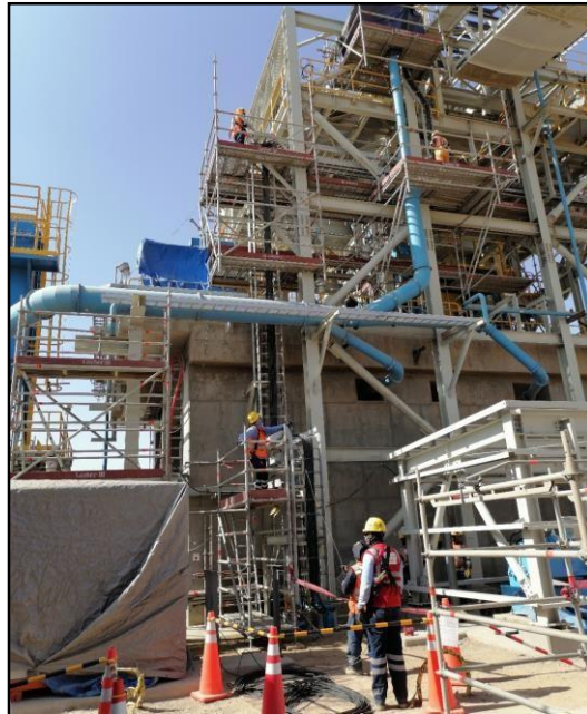
Figura 44: Tendido de cable de fuerza y fibra óptica en bandejas.
