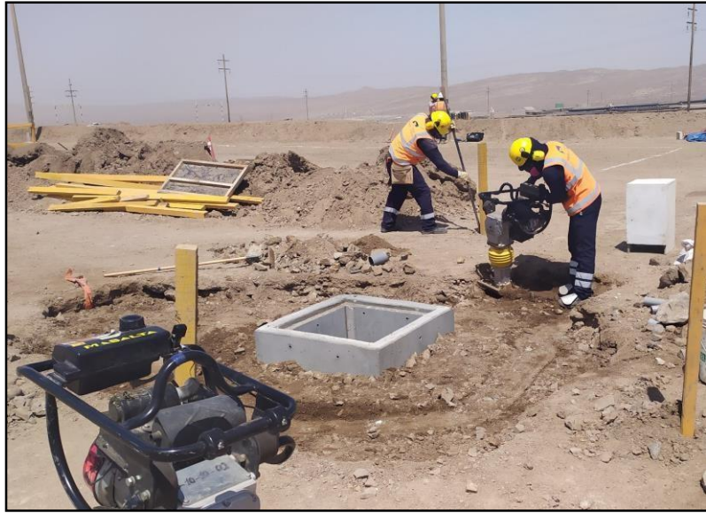
Figura 43: Tendido de tubería PVC SCH.
