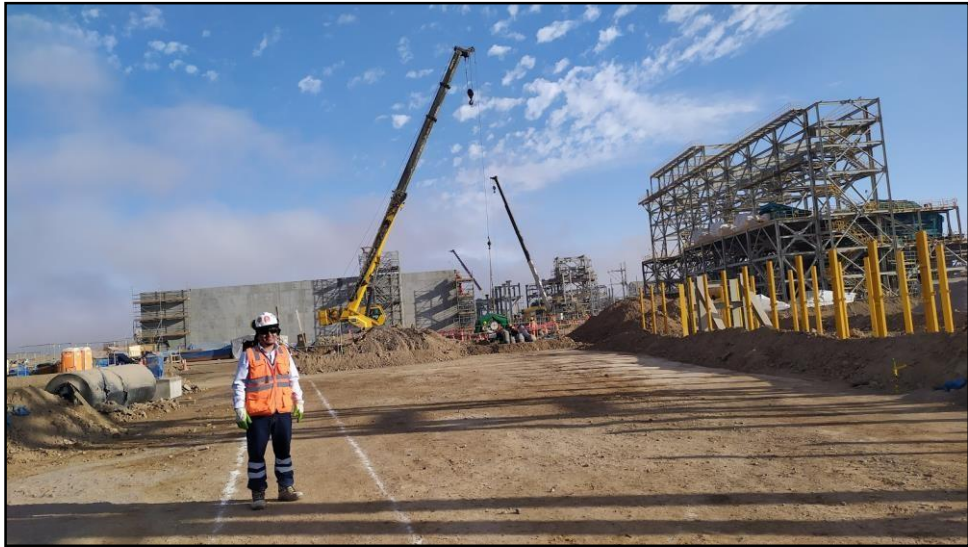
Figura 6: 3240 – VATS & PONDS / en proceso constructivo.
