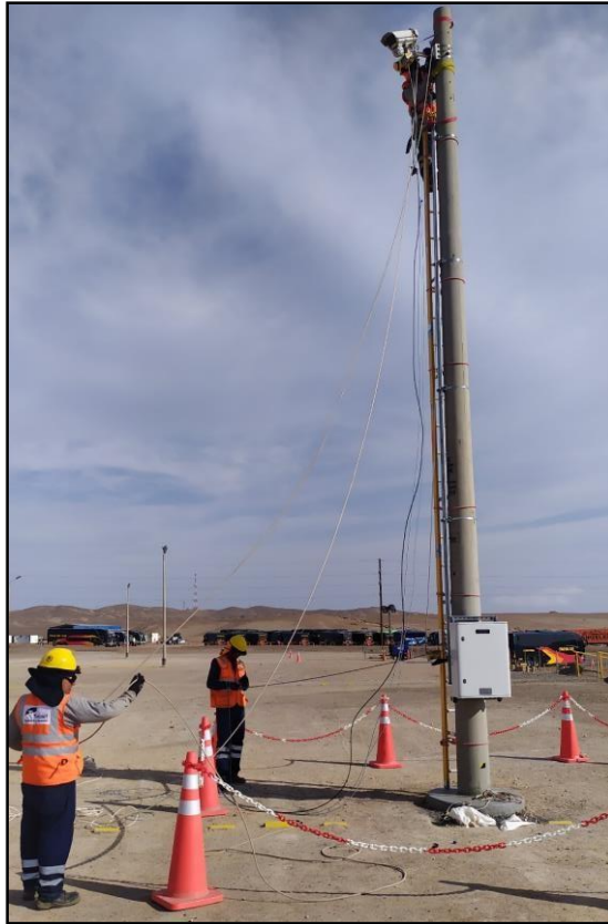
Figura 45: Montaje/instalación de tableros y cámaras en postes.
