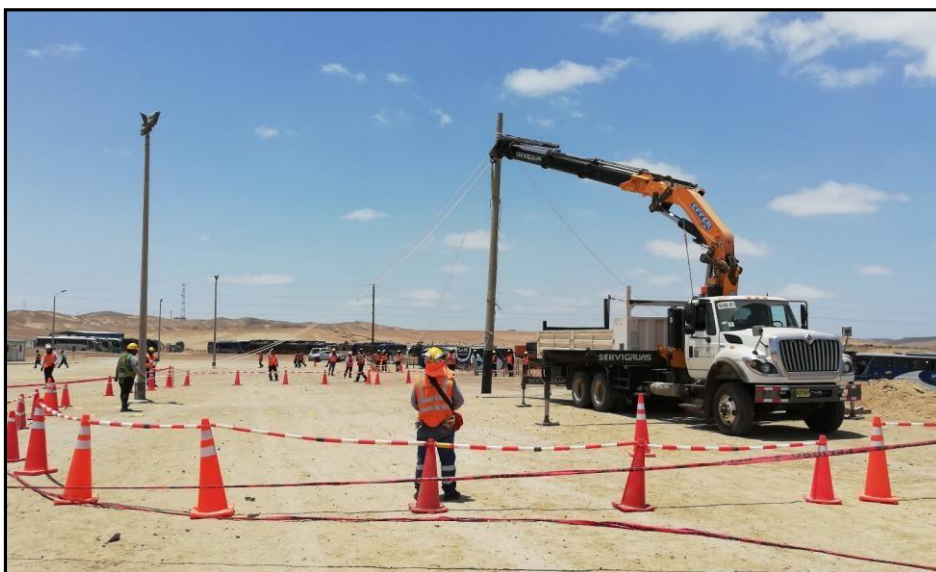
Figura 12: Izaje de poste CAC para cámara 4521-FIX-001 (Campamento).
