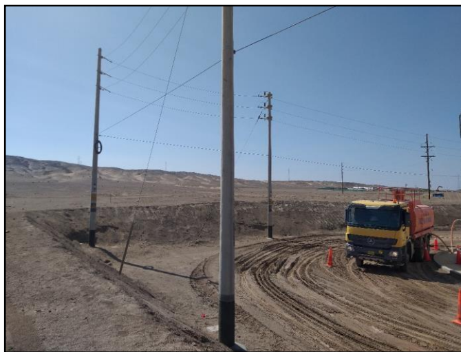
Figura 8: Campamento Permanente – PTAP.
