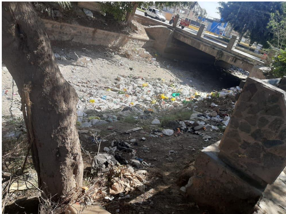
Figura 3: Puente de la Achirana en Santa Rosa, Parcona
