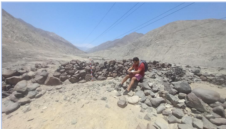
Foto N° 07 - Vista de detalle del muro con piedra canteada y piedras angulosos. Sector
