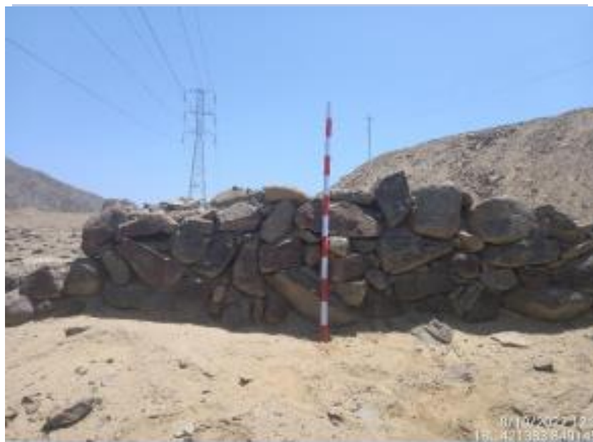
Fotos N° 18 vista de detalle del muro que presenta una construcción con piedra angulosas empleando una técnica de pircado - Sector A.
