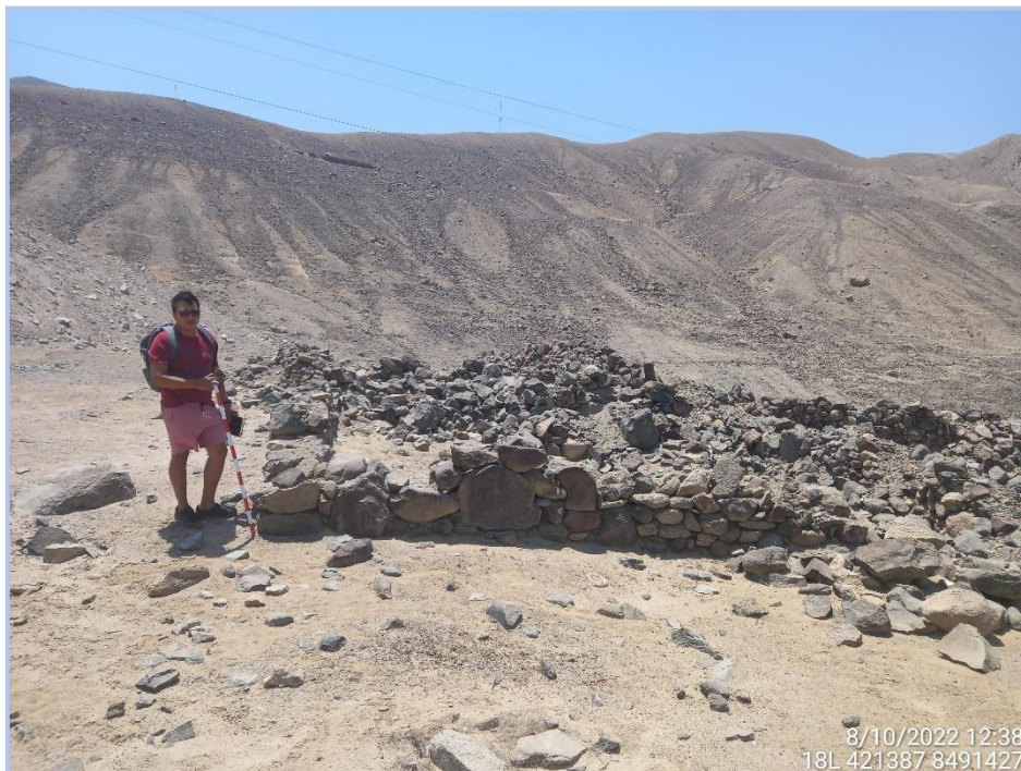
Foto N° 06 - Vista de detalle de la estructura del muro más conservada con piedra canteada y piedras angulosos Sector A
