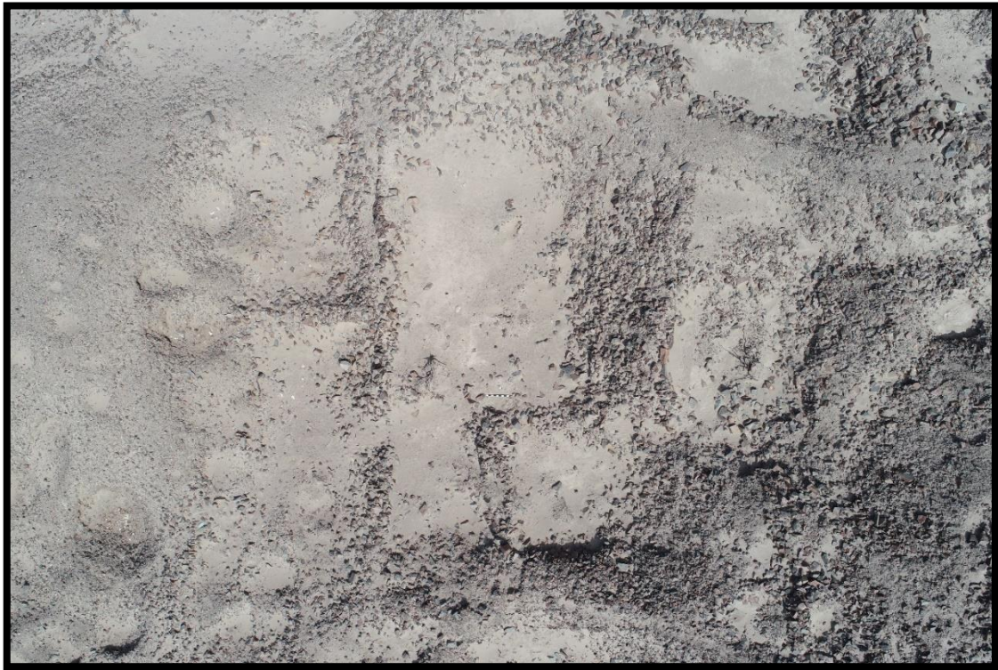
Figura 64. Fotografía de planta del S2-E01. Se observa que los muros presentan un espesor de 0.70 m aproximadamente, con una altura de 0.42 m. Fuente: Elaboración propia.
