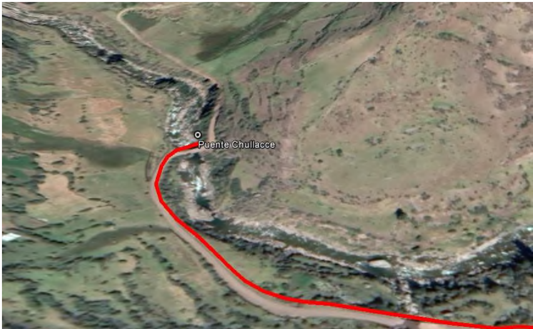
Figura 14 Fin del tramo a la altura del Puente Chullacce
