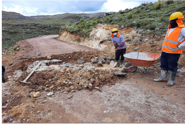
Figura 85: Construcción de baden artesanal en el KM 20+300.
