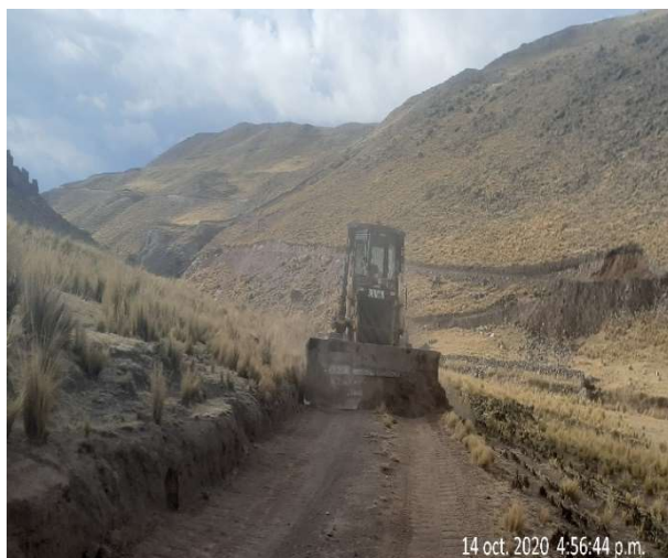
Figura 46: Perfilado de la sub rasante en el KM 5+000.
