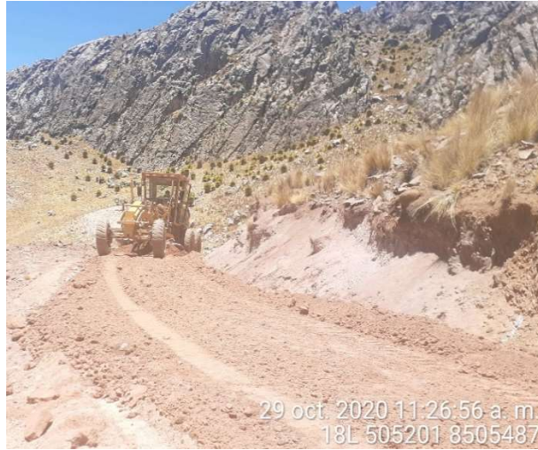
Figura 58: Batido de material granular en KM 12+780
