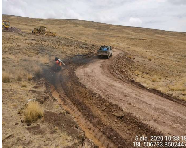
Figura 67: Reconformación de cunetas manualmente en el KM 19+100.
