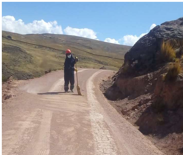
Figura 78: Limpieza de calzada en el KM 2+300.
