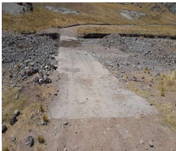
Figura 29: Baden de concreto en el KM 13+650.
