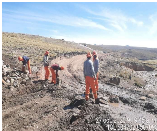
Figura 68: Construcción de baden artesanal en el KM 10+800.
