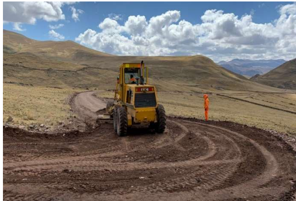
Figura 93: Escarificado del material granular existente en el KM 2+500.
