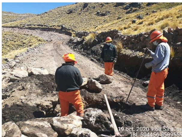
Figura 70: Construcción de alcantarilla artesanal en el KM 6+200.
