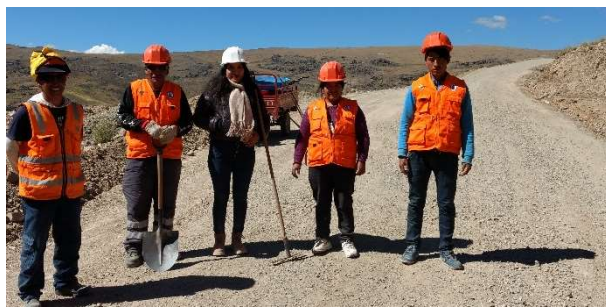
Figura 77: Capacitación al personal en el KM 9+400.
