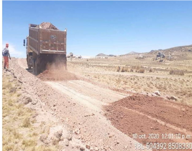
Figura 55: Tendido de material granular KM 9+030
