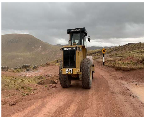
Figura 97: Compactado de material granular en la calzada en el KM 8+950.
