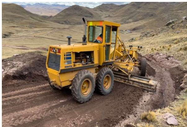
Figura 94: Batido del material granular en el KM 22+000.
