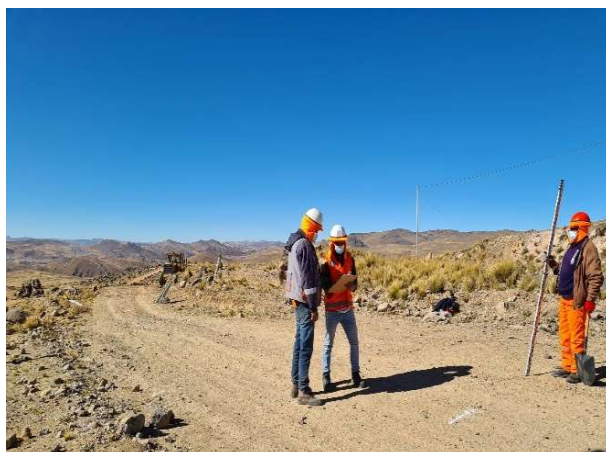
Figura 44: Trazo y replanteo en el KM 1+150.
