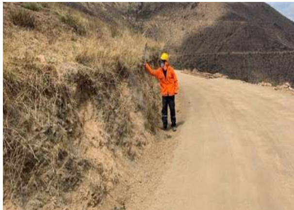
Figura 86: Roce y limpieza en el KM 6+200.
