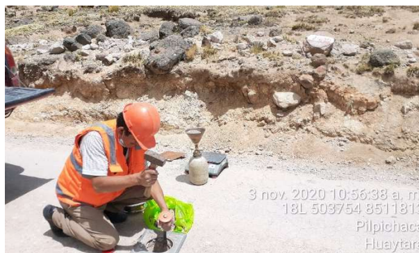
Figura 98: Perforación de la capa de control en el KM 2+600.
