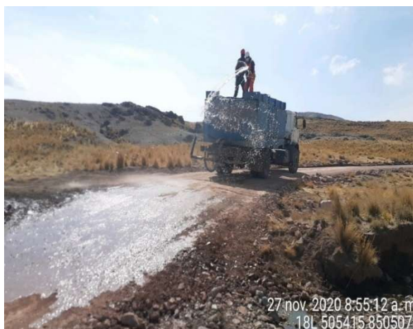
Figura 62: Riego de la capa de rodadura en el KM 13+620
