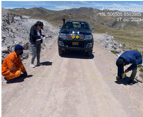
Figura 118: Medición del ancho existente de calzada en el KM 16+570.
