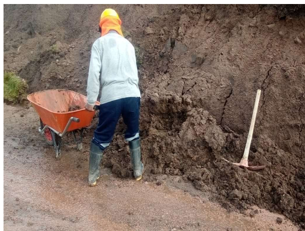
Figura 80: Remoción de Derrumbes en el KM 24+900.
