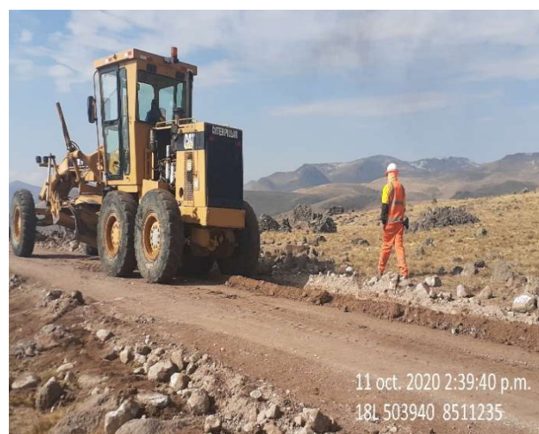
Figura 66: Reconfiguración de cunetas KM 3+680
