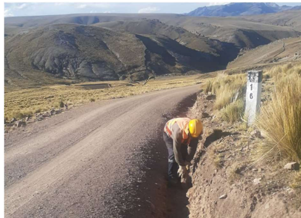
Figura 83: Limpieza de cunetas KM 16+000
