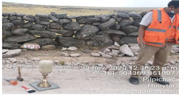
Figura 99: Ensayo Cono de arena KM 5+000
