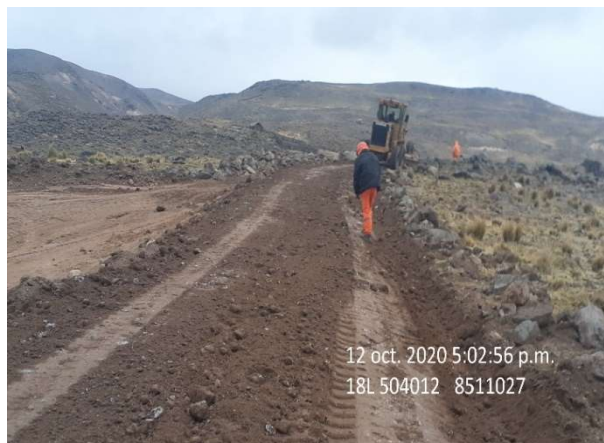
Figura 57: Batido y perfilado en KM 3+900
