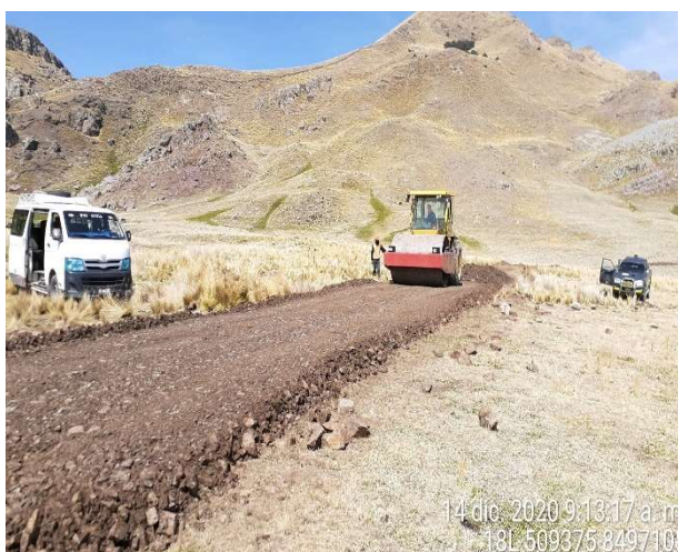
Figura 65: Compactación de afirmado en el KM 26+870
