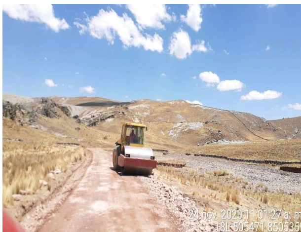
Figura 64: Proceso de Compactación en el KM 13+350
