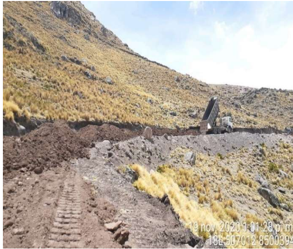
Figura 56: Tendido de material granular KM 21+680
