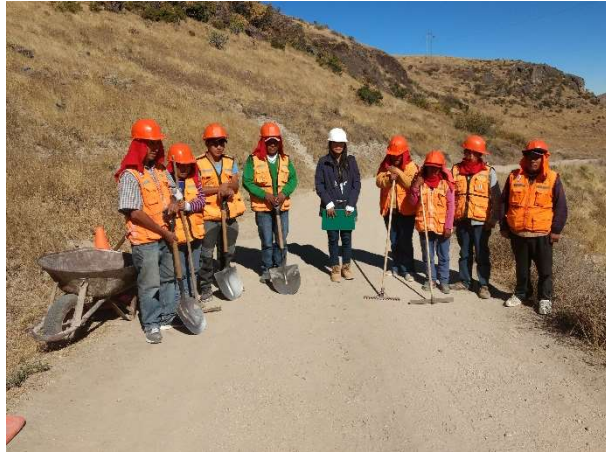
Figura 76: Control de herramientas para ejecución en el KM 21+450.
