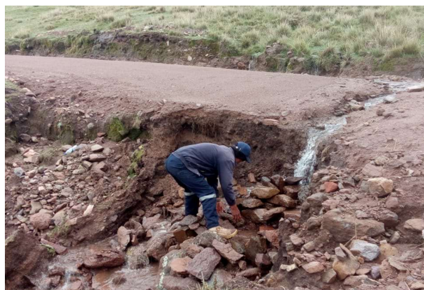
Figura 84: Encauzamiento de cursos de agua en el KM 23+800.
