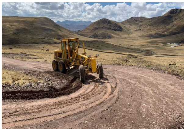
Figura 95: Perfilado del material granular en el KM 22+500.
