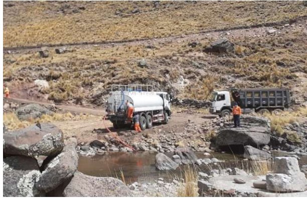
Figura 106: Control de tiempo de llenado de cisterna en el rio ubicado en KM 6+754.
