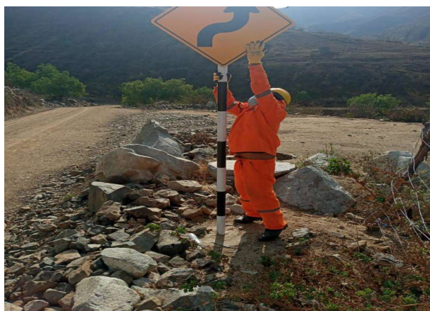
Figura 72: Instalación de señal preventiva en el KM 11+322.
