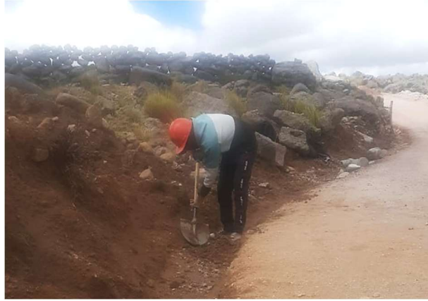
Figura 82: Limpieza de cunetas en el KM 5+100.
