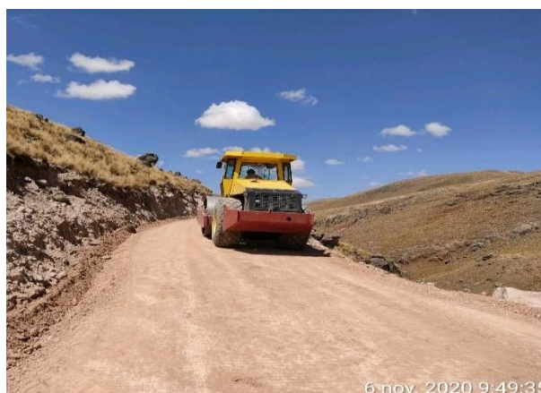
Figura 63: Compactación de material granular en el KM 6+300
