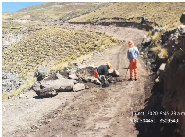
Figura 69: Construcción de alcantarilla artesanal en el KM 6+450.
