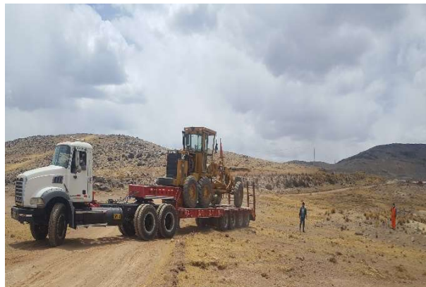
Figura 104: Llegada de la motoniveladora a la zona del proyecto.
