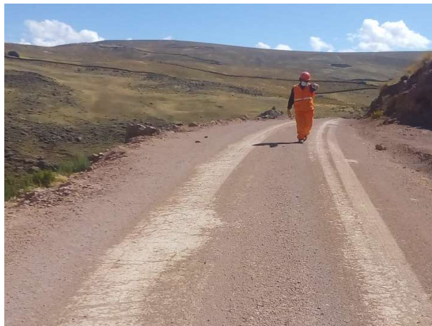
Figura 92: Vigilancia y control – jefe de cuadrilla en el KM 9+650.
