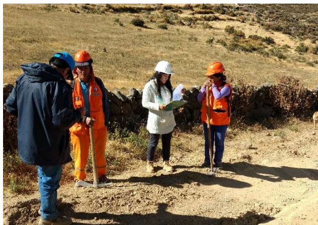
Figura 107: Control del avance de trabajos ejecutados en el KM 18+300.
