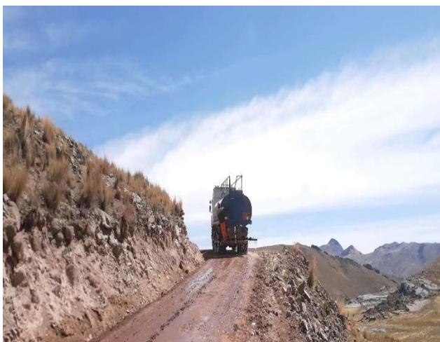
Figura 96: Riego de la calzada en el KM 7+400.
