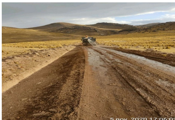
Figura 61: Riego del material granular en el KM 9+000.
