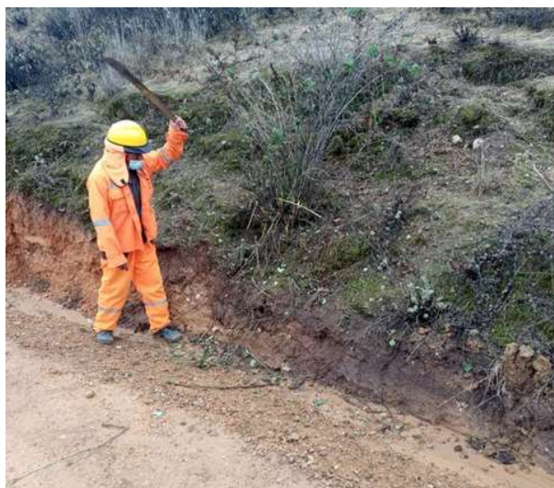
Figura 87: Trabajos de roce de vegetación en el KM 14+800.
