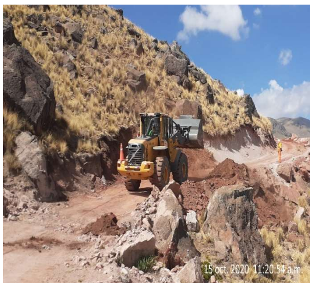
Figura 47: Mejoramiento de puntos críticos en el KM 7+300.
