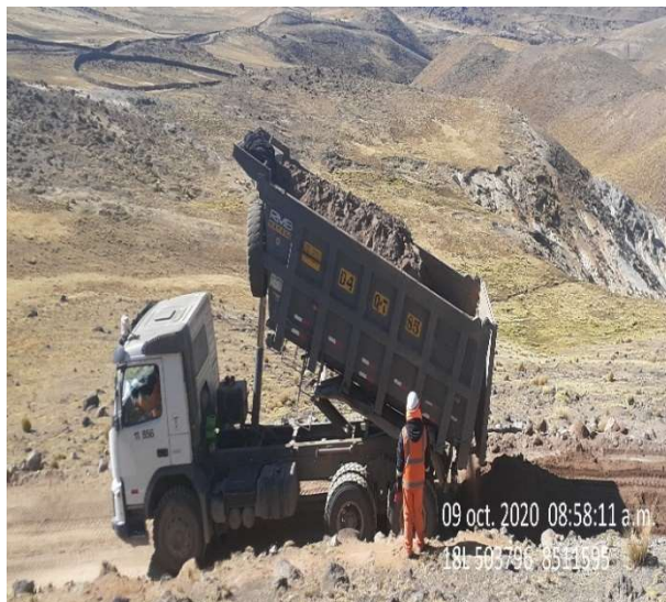
Figura 54: Tendido de material granular KM 3+270.
