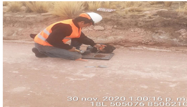
Figura 100: Ensayo de densidad de campo KM 11+950
