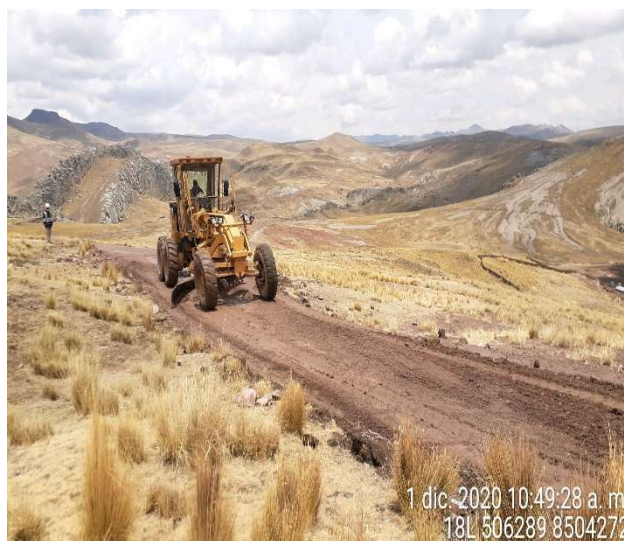
Figura 60: Batido de material granular en KM 15+810
