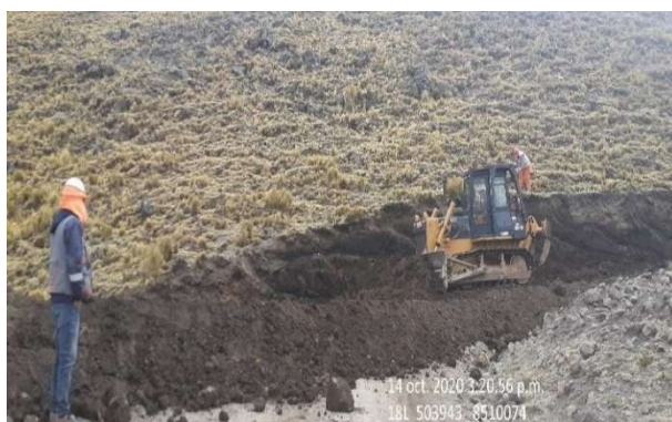
Figura 45: Ampliación de curvas empleando tractor sobre oruga en el KM 5+620.
