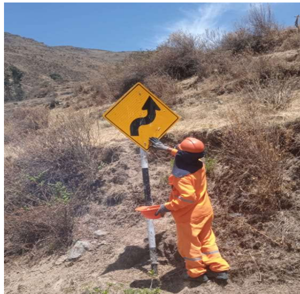
Figura 89: Mantenimiento de señal preventiva en el KM 20+240
