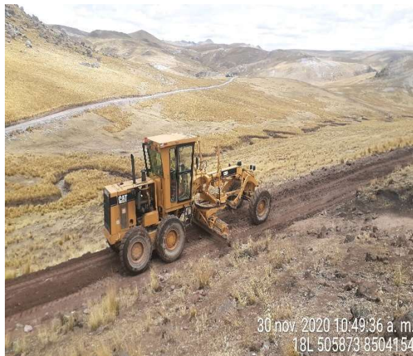
Figura 59: Batido de material granular en KM 15+340
