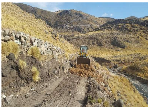
Figura 51: Esparcido del material para capa nivelante en el KM 6+500.
