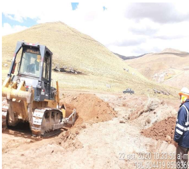
Figura 49: Explotación de la Cantera 02 en el KM 9+200.
