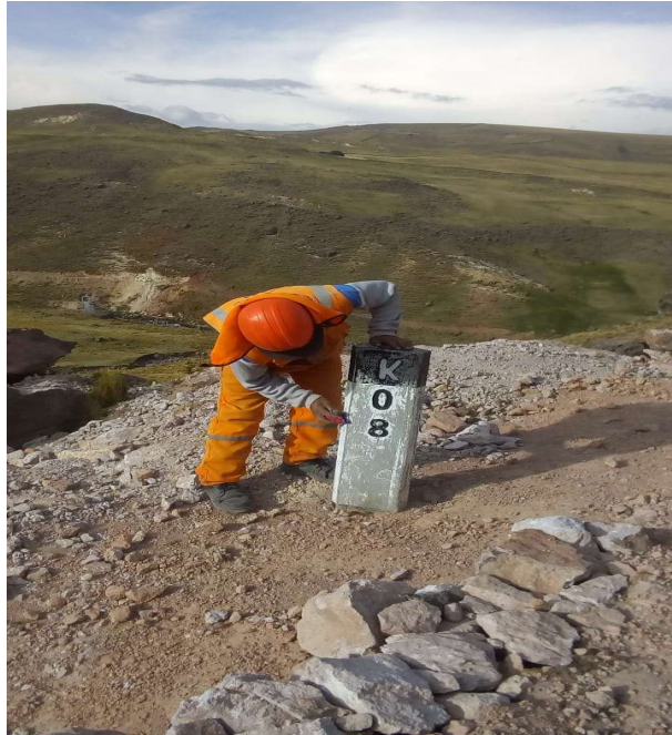
Figura 88: Mantenimiento de hito kilométrico en el KM 8+000.
