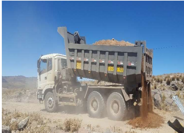
Figura 52: Tendido de material granular transportado en el KM 0+600.
