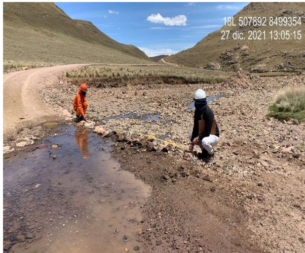
Figura 121: Cruce de agua existente en el KM 23+800.
