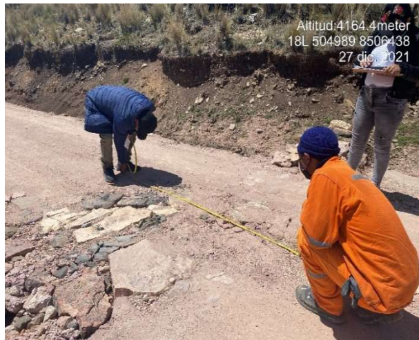
Figura 113: Medición del cruce de agua existente en el KM 11+700.
