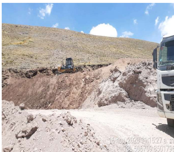
Figura 50: Explotación de la Cantera 03 en el KM 19+760.
