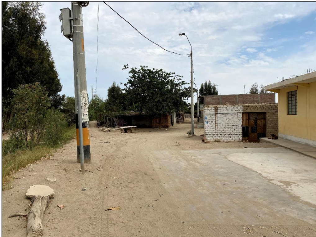
FIGURA No.31 SITUACION ACTUAL TRAMO 3
