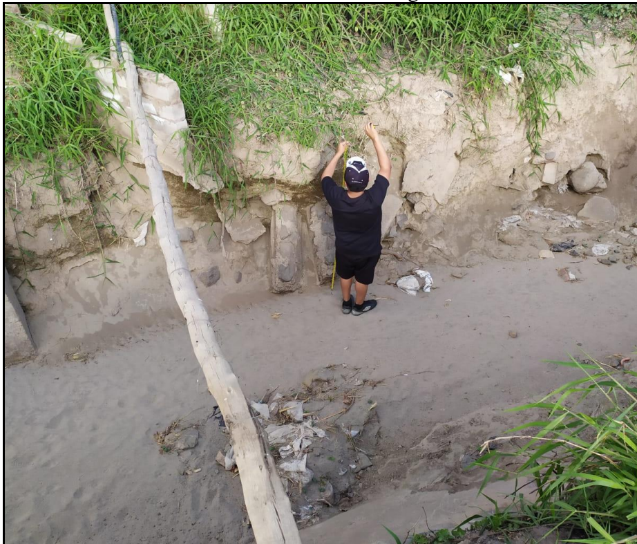
Foto 19 Vista Frontal del canal de regadío 75
