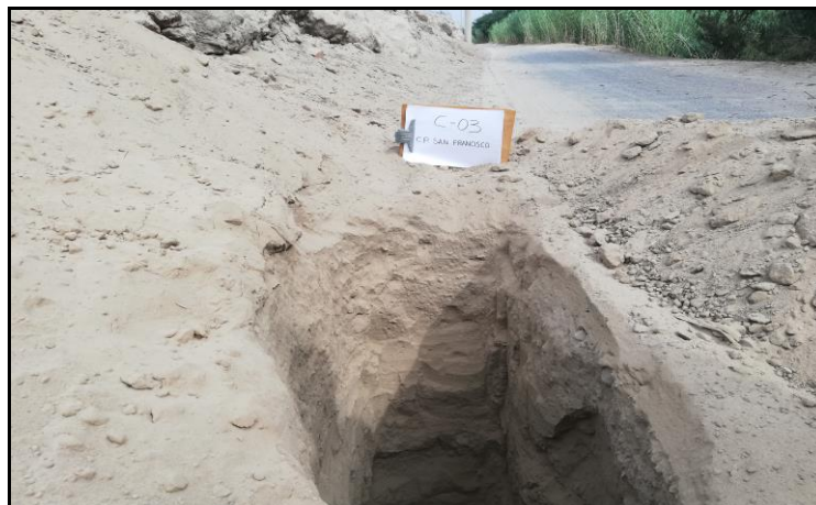
Foto 12 EXCAVACIÓN DEL POZO No.03
