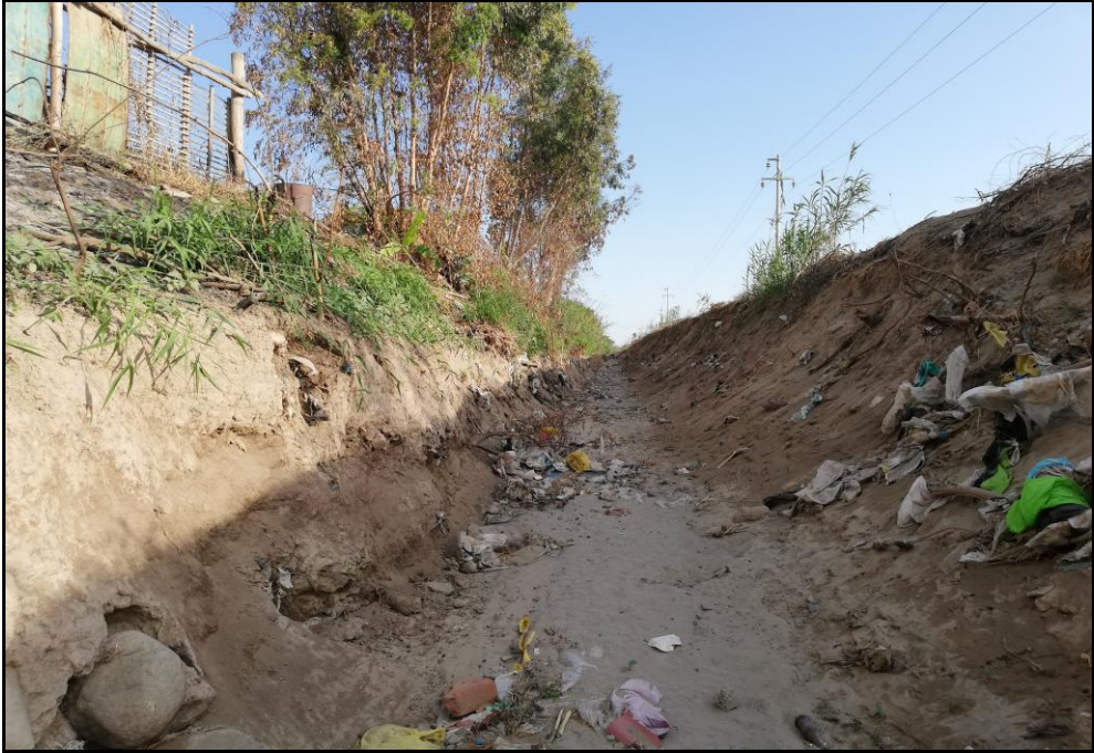
Foto 18 Vista Frontal del canal de regadío 75
