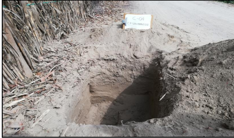
Foto 13 EXCAVACIÓN DEL POZO No.04
