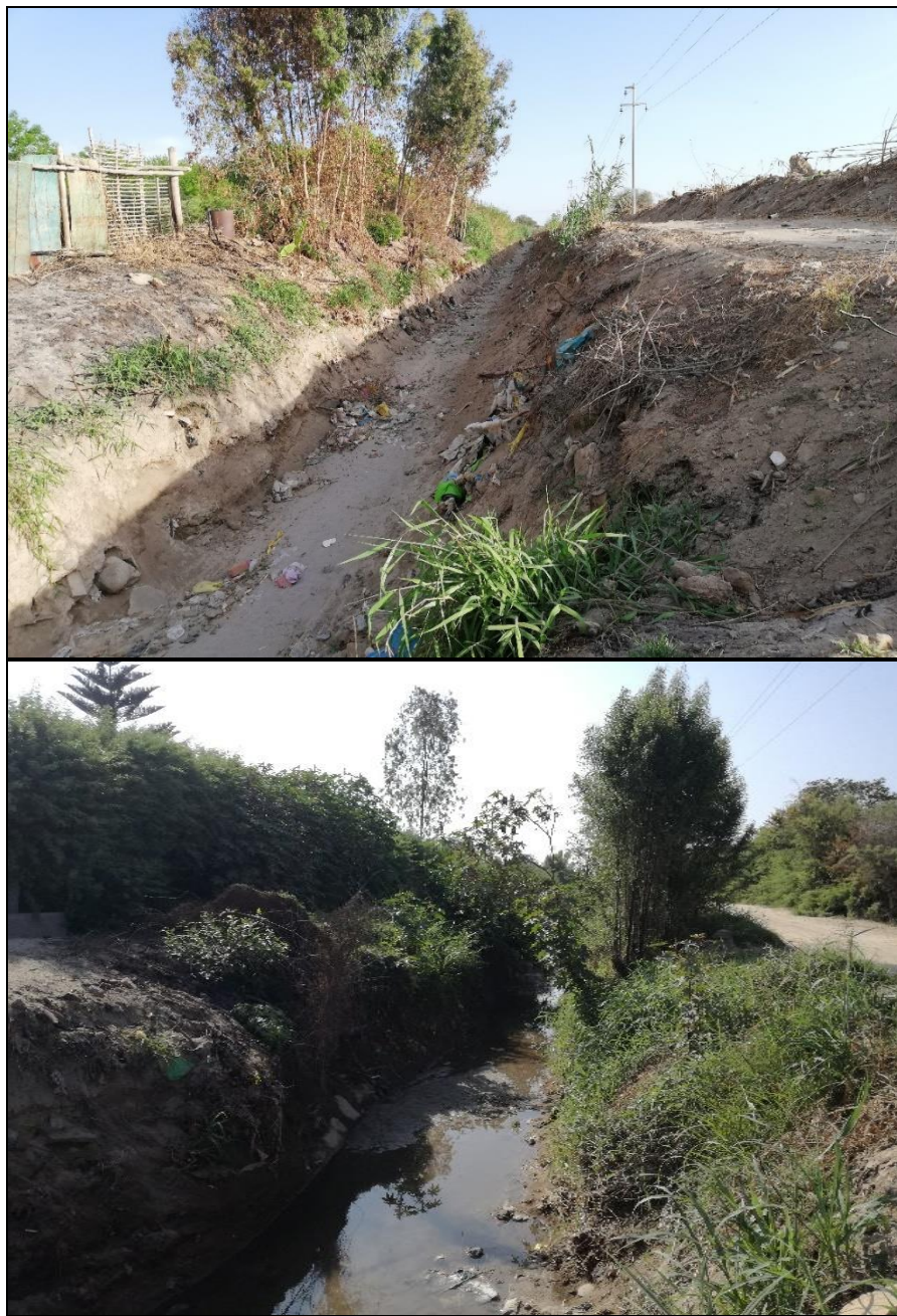
FIGURA No.30 SITUACION ACTUAL TRAMO 2
