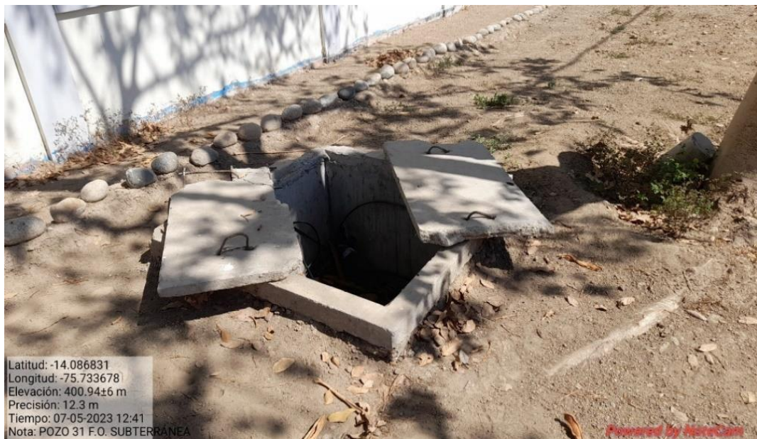
Fig. 6. Pozo subterráneo descubierto. [Fuente Propia]
