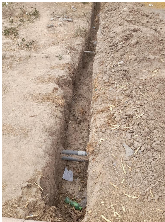
Fig. 5. Zanja para los ductos de fibra óptica. [Fuente Propia]
