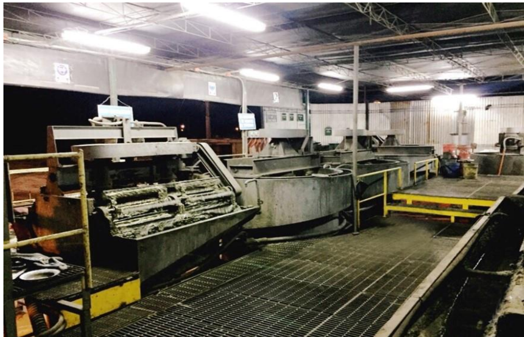
Figura N°21.- Celdas de Flotación
