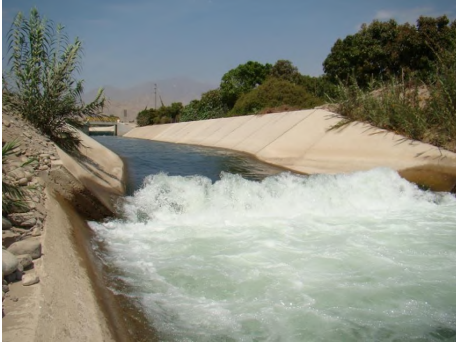
Figura 67. Canal de riego La Achirana
