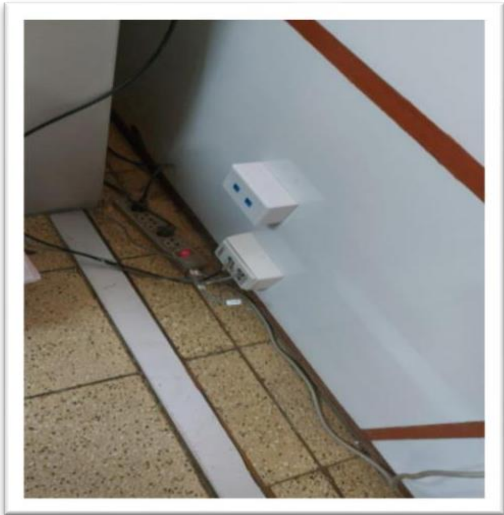
Fig. 10: Ponchado de Jack Cat 6 (Identificadores de puntos de red )
