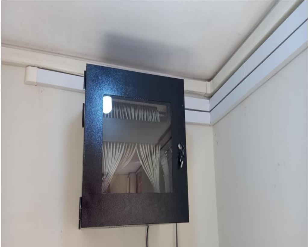
Fig. 8: Instalación del Gabinete
