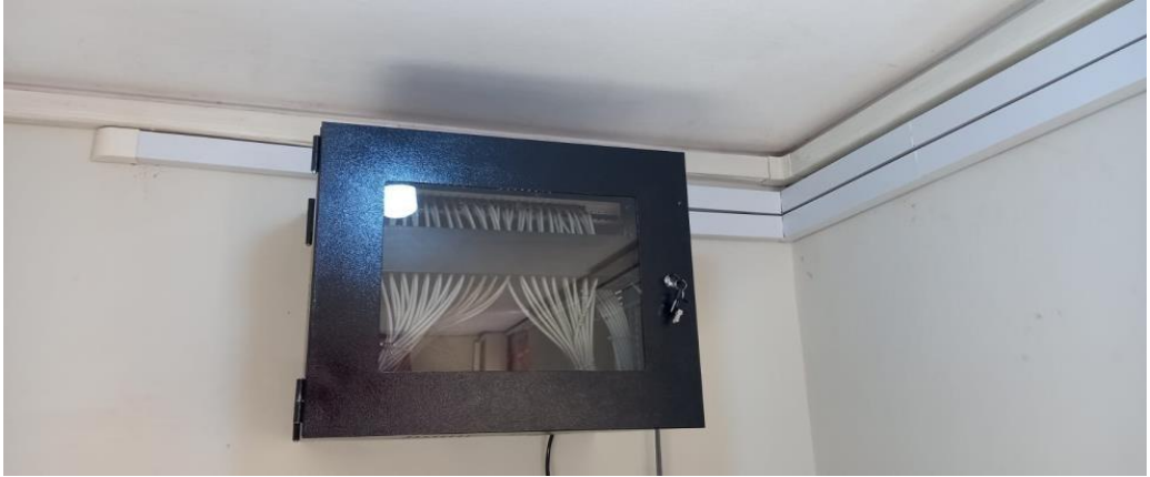
Fig. 17: Instalación del Gabinete
