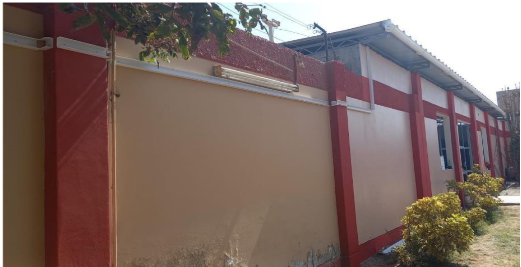
Fig. 18: Recorrido de las canaletas.
