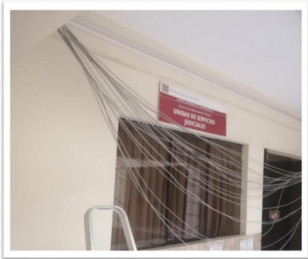
Fig. 19: Implementación e Tendido de cableado estructurado.
