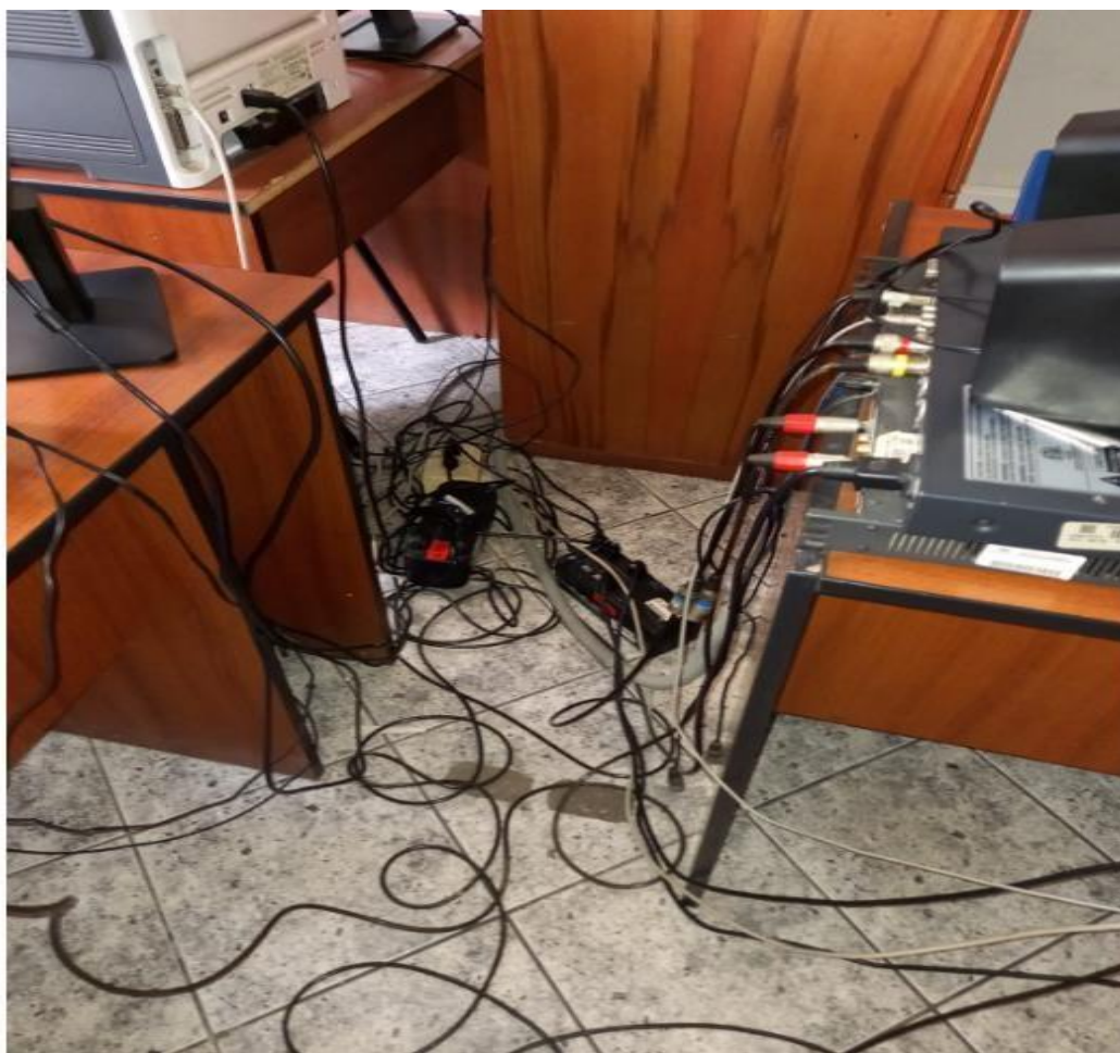
Fig. 13: Estado situacional de Sala de Audiencias.
