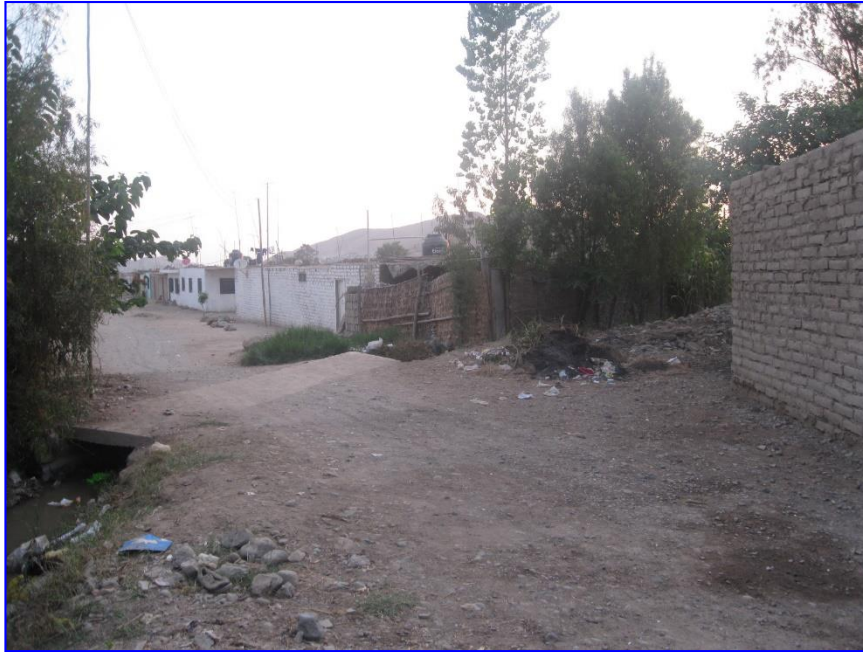
FOTO N° 03: Se observa el pase de concreto sobre el canal, el cual se mantendrá en el proyecto.
