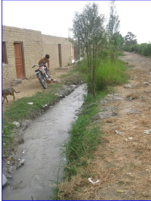
FOTO N° 07: Vista del tramo del canal frente a la manzana B, se observa en ancho del camino de vigilancia a utilizar en el nuevo trazo.
