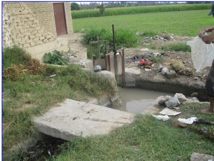
FOTO N° 12: Se observa el punto final del tramo en estudio en el encuentro con el canal principal.
