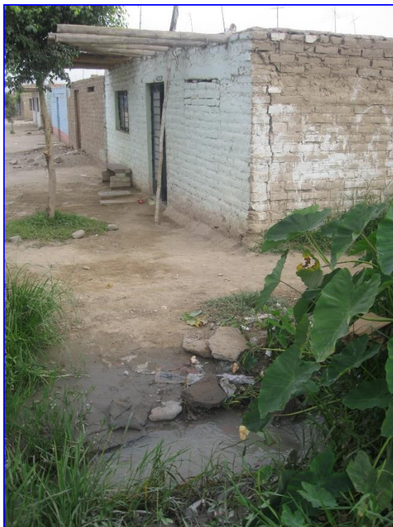
FOTO N° 06: Otra vista del canal luego de la curva donde se construirá la alcantarilla N°1.
