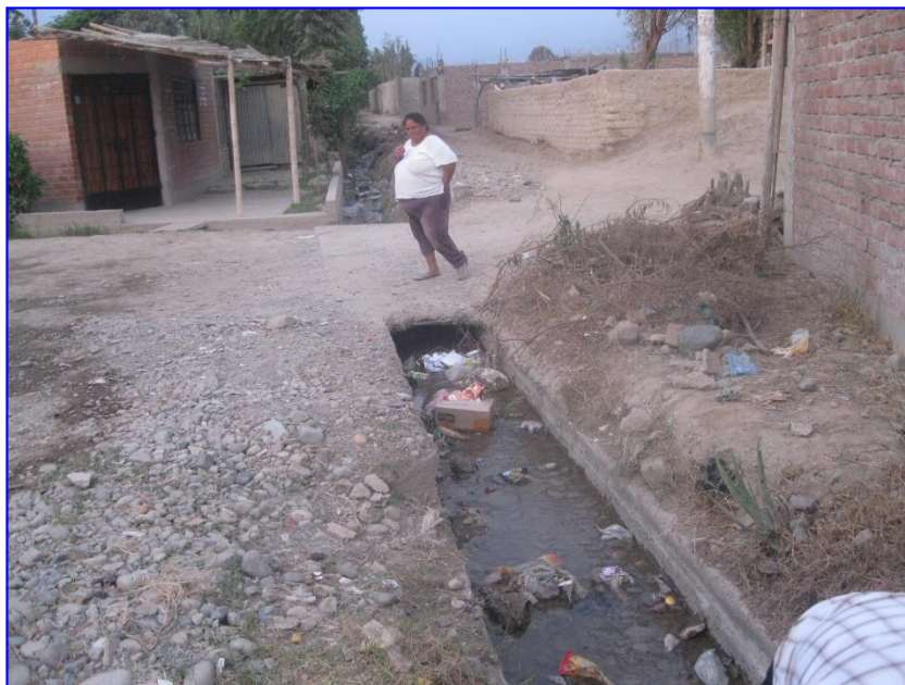
FOTO N° 01: Vista del punto de inicio del tramo analizado, se observa un tramo revestido con concreto totalmente sucio.
