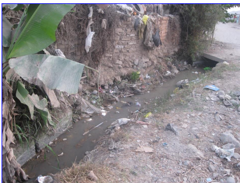
FOTO N° 02: Vista de la continuación en el primer tramo a revestir antes del pase vial.
