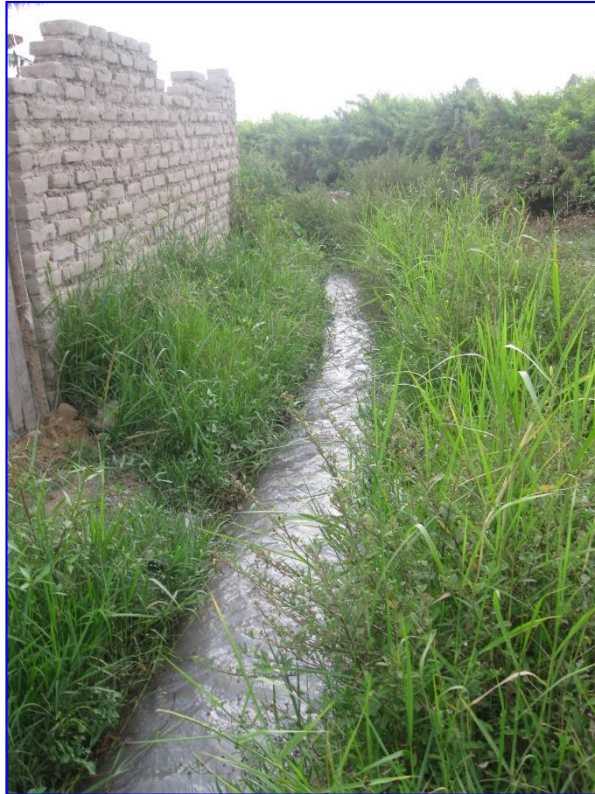
FOTO N° 05: Se observa el tramo del canal detrás de la manzana A, en su parte final antes de la curva.
