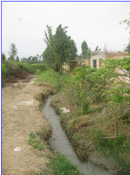
FOTO N° 08: Se observa el tramo del canal frente a la manzana C, se observa las malezas y arbustos.
