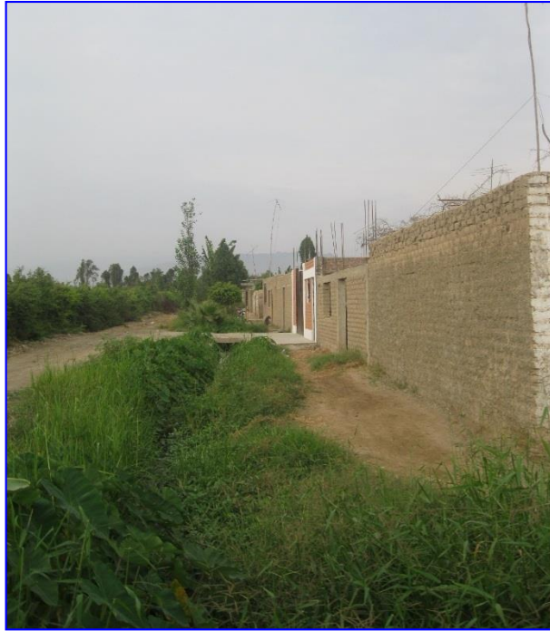
FOTO N° 09: Se observa el tramo del canal frente a la manzana C, existen algunos pases sobre el canal, este será retirado 4.5m del frente de las casas.
