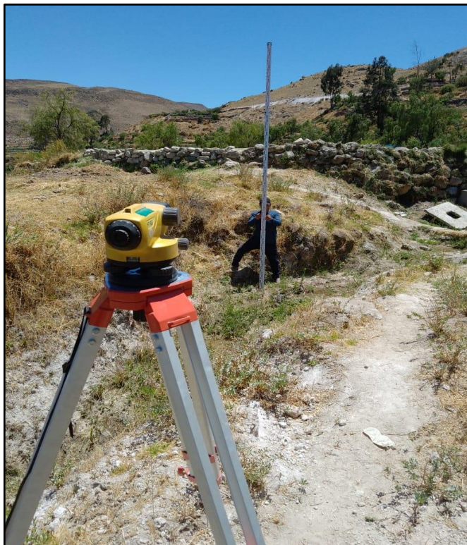
Foto 1: Haciendo el levantamiento topográfico del canal.
