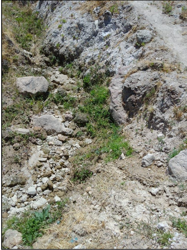
Foto 3: Vista del canal sin agua en época de sequía.
