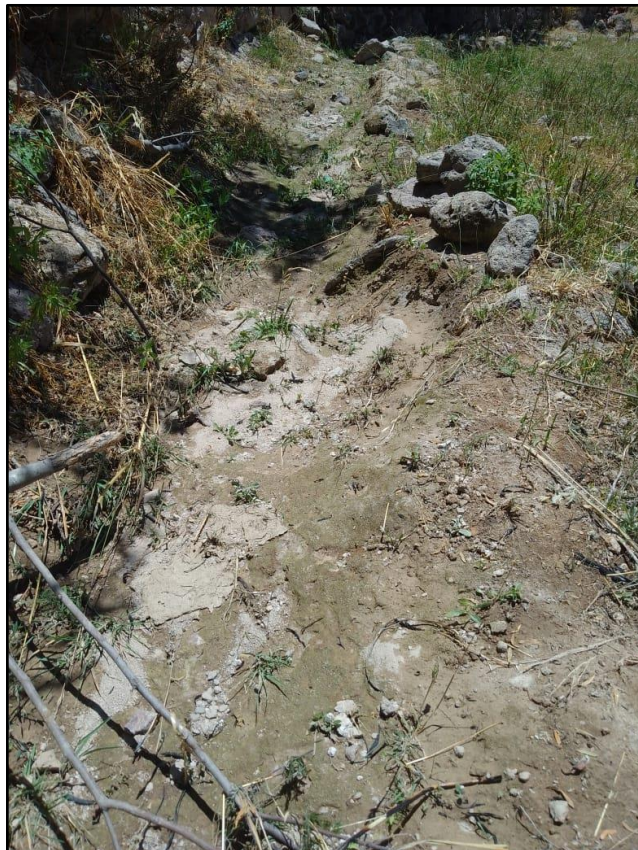
Foto 6: Vista de zona de desborde en el canal.
