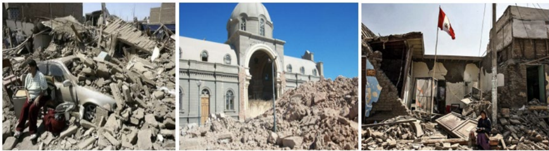
Figura 18. Fotografías tomadas en Ica después del terremoto del 15 de agosto del año 2007. Elaboración: Propia. Fuente: Google imágenes / Artículos de medios de comunicación locales.
