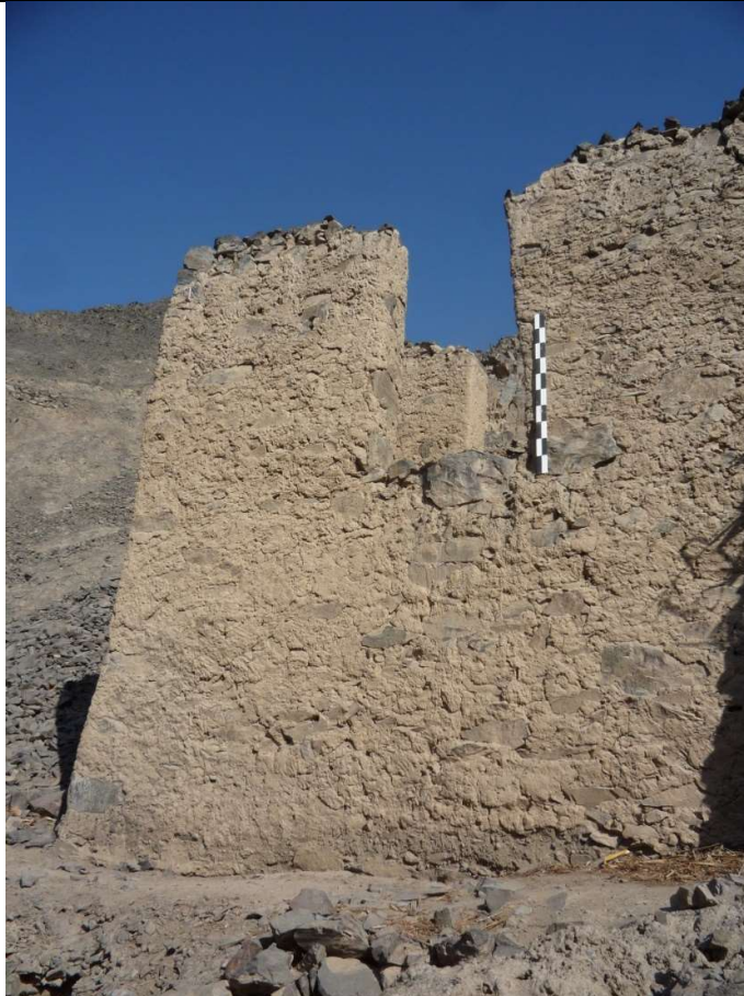
Foto 21: Vano de acceso trapezoidal en el Conjunto 4. Neyva Aparcana; 2022
