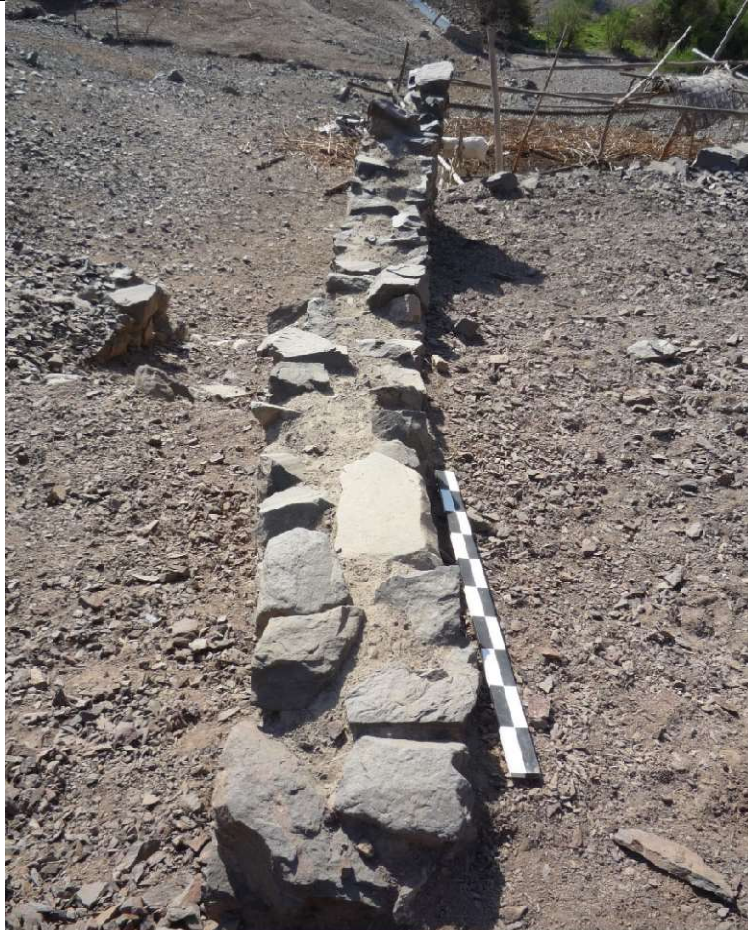
Foto 17: Muro del Conjunto 3, nótese la técnica constructiva conformada por dos hiladas de piedras en paralelo con un relleno de barro entre ellas. Neyva Aparcana; 2022
