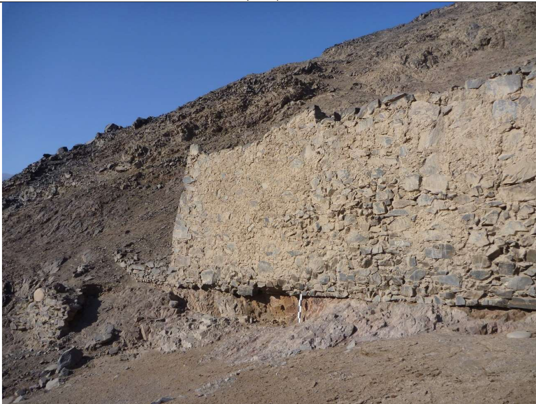
Foto 15: Corte de la roca firme para la construcción del muro de contención en el Conjunto 2. Neyva Aparcana; 2022
