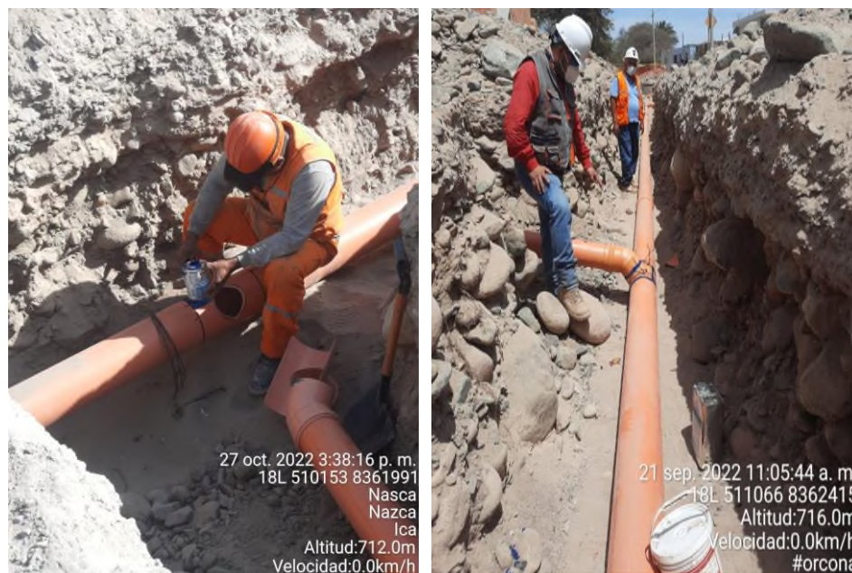
Figura 37. Verificación de la correcta instalación de las tuberías
