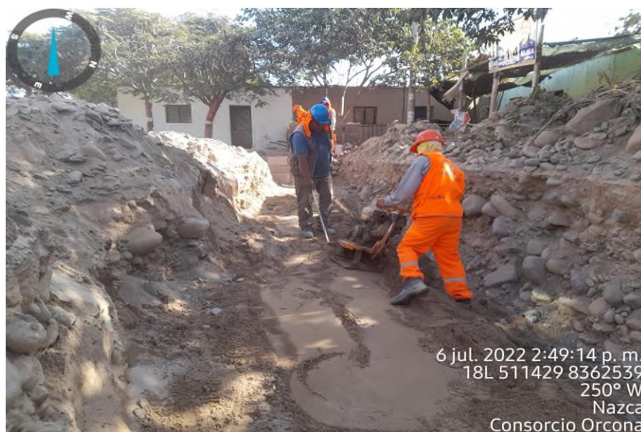
Figura 52. Compactación de protección de tubería
