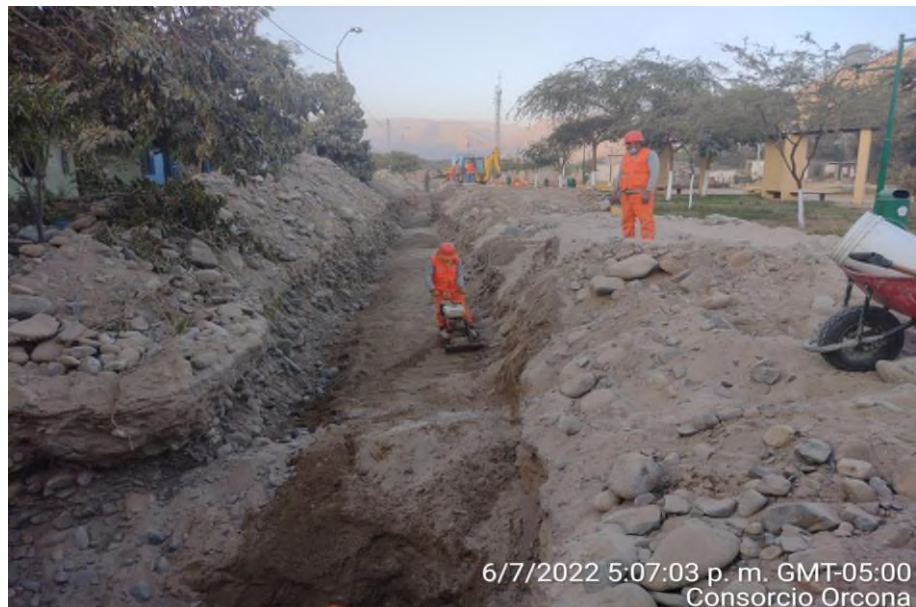
Figura 54. Compactación de relleno de zanja
