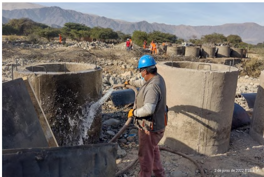
Figura 36. Curado de concreto en buzones
