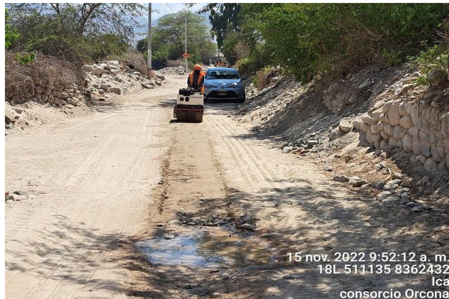
Figura 55. Compactado de afirmado
