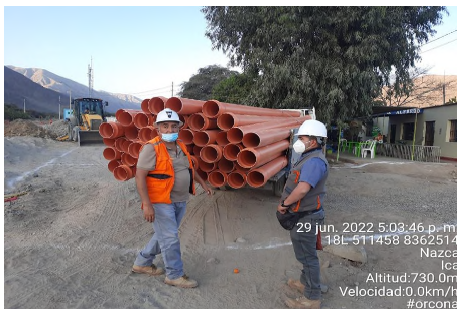
Figura 44. Transporte de tubería
