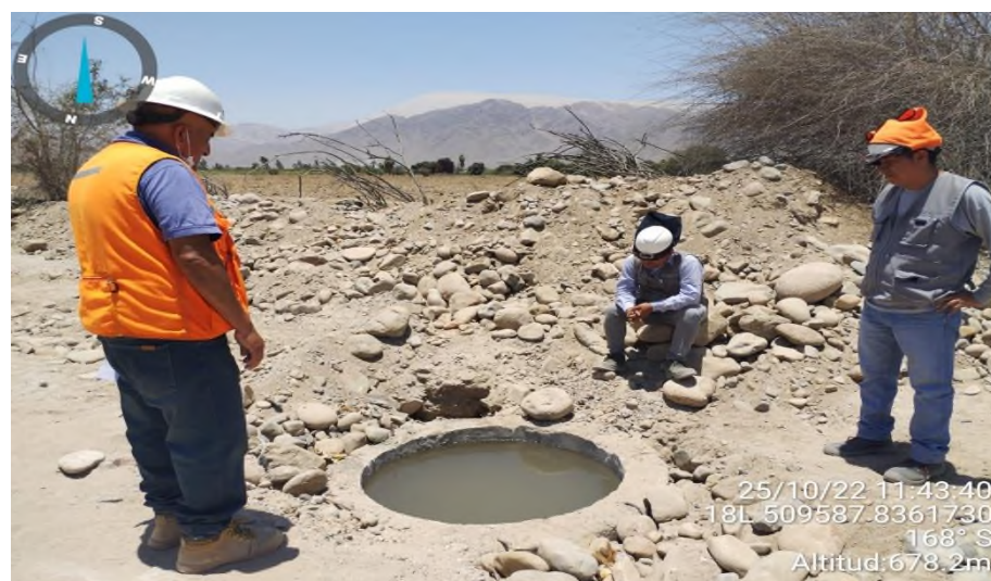
Figura 40. Prueba hidráulica de la red de alcantarillado
