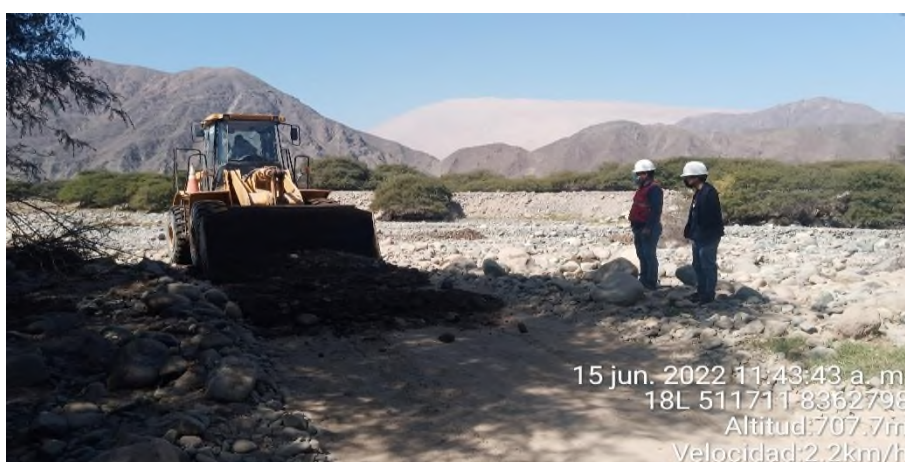
Figura 78. Habilitación de la ruta de desvío vehicular
