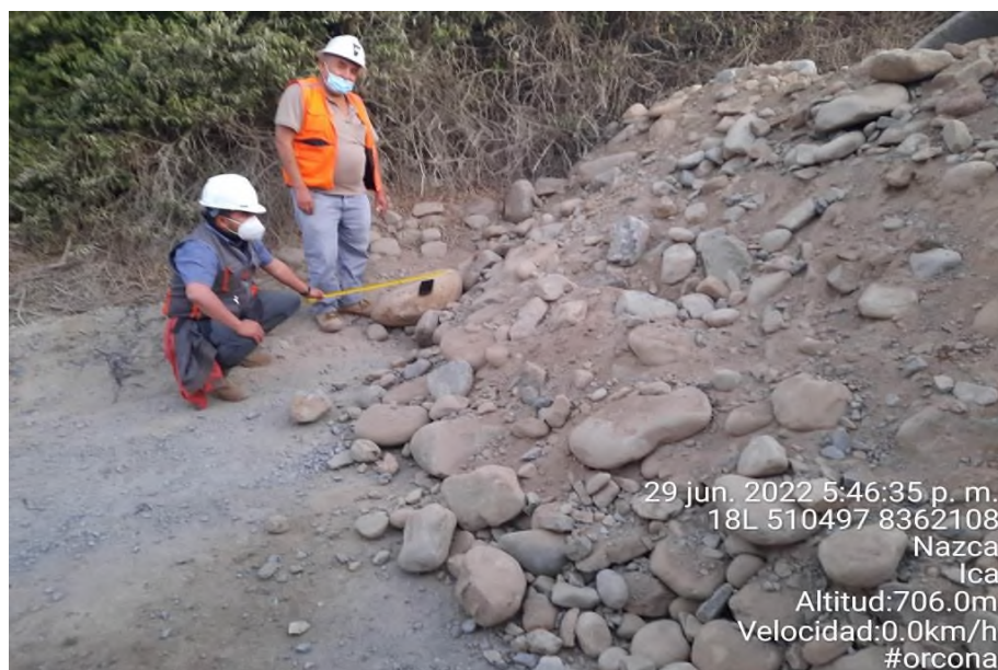
Figura 18. Ing. Residente y Supervisor corroborando las piedras excavadas En compañía con la supervisión, se dejó constancia la presencia de bolonerías de 3” a 20” aproximadamente producto de la excavación de zanja para buzón.
