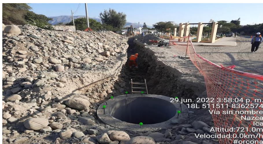
Figura 23. Excavación de zanja donde se aprecia la gran cantidad de boloneras. Se constata la presencia gran porcentaje de boloneras de gran tamaño y cantidad, producto de la excavación de zanja para la red de alcantarillado en el sector de Orcona.
