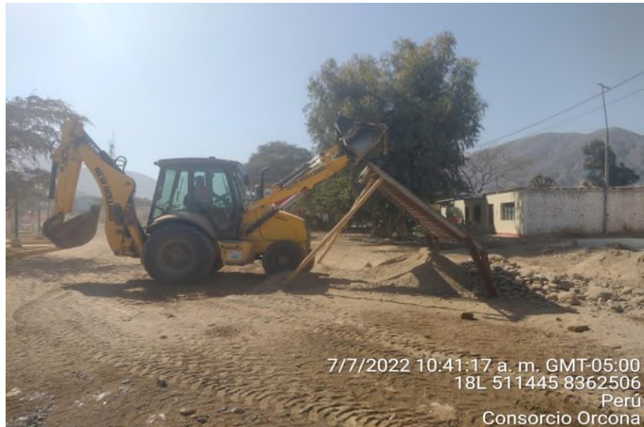
Figura 53. Zarandeo para relleno de zanja
