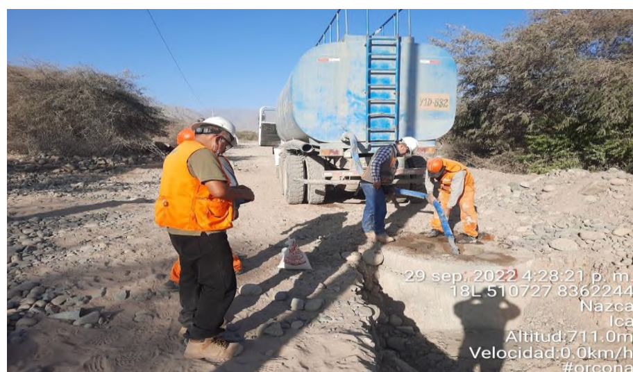
Figura 41. Prueba hidráulica de la red de alcantarillado
