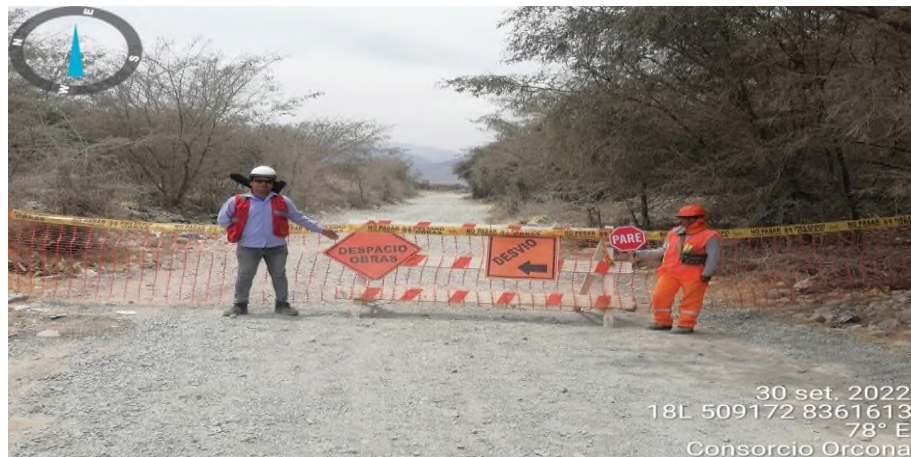
Figura 70. Cierre del tránsito vehicular y señalizado.
