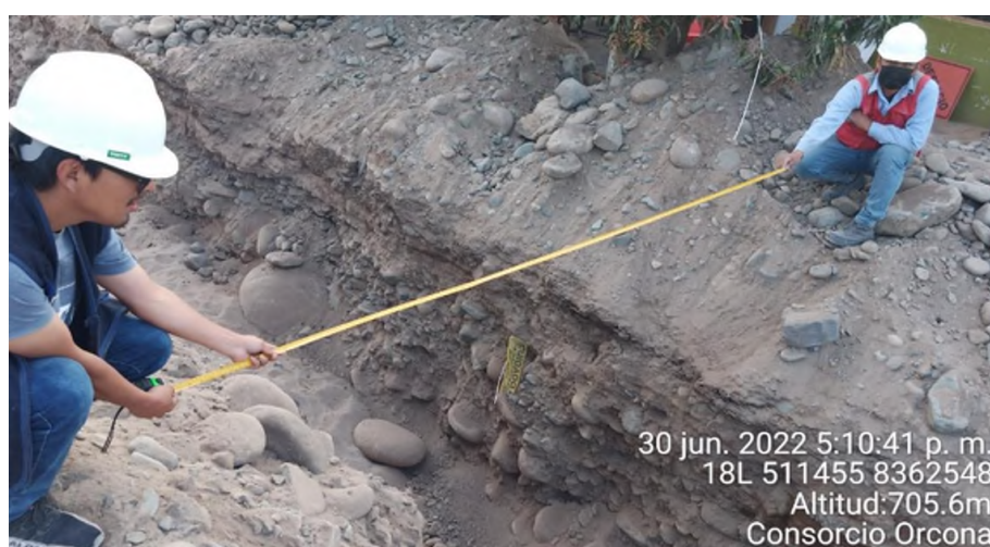
Figura 22. Ancho de zanjas excavados
