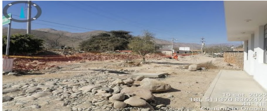
Figura 69. Enmallado de zanjas excavadas para evitar accidentes
