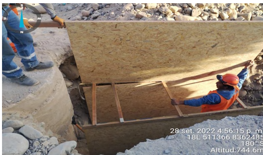
Figura 73. Entibado para protección de zanjas
