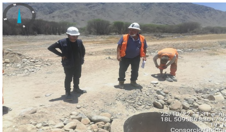
Figura 39. Prueba hidráulica de la red de alcantarillado
