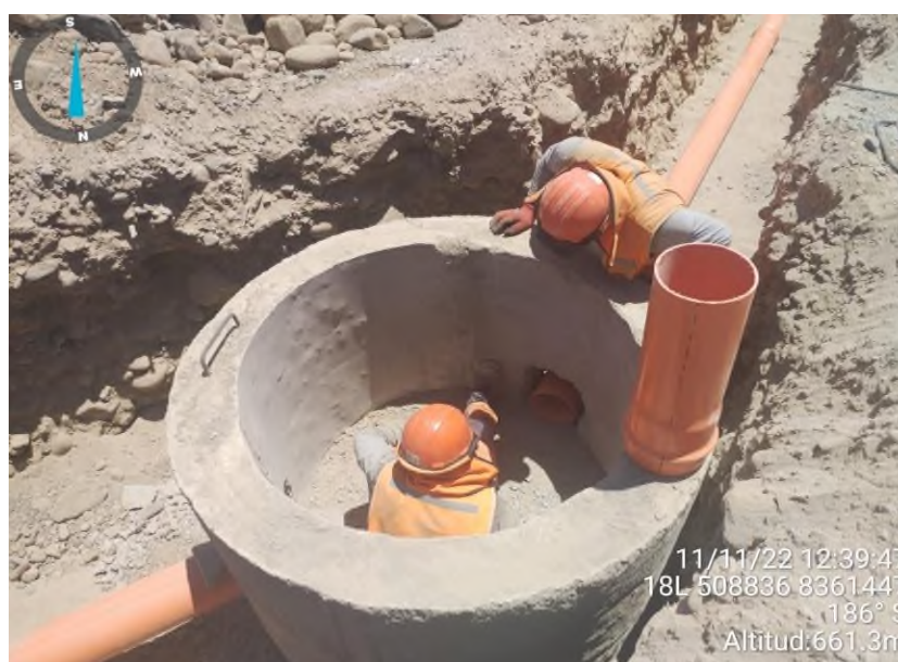
Figura 38. Emboquillado de entre tubería y buzón
