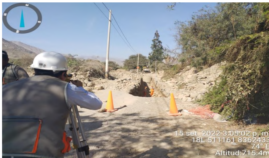
Figura 6. Corroboración de los niveles de fondo de la zanja y pendiente.
