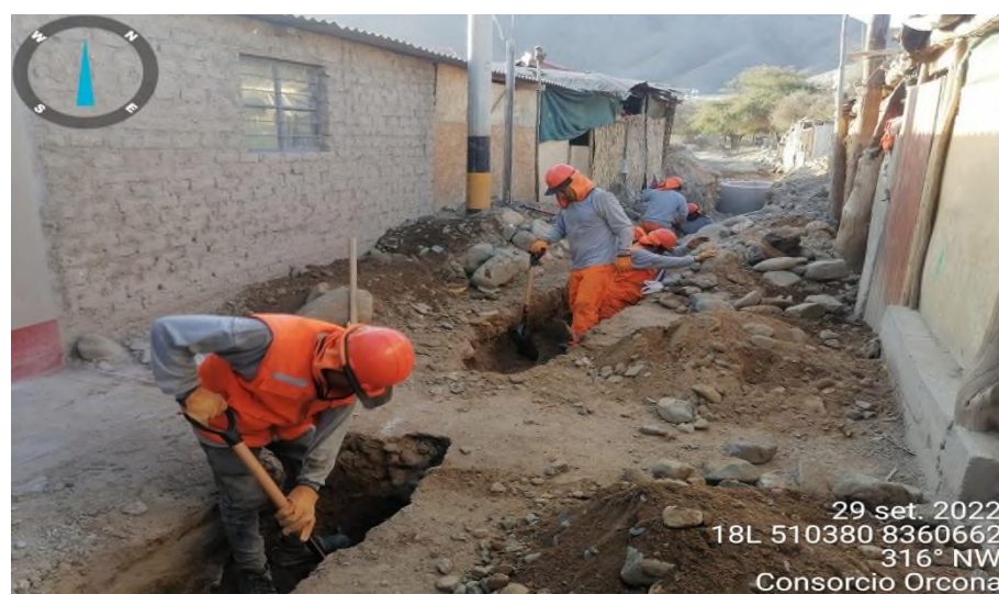
Figura 51. Excavación manual en vías angostas
