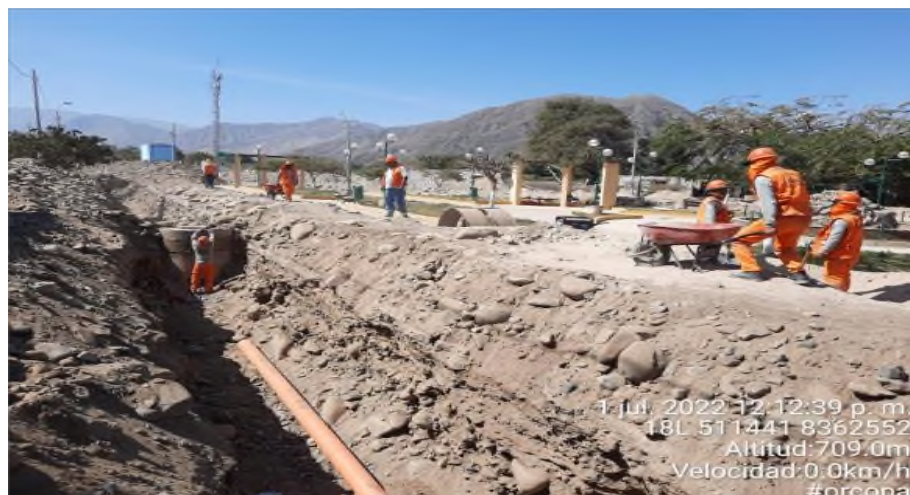
Figura 21. Zanjas excavadas para la red de alcantarillado
