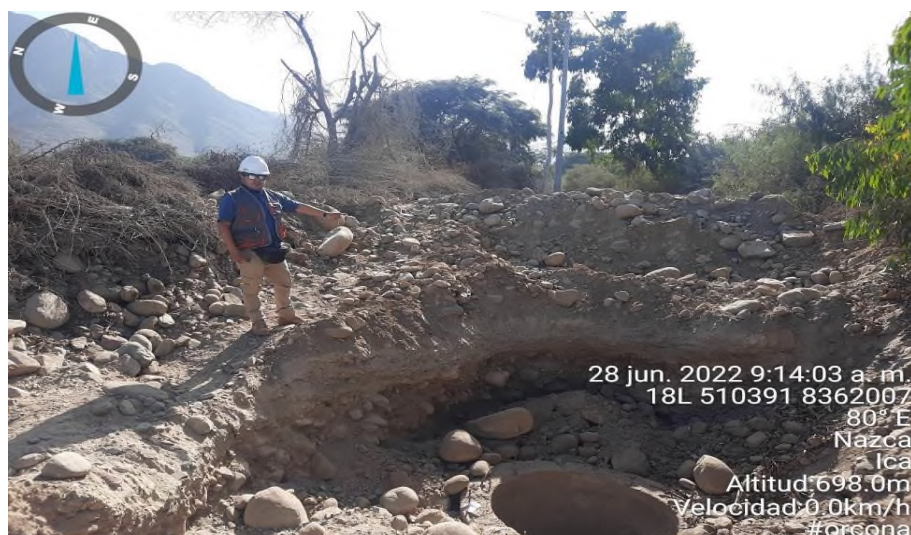
Figura 19. Verificación del material excavado donde se ve bolonerías de 3” a 20” Se verifica la presencia de bolonerías de 3” a 20” aproximadamente producto de la excavación de zanja para el buzón – BZ-28.
