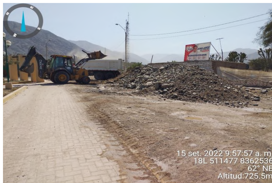
Figura 57. Eliminación de material excedente
