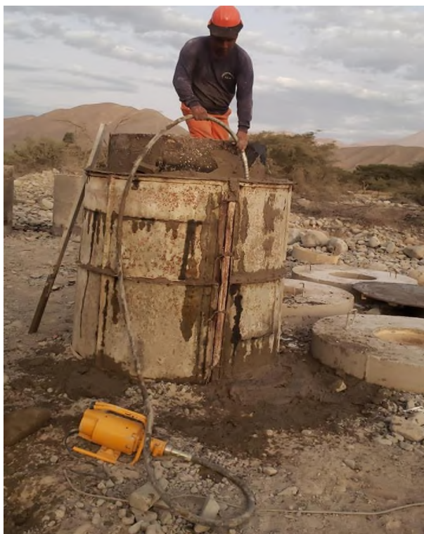
Figura 35. Vibrado de buzón de concreto
