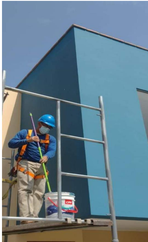
Figura 26: Trabajo en altura
