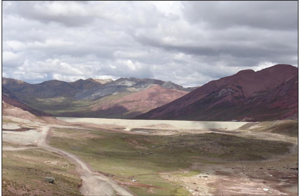
**FOTO N° 03.-**Vista panorámica del dique de la Relavera El Porvenir, donde se ha realizado los trabajos de recrecimiento de la segunda berma secundaria para alcanzar la corona para tener un ancho suficiente para los trabajos de anclaje de geomembrana y tránsito vehicular.
