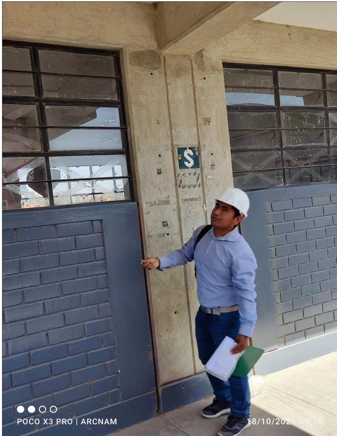
Fig.38 Correcto proceso constructivo del segundo nivel.
