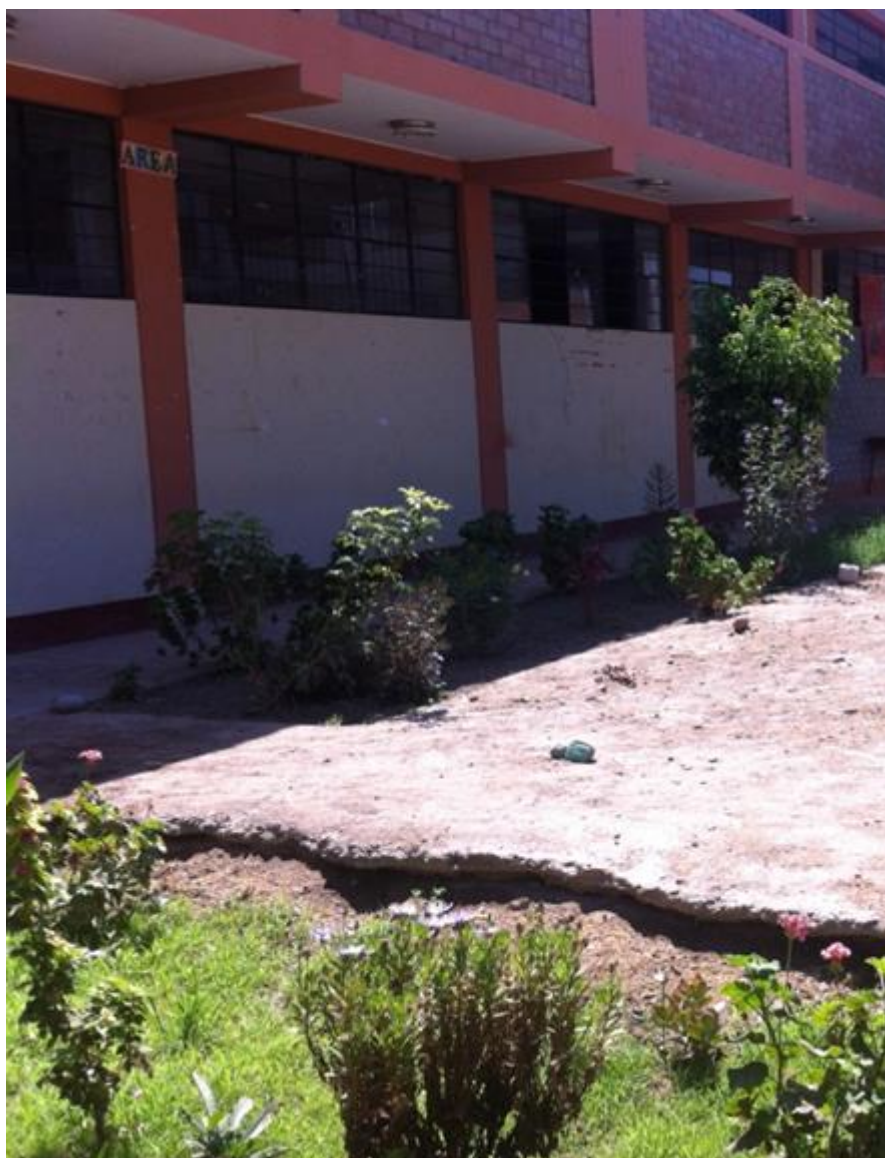
Fig.9 Pabellón de aulas 01 al 09 de la I.E. Fray Ramón Rojas
