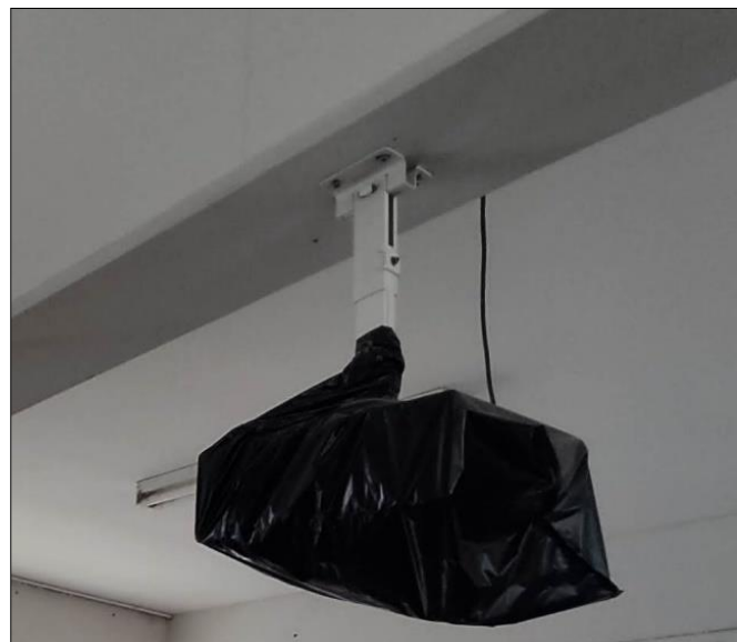
Fig.33 Elementos no estructurales empotrados.
