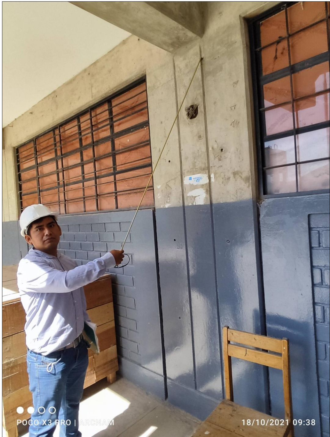
Fig.15 Se aprecia correcto proceso constructivo de elementos estructurales.
