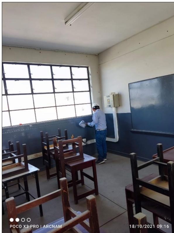
Fig.44 Se observa correcta unión entre losas vigas y columnas.
