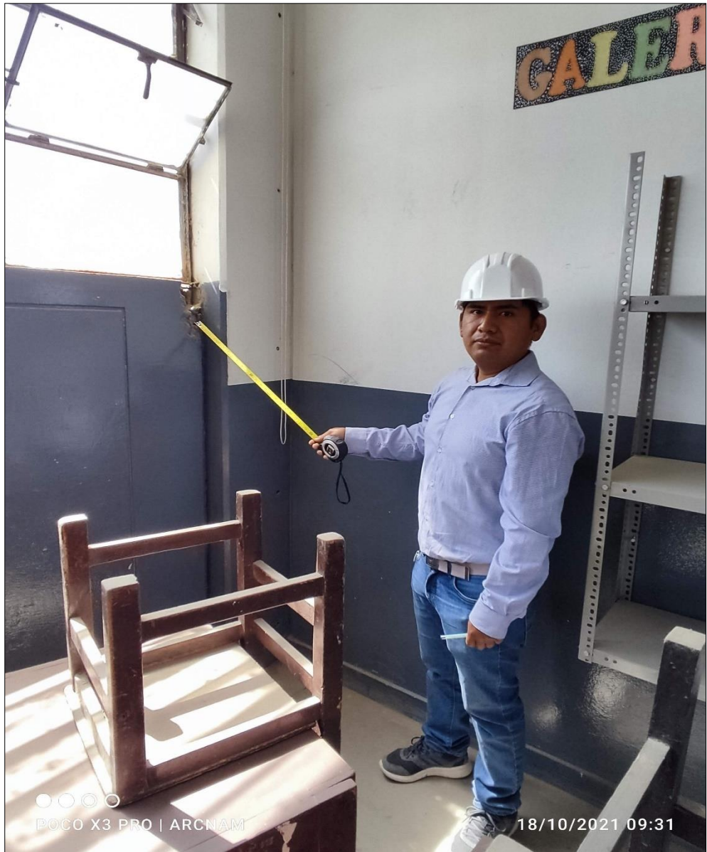
Fig.37 Se aprecia correcta unión entre columnas vigas y muros del segundo nivel.
