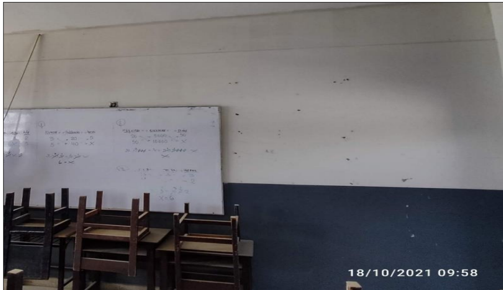
Fig.50 Se aprecia un buen estado de los muros
