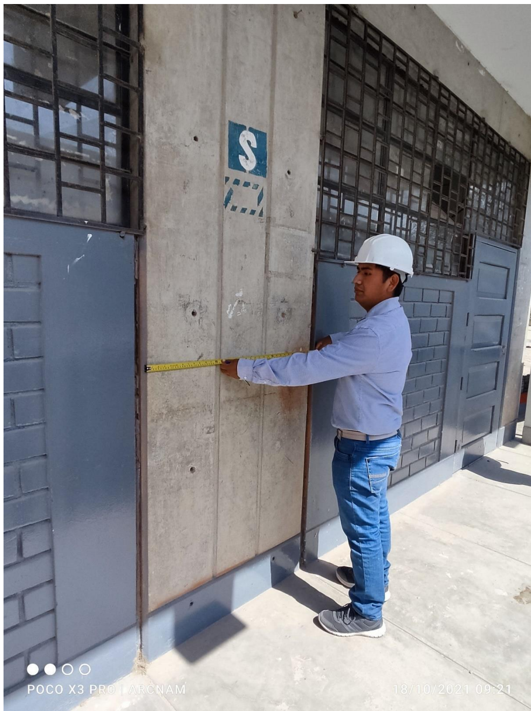
Fig.40 Se observa buen estado del segundo nivel.
