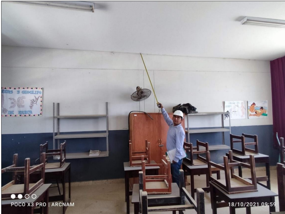
Fig.54 Se aprecia el techo del tercer nivel.
