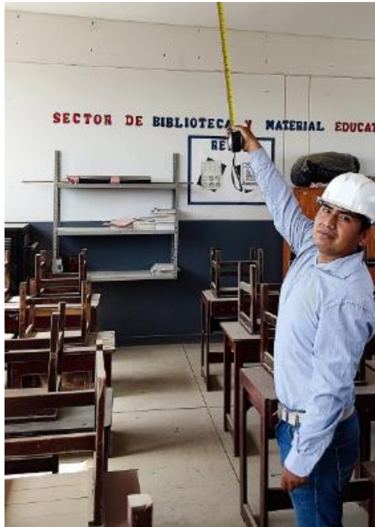
Fig.32 Parte interna de aulas, en buen estado
