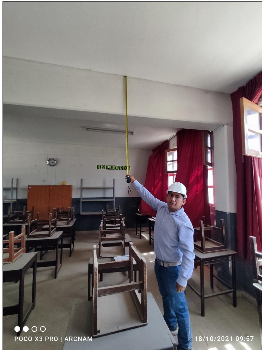
Fig.31 Se aprecia correcta unión entre la losa y vigas.
