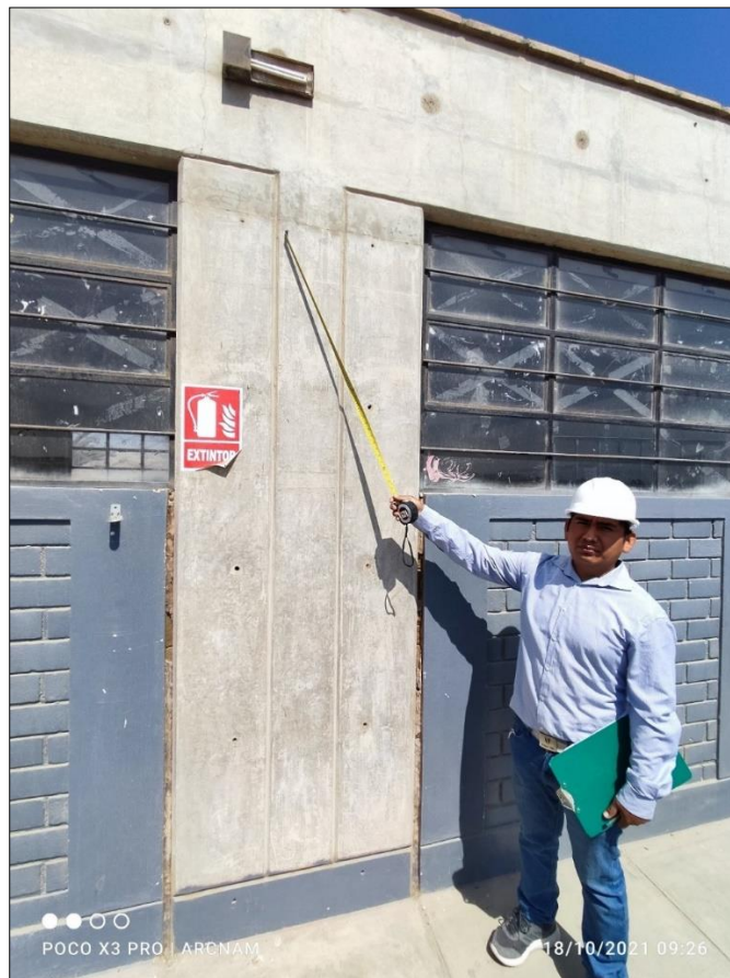
Fig.49 Se aprecia unión adecuada entre elementos estructurales del tercer nivel.
