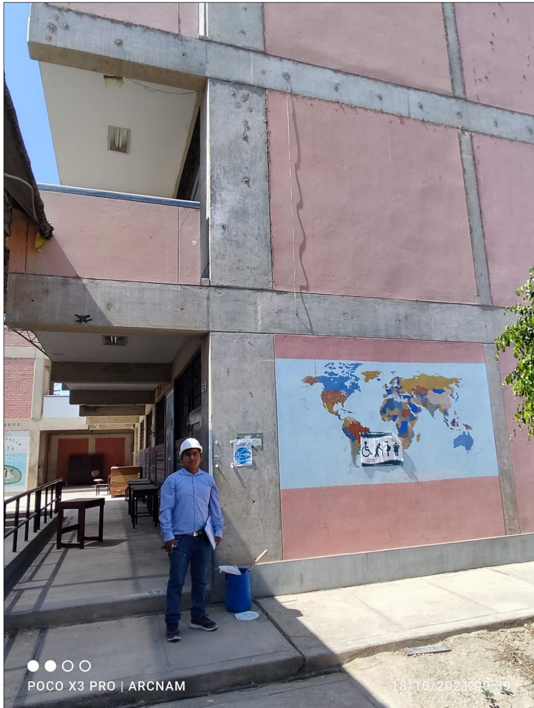
Fig.16 Se aprecia correcto confinamiento de muro portante
