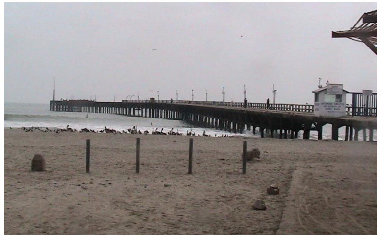
Fig. 19. Vista General del muelle antiguo de Cerro Azul
