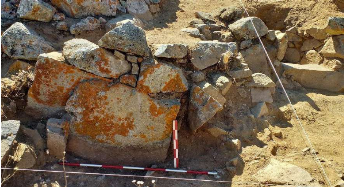
Figura 58. Se observa un segmento del muro de contención 2
