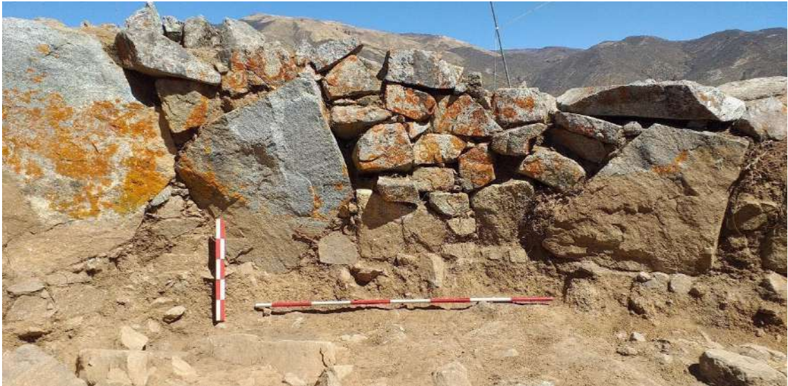
Figura 35. Paramento interno sur de la estructura arquitectónica 03. Se aprecia elementos líticos de gran dimensión conformantes del cimiento y muro
