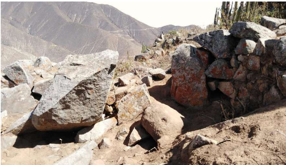
Figura 36. Vano de acceso en donde se observa la existencia de un lítico de gran dimensión en el lado izquierdo de la entrada, posiblemente conformante de la jamba original
