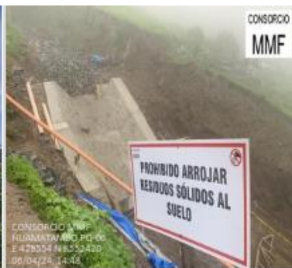
Prohibido arrojas residuos sólidos
