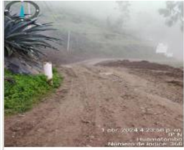
Humectación Natural ingreso a obra
