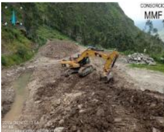
Compactación de material en DME
