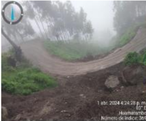
Humectación Natural ingreso a obra
