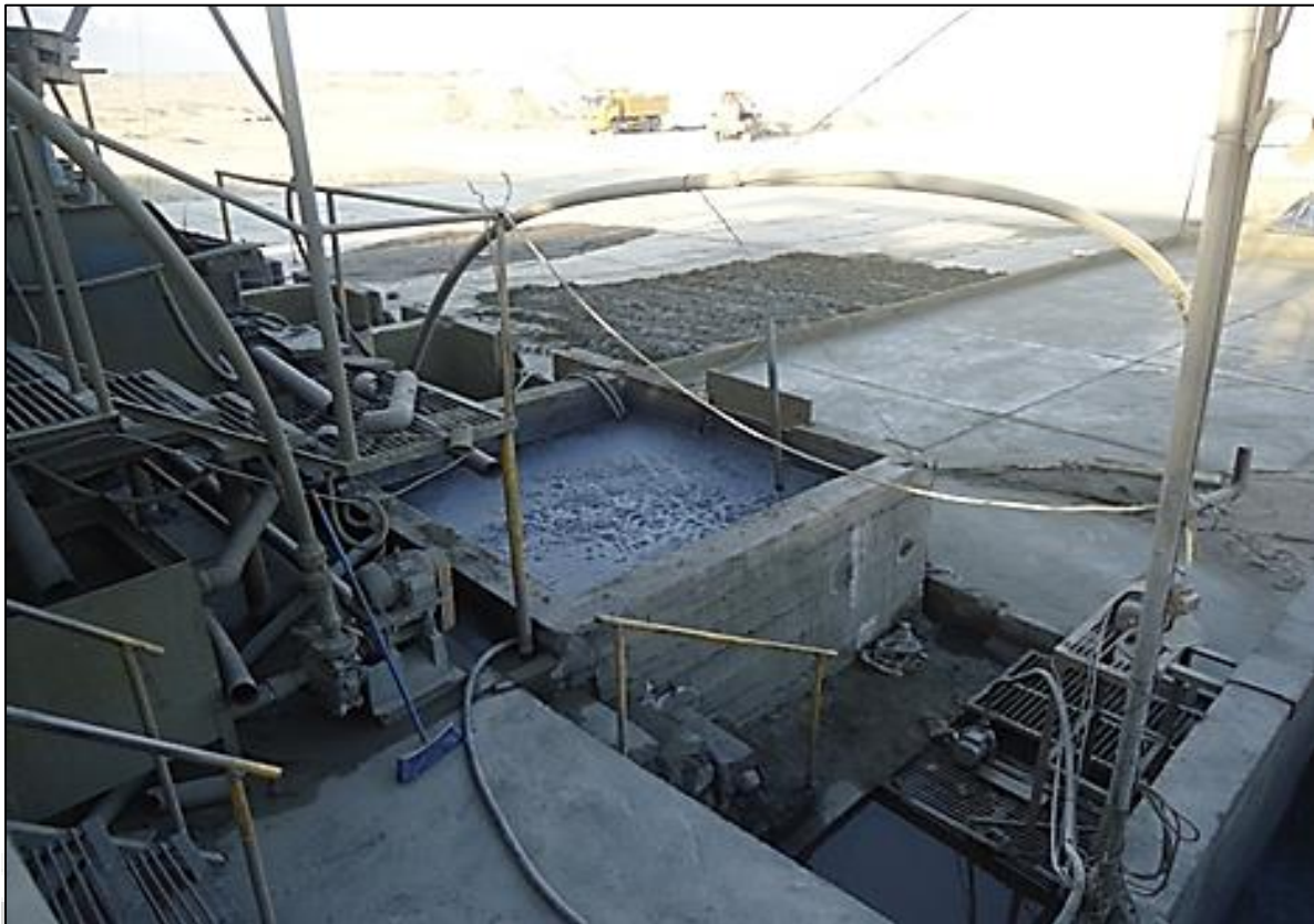
Figura 21: Pozas de sedimentación de concentrado final y cancha de secado de concentrado
