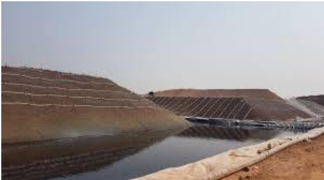
Figura 13. Relaves de la lixiviación ácida de mineral oxidado.
